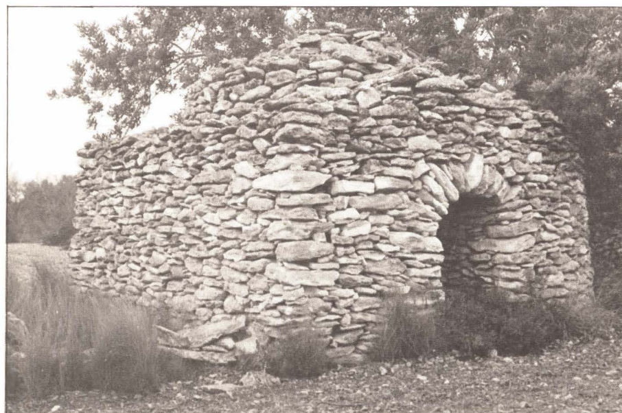
Barraca con cúpula cónica y dintel de arcada
