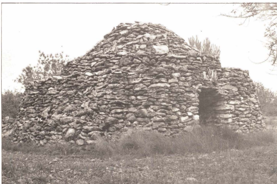
Barraca con cúpula escalonada y dintel
