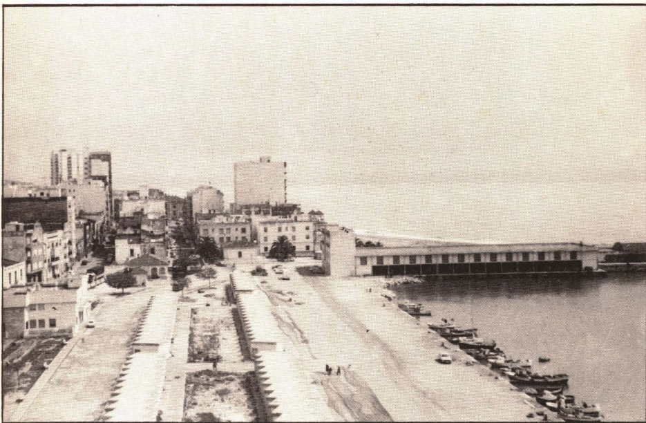
Explanada donde han comenzado los trabajos para la construcción de la nueva lonja.
