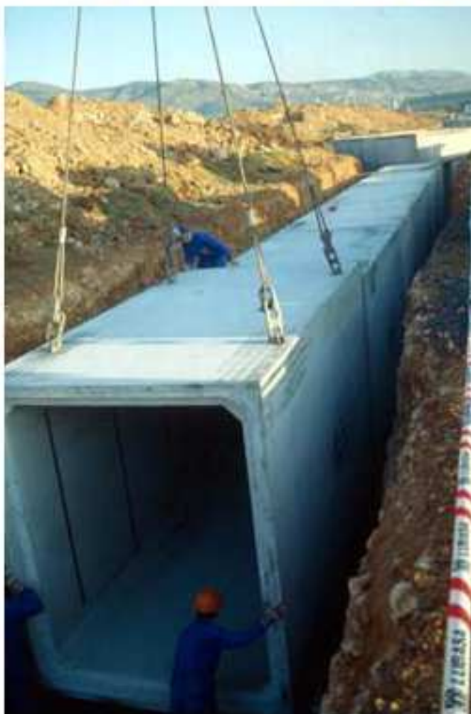
Montaje de módulos
