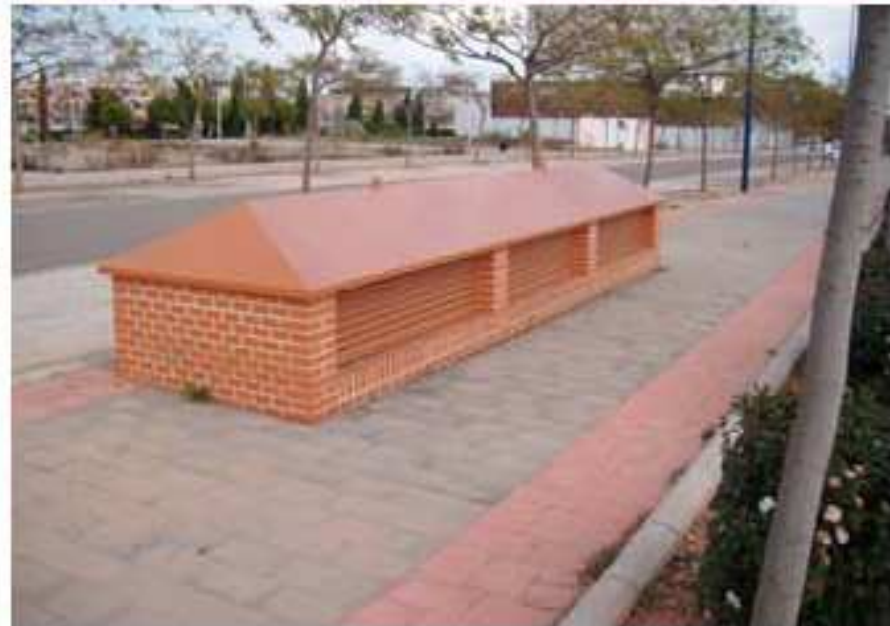
Ventilación y salidas emergencia y materiales
