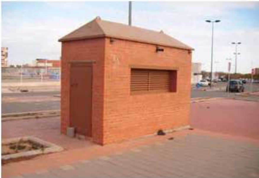
Ventilación y salidas emergencia y materiales
