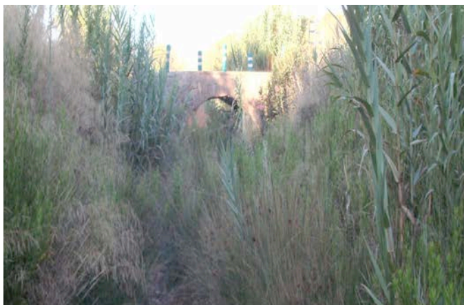
Pont de La Talaia
