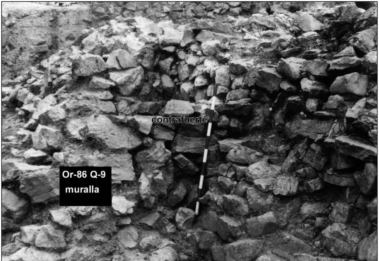
Foto 42.- Detalle de otro de los contrafuertes del paramento amurallado.
