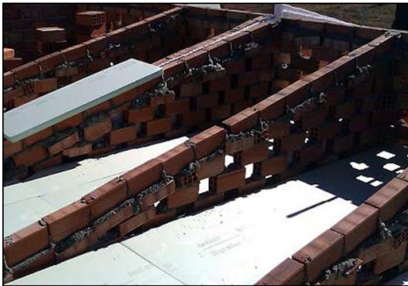
Figura 7.10 Foto del proceso de colocación de aislamiento entre tabiquillos de cubierta.
