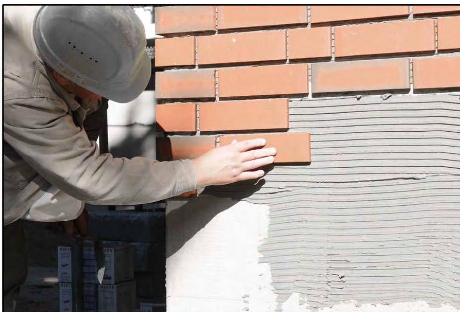
Figura 7.8 Fotos del proceso de acabado del sistema SATE.
