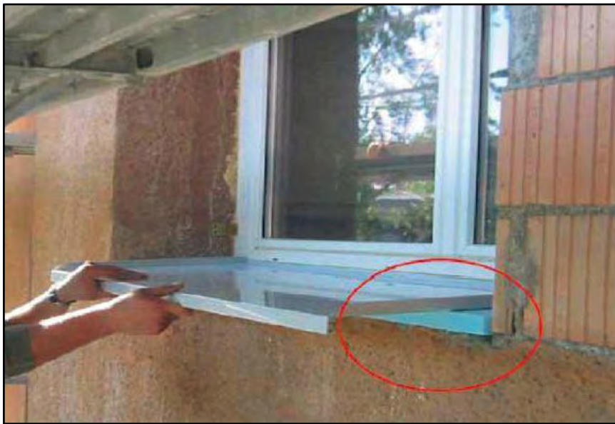
Figura 7.6 Foto del proceso de ejecución del vierteaguas. SATE (Aipex, 2013).
