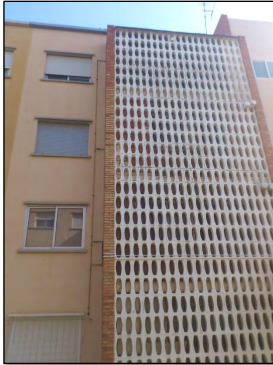
Figura 7.13 Fotografía de una de las tuberías de la preinstalación de gas natural del Bloque H.
