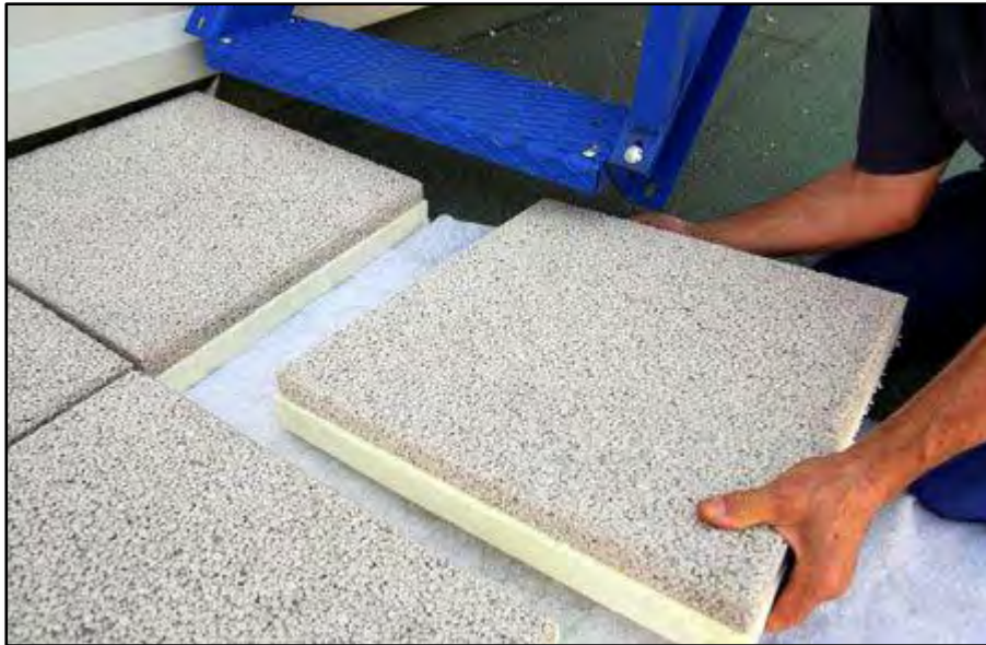
Figura 7.11 Foto del proceso de colocación de losas de hormigón aligerado trasdosadas con XPS.
