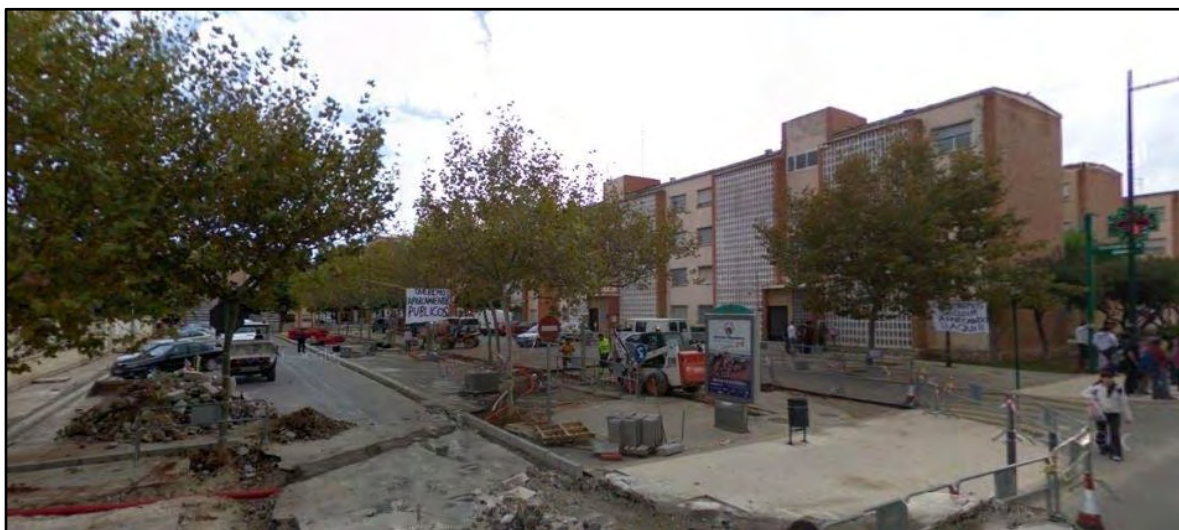
Figura 3.7 Foto del barrio Rafalafena tomada durante las obras de renovación del barrio llevadas a cabo entre 2003 y 2009. Fuente (Google, 2014).
