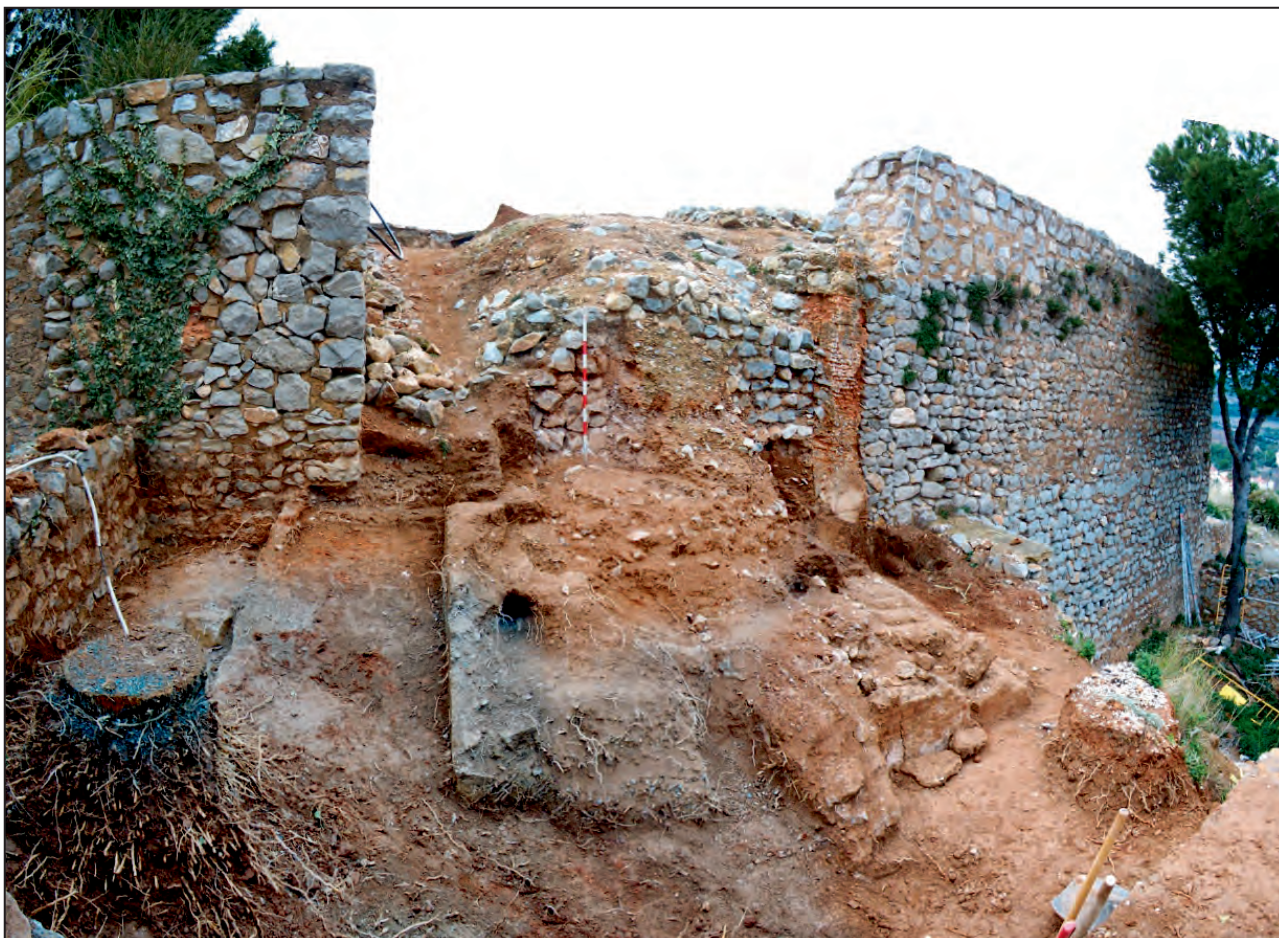
Figura 1. Vista de la torre Nord a l'inici dels treballs d'excavació.
