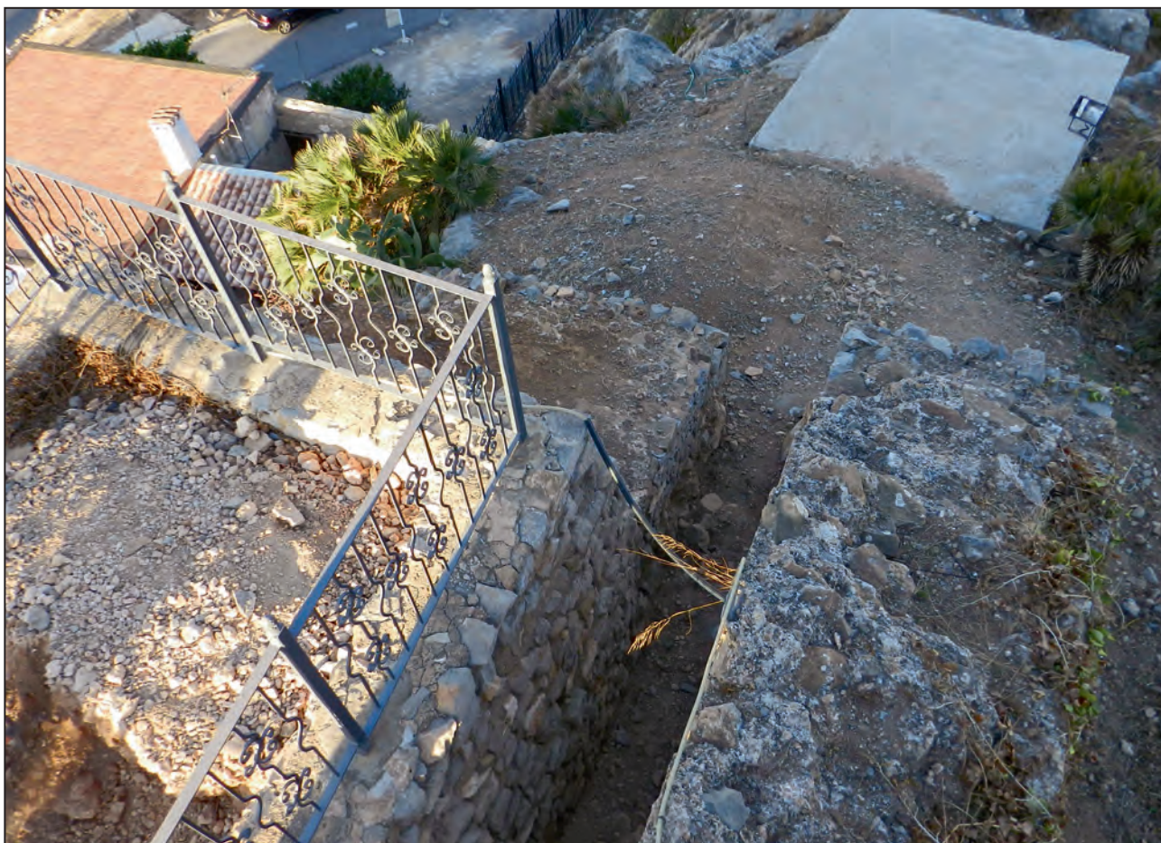
Figura 3. Vista de la torre Sud-oest abans de començar els treballs d'excavació.
