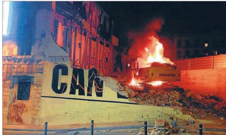
Algunos manifestantes prendieron fuego a la excavadora que lleva a cabo la demolición del edificio
