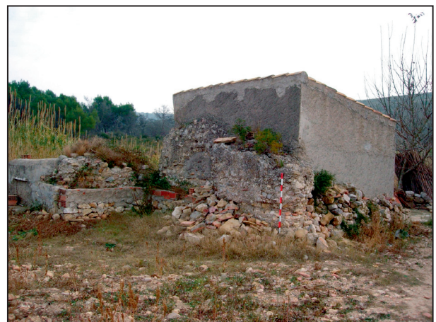
Figura 7. Mur d' opus caementicium conservat al sector I, reaprofitat per a la construcció d'una caseta moderna.
