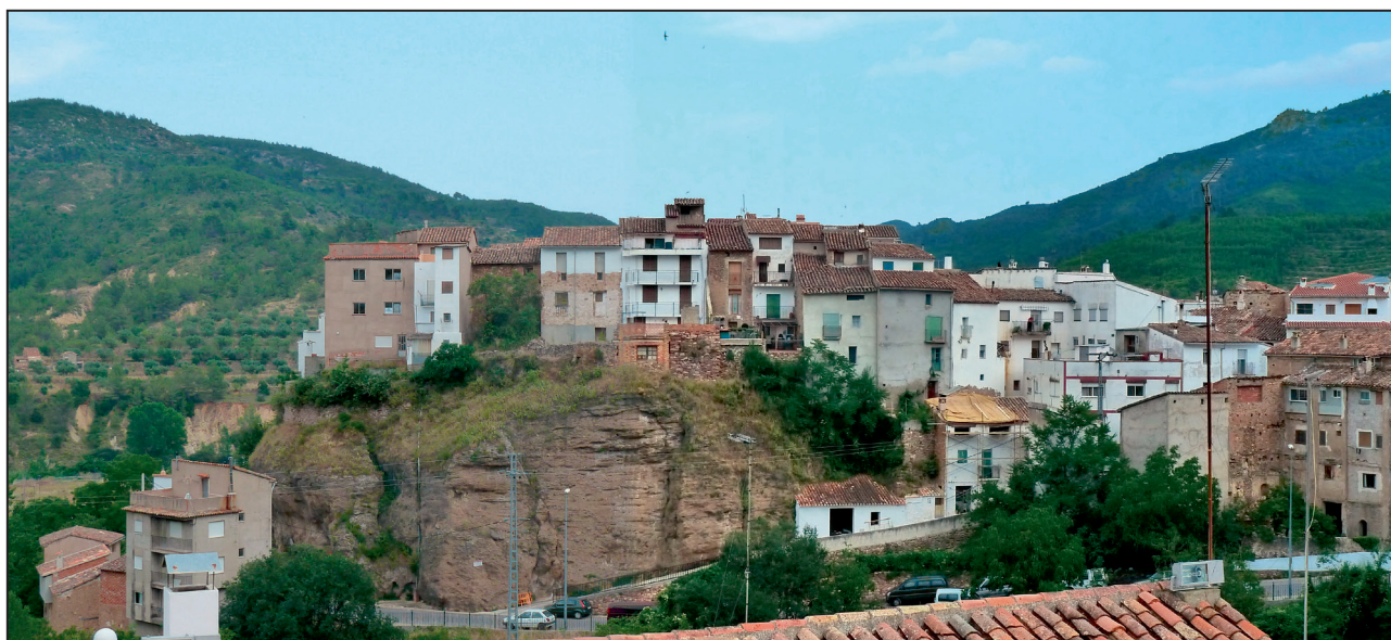
Figura 16. Parte alta del risco en el sector O.
