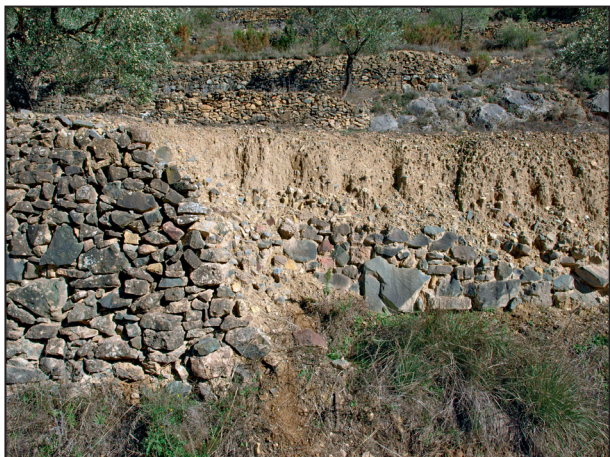
Figura 10. Aterrazamiento desmontado de la partida de Villarroya. Tras de él se ve el zócalo de un muro de mampuestos unido con barro.
