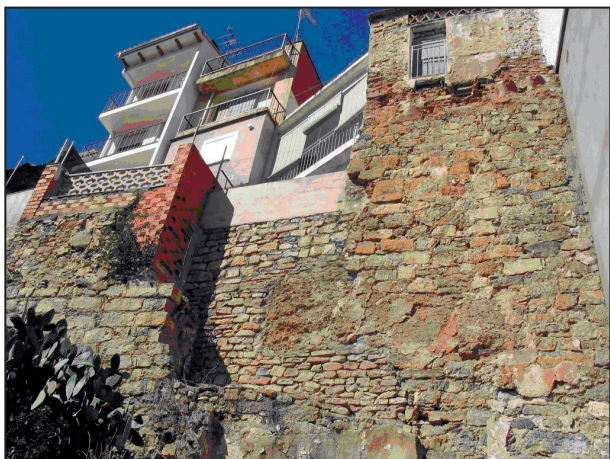
Figura 15. Tramo del lienzo de muralla de la calle de la Cuchara. Sector E.
