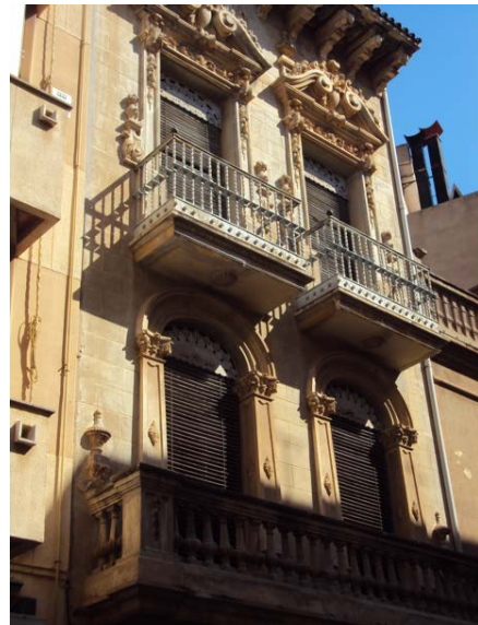
Figura 24. Casa Boix. Calle Mayor
