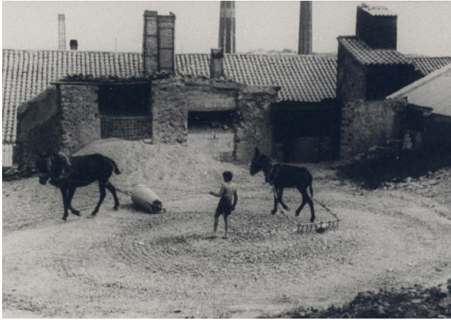
Figura 9. Trituración de la tierra mediante rulos
