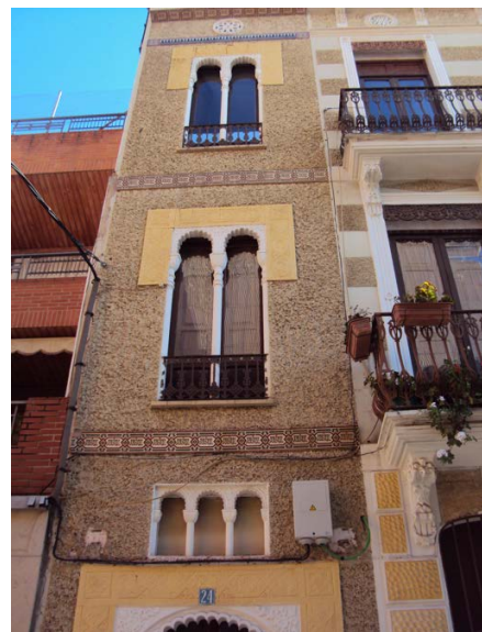
Figura 12. Calle del Agua
