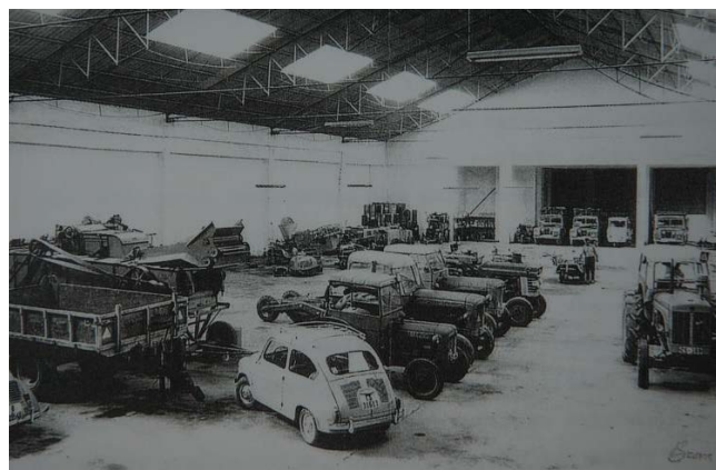
Figura 8. Almacén de la cooperativa S. Isidro en los bajos de las viviendas de la obra social
