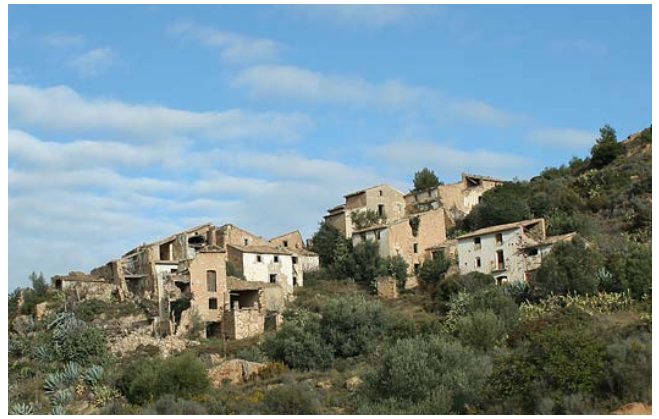
Figura 9. Masía del Rogle, actualmente en ruinas
