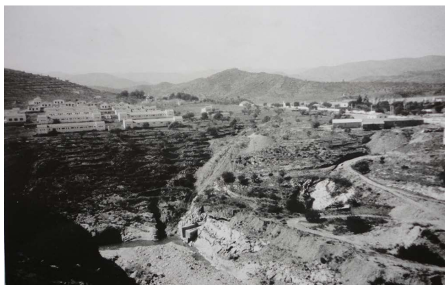
Figura 5. Salida túnel de desvío (año 1952)
