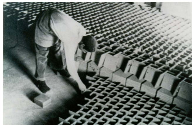
Figura 14. Colocación de los azulejos en T para su secado
