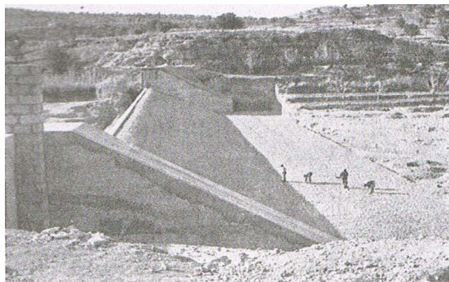
Figura 2. Ataguía de aguas arriba (año 1950)
