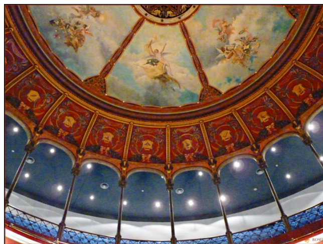
Figura 17. Paraíso y bóveda
