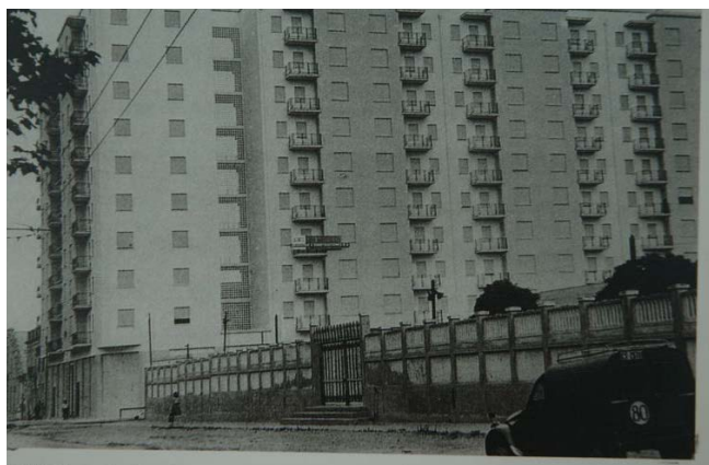
Figura 9. Viviendas de la obra social
