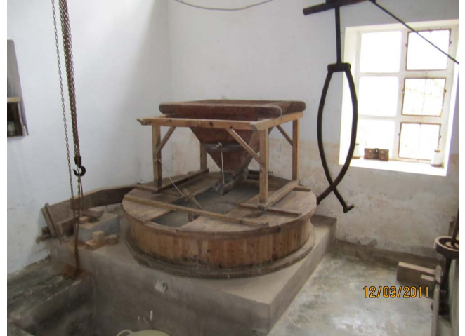
Figura 13. Sala de maquinaria: muela
