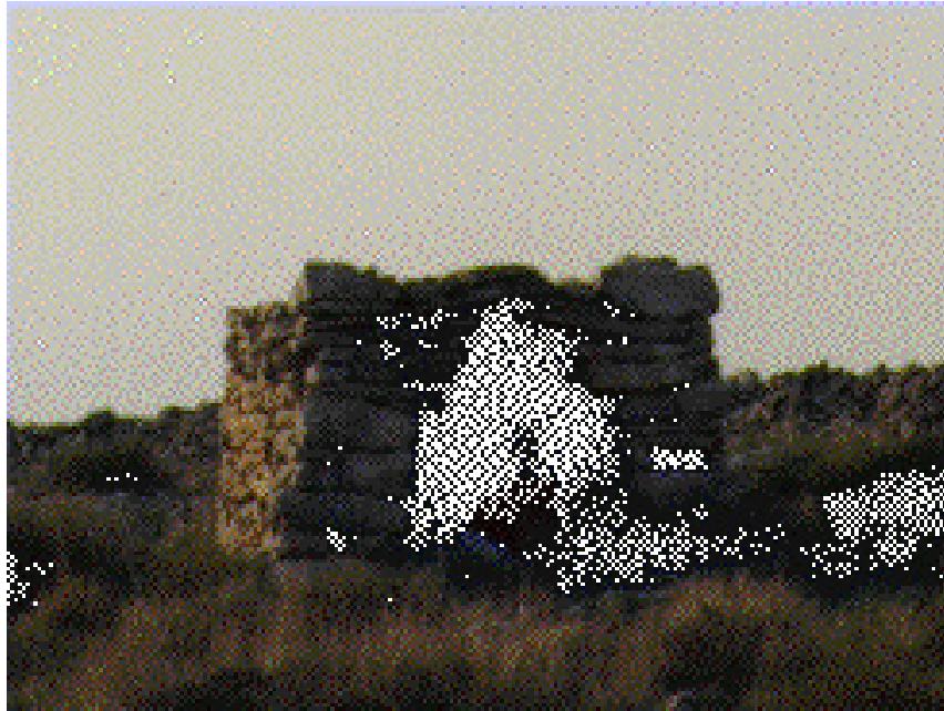
FOTO 6: Fora de classificacions. Exemplant petit molt curiós. Construït a falsa cúpula però amb la coberta plana. Planta rectangular. Entrada per aproximació de filades. Mas del Boiro.
