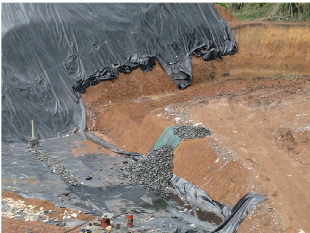
Figura 4. Construcción del vaso de un vertedero
