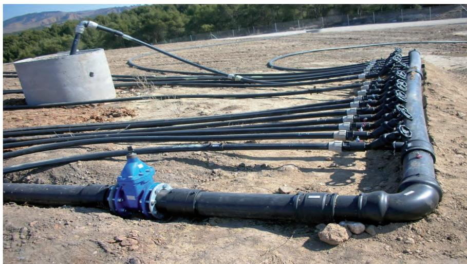
Figura 27. Tuberías de captación primarias para la evacuación de biogás en un vertedero de España
