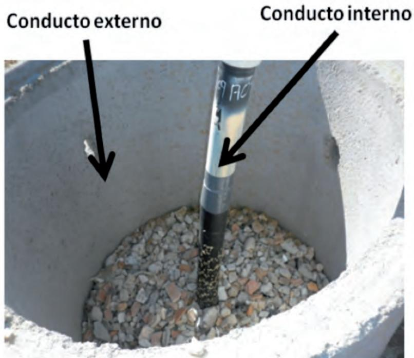
Figura 31. Tuberías de captación para la valorización de biogás en un vertedero de España
