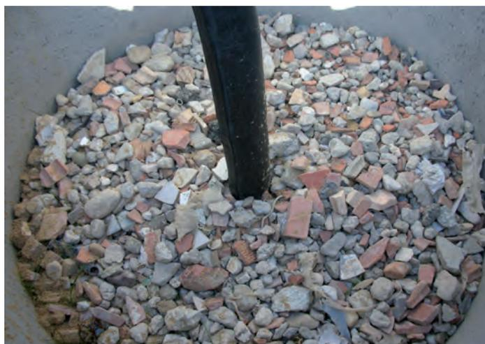
Figura 30. Áridos en un pozo de captación de biogás de un vertedero de España
