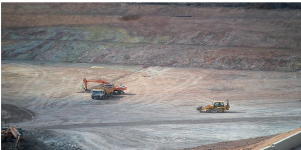
Figura 20. Construcción del canal de evacuación de lixiviados en un vertedero de España
