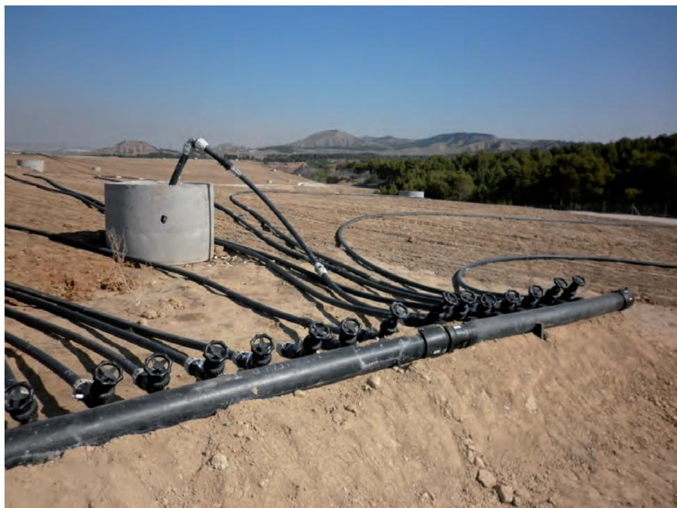
Figura 24. Pozos de captación y conducciones primarias de un vertedero de España
