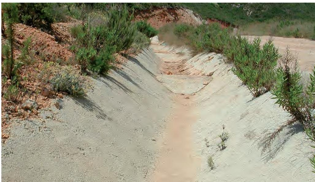
Figura 16. Cuneta interior de evacuación de pluviales
