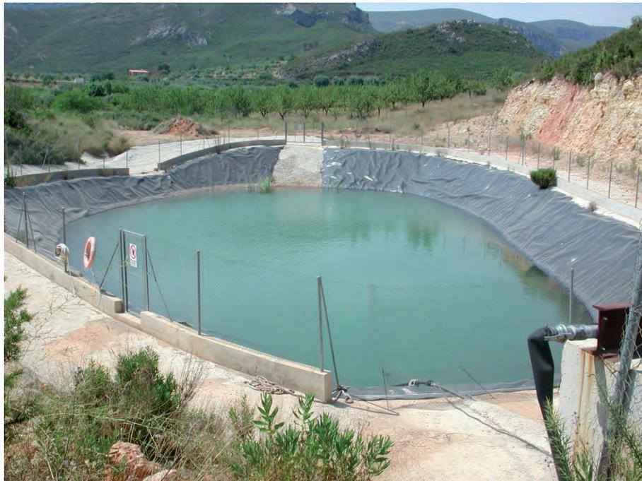
Figura 18. Balsa para la acumulación de pluviales dentro del recinto del vertedero
