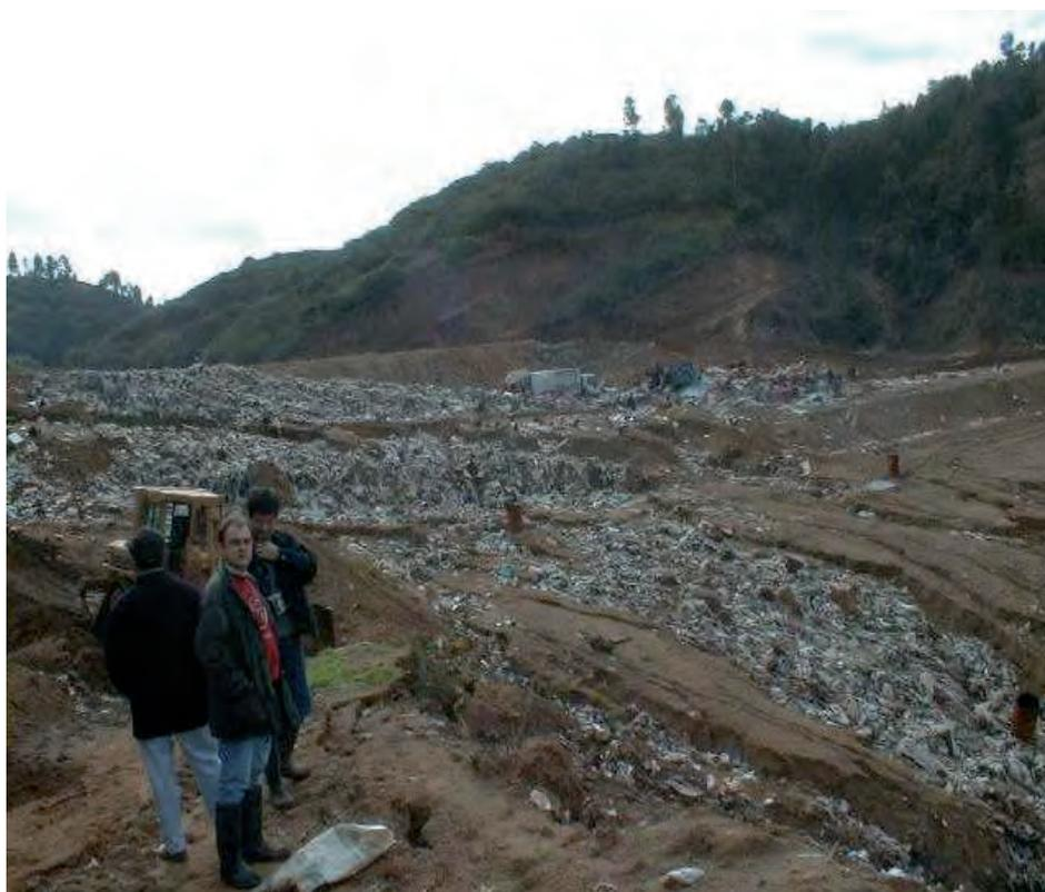
Figura 14. Arrastre del material de cobertura de un vertedero ocasionado por la ausencia del canal de evacuación de pluviales
