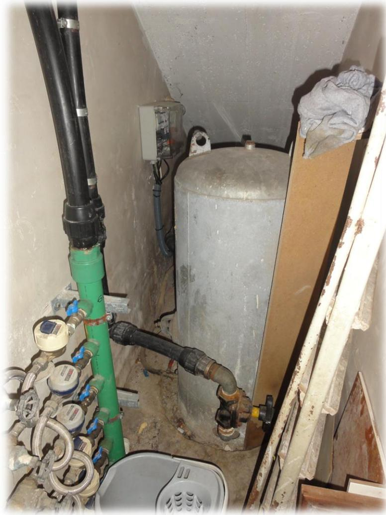
Figura 11. Contadores, bombas de presión y dispositivo regulador (Propia).
