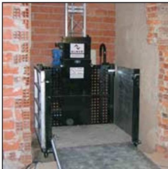
Imagen 22: Montacargas de cremallera en hueco de ascensor
