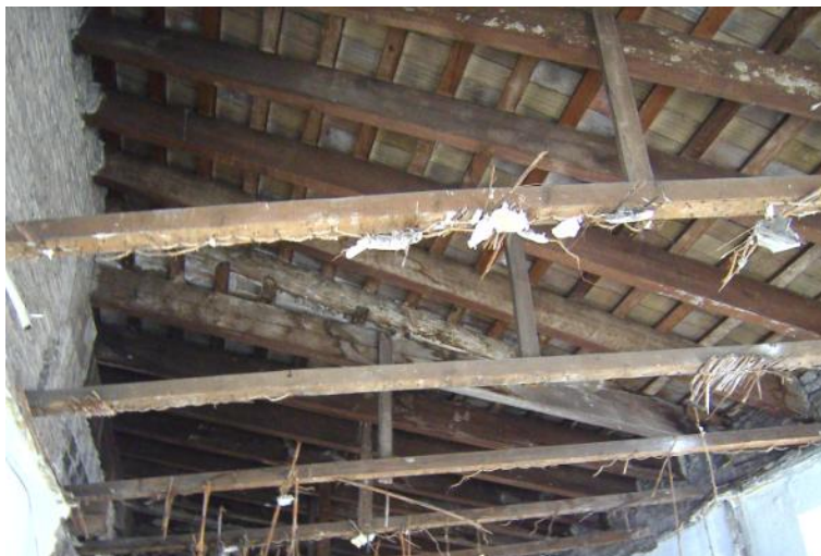
Fig.6.1.12 Vista cubierta del edificio situado en Plaza Árbol desde el interior tras la eliminación del falso techo de cañizo que estaba adherido a las cerchas de madera que discurrían hasta llegar al muro de fachada. (Fuente: Lucas Blancas)
