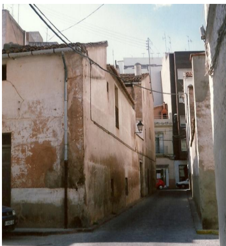
Fig.6.1.1 Edificación vista desde la c/ Bravo donde se observan los diferentes niveles mencionados. (Fuente: VNB Arquitectos)
