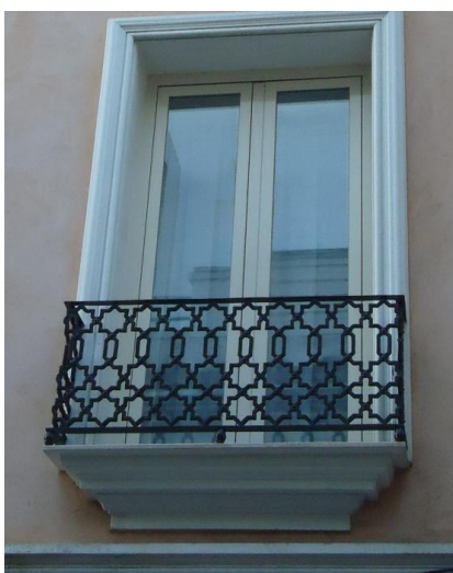
Fig. 4.53 Barandillas de ventanas planta primera y segunda del edificio localizado en c/Cami Real (Sagunto)
