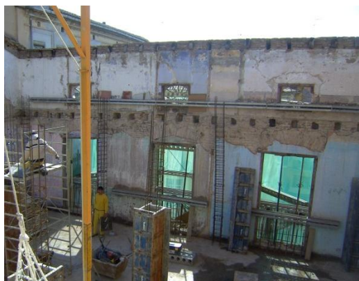
Fig.6.2.33 Correas interiores durante el hormigonado de los pilares de planta segunda, donde se eliminan aquellos tramos de la viga que interferían con los pilares adyacentes al muro. (Fuente: Lucas Blancas)
