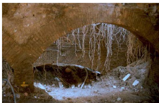
Fig.4.13 Cimentación existente de los muros perimetrales de Caixa Fòrum – Barcelona. (Fuente: David Lladó i Porta).
