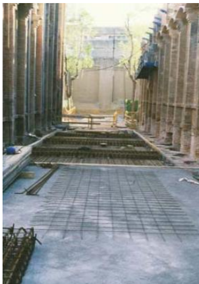
Fig.5.2.33 Losa ejecutada a nivel de planta baja entre la superficie existente entre dos muros laterales (Fuente: David Lladó i Porta)
