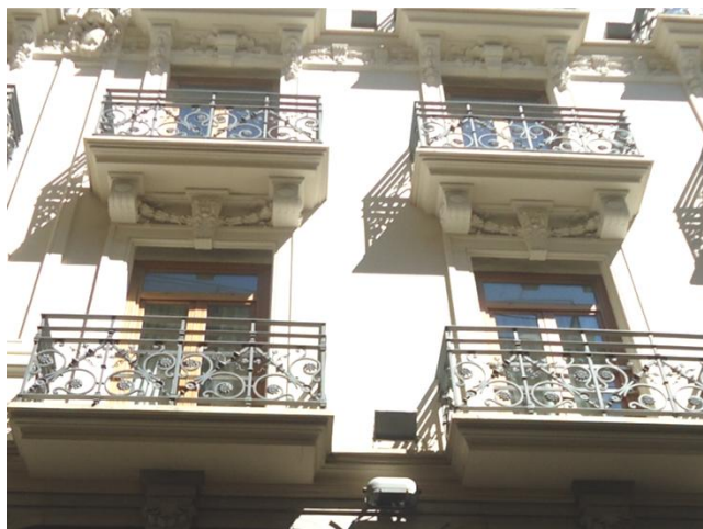
Fig.4.38 Recercados planos en antiguo Hotel Palace (Valencia) que se unen mediante la clave con las piezas de decoración de debajo de los balcones.
