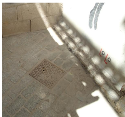
Fig.6.3.15 Red municipal aguas potables situada paralelamente a la fachada y en perpendicular al tapiado de los huecos de paso existentes entre el estabilizador y la fachada.
