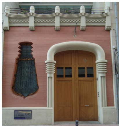
Fig.4.37 Fachada edificio Hidrola tras la intervención.
