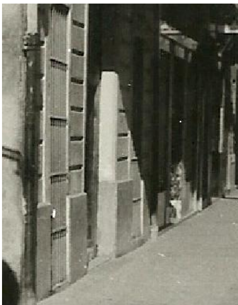
Fig.6.1.5 Revestimientos planta baja alrededor del año 1965 (Fuente: María José Ferrer Casares)
