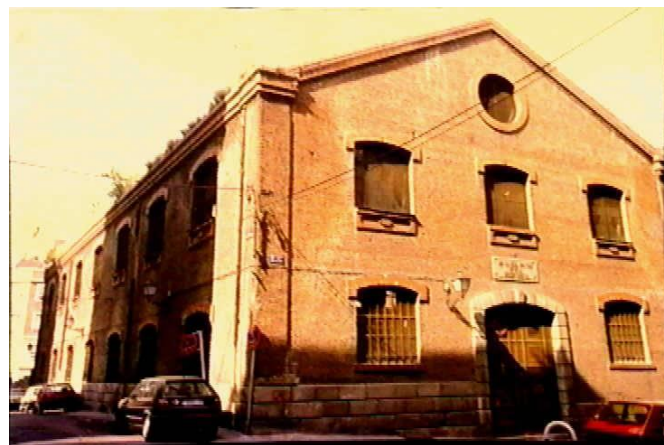
Fig.4.1 Antigua Central Eléctrica del Mediodía – Madrid (Fuente: Ayuntamiento de Madrid)
