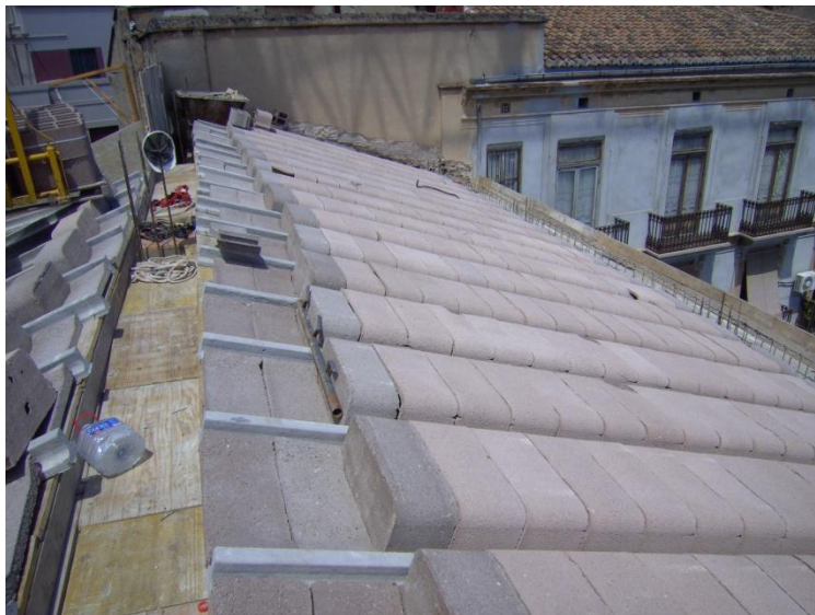
Fig.6.2.41 Elementos del forjado de cubierta, antes de la disposición del molde de poliestireno que daría forma a la cornisa. (Fuente: Lucas Blancas)
