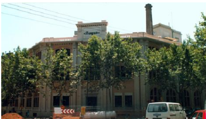
Fig. 4.36 Fachada de la antigua fábrica Bayer antes de la intervención (Fuente: Ajuntament de Barcelona)
