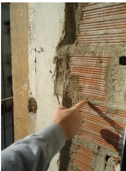
Fig.6.2.50 Indicación recibida durante una visita a obra, de hasta donde llegaba el muro de fachada.
