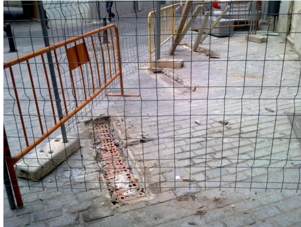
Fig. 6.3.8 Retirada del mobiliario urbano dispuesto enfrente de la fachada principal (Fuente: Lucas Blancas)
