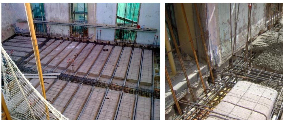
Fig.6.2.32 Forjado planta primera (Fuente: Lucas Blancas)
