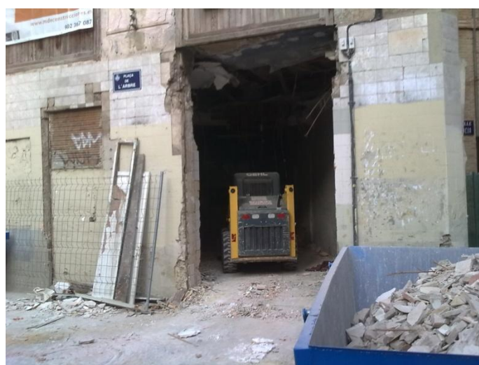
Fig.6.3.23 Retirada del material depositado en planta baja hasta el contenedor para su posterior retirada (Fuente: Lucas Blancas)
