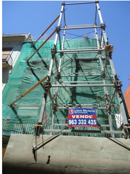
Fig.5.2.10 Estabilizador con puntales Multiprop en c/Serranos (Valencia)
