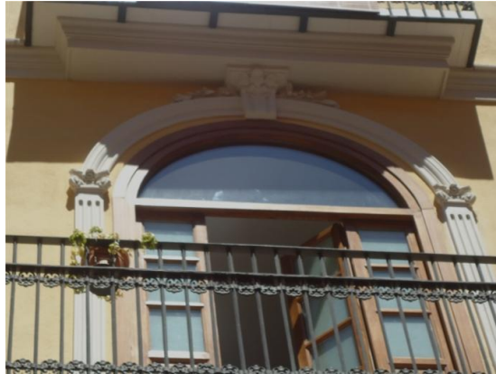
Fig. 4.39 Molduras en forma de pilastras coronadas por capiteles sobre los que apoya el arco moldurado conformando el recercado de los huecos de la planta primera del edificio situado en c/Santo Tomas (Valencia)
