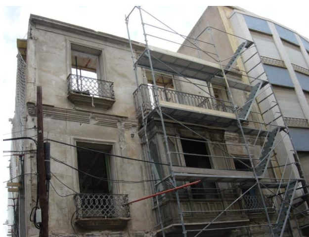
Fig.6.1.15 Vista de los huecos practicados en la fachada que ya se encuentran retacados, durante la ejecución del forjado de planta tercera donde ya se había desmontado el andamio estabilizador. (Fuente: Rosa Lapiedra Alcamí)
