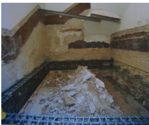
Fig. 5.2.22 Demolición de la escalera ubicada en el recinto formado en la portada Jorge Juan para ejecutar el encepado interior y la losa (Martínez Díaz, et al., 2004).
