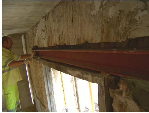
Fig.6.2.44 Operario rellenando el hueco producido para alojar el perfil. (Fuente: Lucas Blancas)
