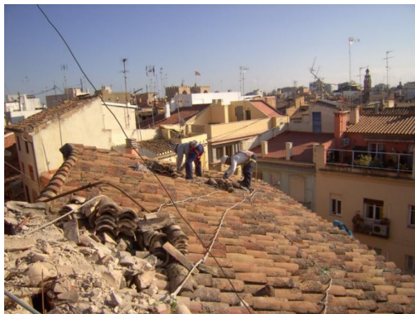
Fig.6.3.21 Operarios desmontando la cubierta desde un punto central amarrados a un punto seguro mediante el arnés y mosquetón de seguridad (Fuente: Lucas Blancas).
