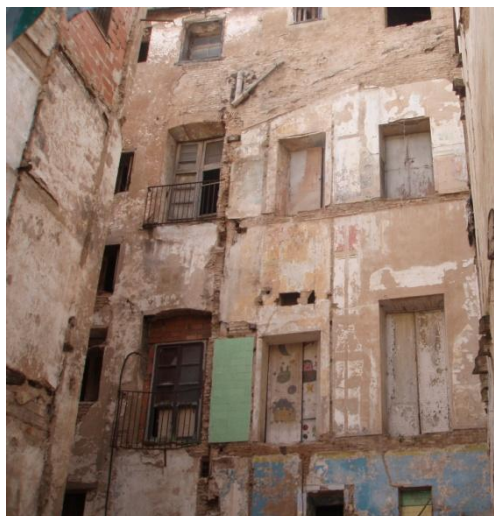
Fig.6.2.11 Fachada trasera antes de la demolición. (Fuente: Lucas Blancas)
