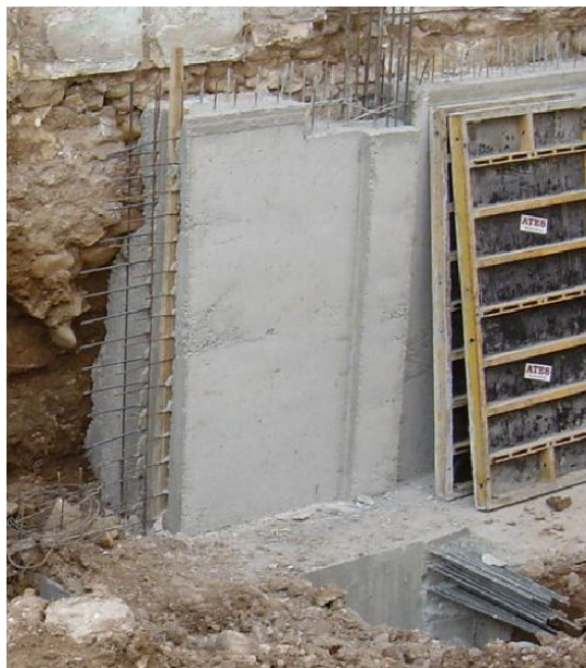
Fig.6.1.14 Se observa el tablón de madera mencionado colocado en vertical que al retirarse creará un hueco que favorecerá la cohesión entre el batache que se observa y el colindante. (Fuente: Rosa Lapiedra Alcamí)
