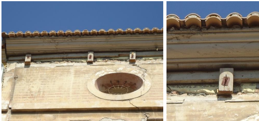
Fig.6.2.39 Tabla del encofrado de la viga de la figura 6.2.37 que no ha sido retirada aún.
