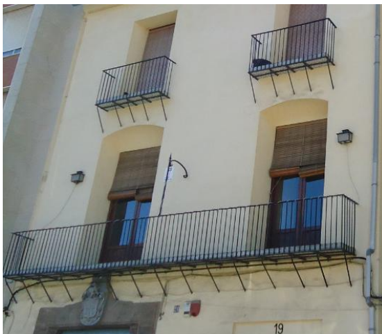
Fig. 4.49 Balcones resueltos mediante bandeja metálica y tornapuntas en plaza Cronista Chabret nº19 y nº20
