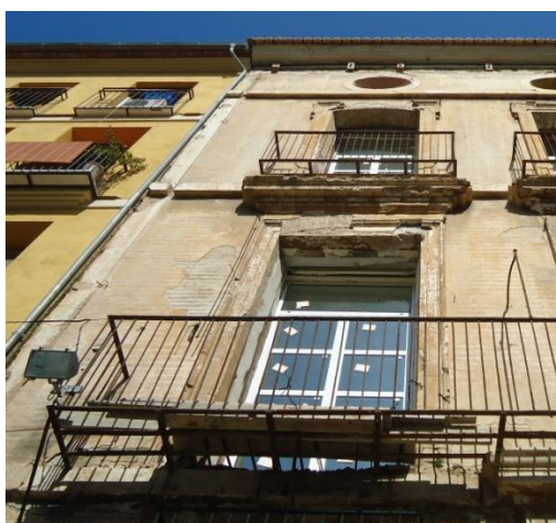
Fig.6.2.34 Mismo balcón de la figura 6.2.33 por el exterior.
