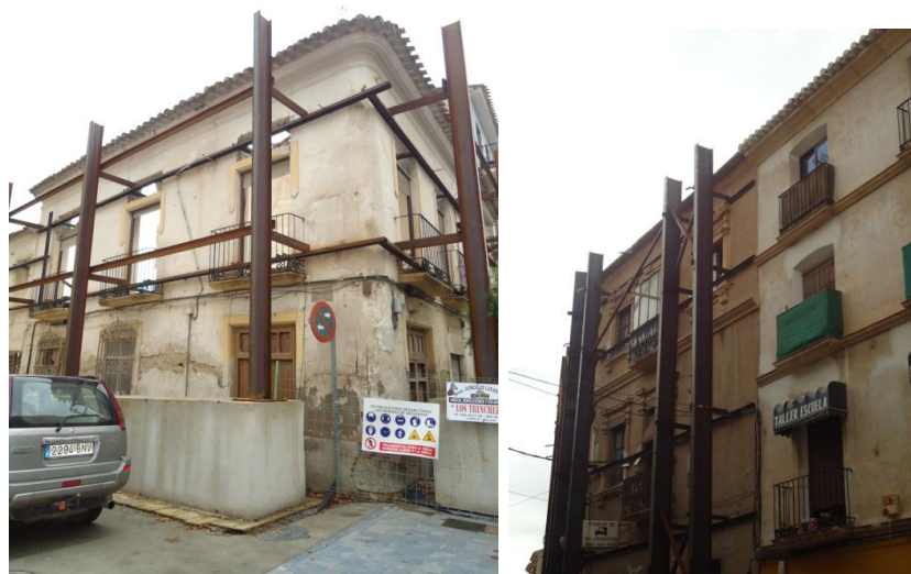
Fig.7.1 Sistemas de estabilización de las fachadas formados por perfilaría metálica y contrapesos de hormigón ubicados en Lorca (Murcia).
