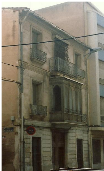
Fig.6.1.3 Fachada antes de la intervención. (Fuente: VNB Arquitectos)
