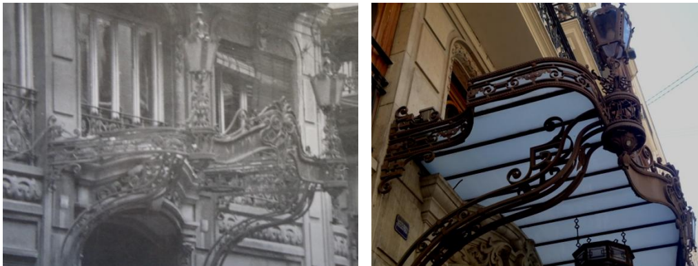
Fig 4.54 Fig 4.50 Marquesina en 1981 (COACV, 1981) y marquesina en 2013 del antiguo Hotel Palace actual Hotel Vincci (Valencia).
