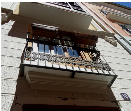
Fig.4.50 Balcón ejecutado mediante bandeja metálica apoyado en ménsula de fábrica en edificio c/Santo Tomas (Valencia)
