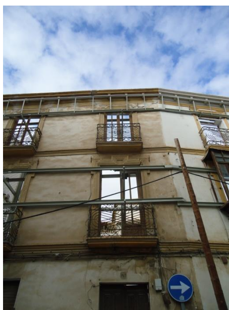
Fig. 7.2 Vigas UPN evitando el vuelco de una fachada en Lorca (Murcia) y logrando el apuntalamiento de la cornisa mediante la disposición de angulares L entre las correas formadas por los UPN.
