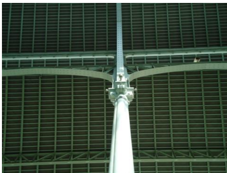
Fig.4.9 Columna de fundición del Mercado Colón donde descansan los arcos y las cerchas que soportan la cubierta.
