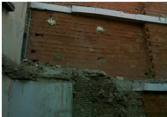
Fig.6.3.24 Muro medianero del edificio colindante y muro de la edificación actual durante el proceso de demolición. (Fuente: Lucas Blancas)
