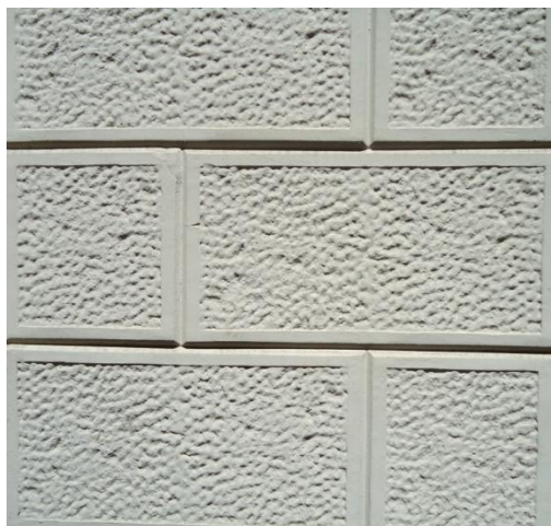
Fig.4.33 Revoco a la catalana de acabado picado con plinto a modo de imitación de silería en fachada localizada en c/Santo Tomas Valencia.
