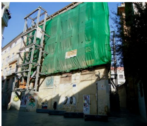
Fig 6.3.1 Estado actual de las obras.
