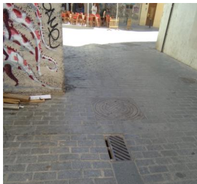
Fig.6.3.14 Red de alcantarillado público que discurre por la c/Santo Tomas hasta llegar a la plaza.
