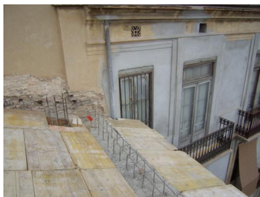
Fig.6.2.38 Entablado sobre el que apoyarían los elementos del forjado de cubierta tras su ejecución. (Fuente: Lucas Blancas)
