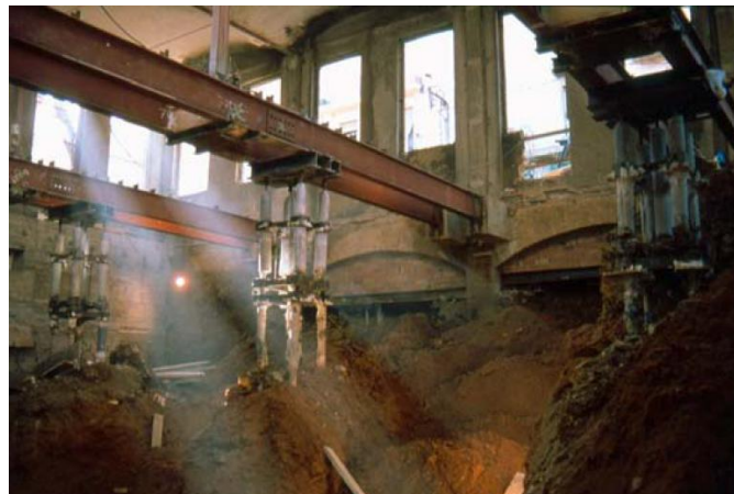
Fig.5.2.32 Imagen tomada durante la excavación (Fuente: David Lladó i Porta)
