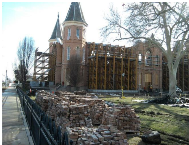
Fig.4.6 Estabilizadores de fachada y acopio de materiales recuperados (Fuente: Anónima)
