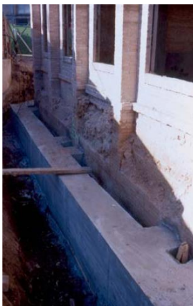
Fig.5.2.29 Muro pantalla exterior ya hormigonado con la penetración de las ménsulas hacia el interior del edificio (Fuente: David Lladó i Porta)
