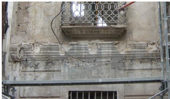
Fig.6.1.16 Fotografía de la rotura de la moldura a nivel de planta primera para crear las conexiones con el forjado. (Fuente: Rosa Lapiedra Alcamí)
