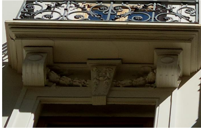
Fig. 4.44 Guirnaldas que conectan las ménsulas de debajo de los balcones del antiguo Hotel Palace actual Hotel Vincci (Valencia)
