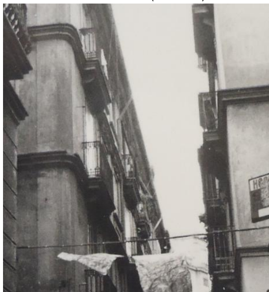
Fig.4.50 Balcón ejecutado mediante bandeja metálica apoyado en ménsula de fábrica en edificio c/Santo Tomas (Valencia)
