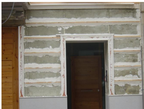
Fig.6.1.22 Junquillos y bardos colocados para dar forma al revoco de planta baja. (Fuente: Rosa Lapiedra Alcamí)
