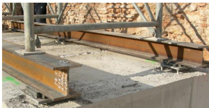
Fig.5.2.9 Detalle de la ejecución de la unión entre el contrapeso y el estabilizador (Fuente: Cimbra Andamios).
