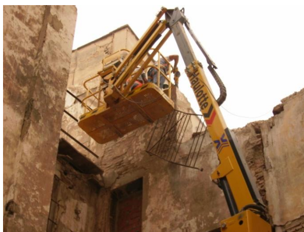
Fig.6.2.26 Operario eliminando el muro mediante el uso de martillo neumático desde la plataforma elevadora. (Fuente: Lucas Blancas)
