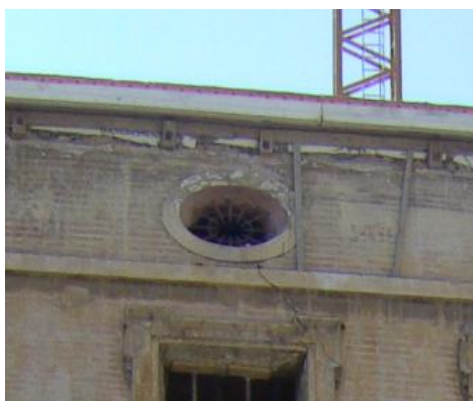
Fig.6.2.42 Molde de poliestireno expandido antes de su retirada. La posición del mismo se mantiene en este momento gracias al adhesivo para molduras. (Fuente: Lucas Blancas)
