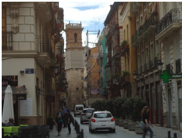
Fig.4.4 Estabilizador ubicado en la c/ Serranos desde hace aproximadamente 5 años.
