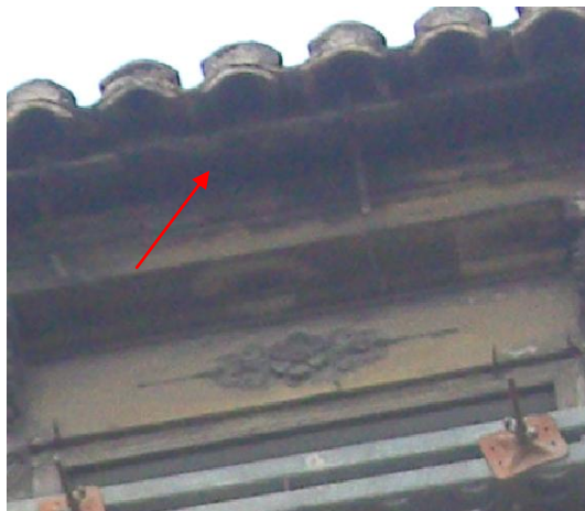
Fig.6.3.29 Alero antes de su demolición (Fuente: Lucas Blancas)
