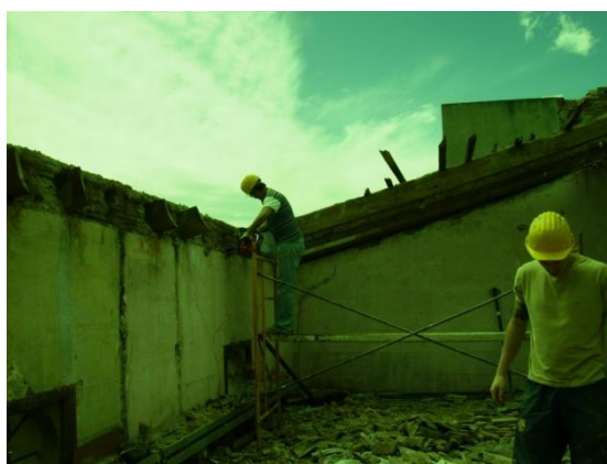
Fig.6.2.25 Eliminación de las viguetas (Fuente: Lucas Blancas)
