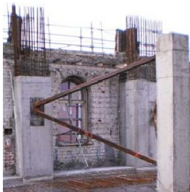
Fig.5.2.4 Última planta del hotel Cismigiu donde se aprecia la estructura estabilizadora creada. (Fuente: Solano & Catalán, Arquitectura e Ingeniería)
