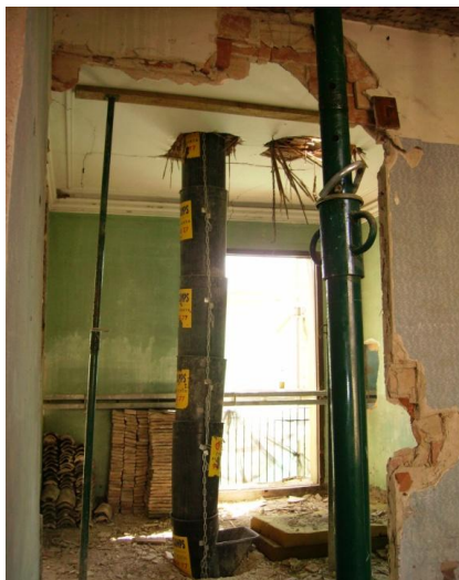
Fig.6.2.23 Tubo de escombros y hueco producido al retirar la carpintería. (Fuente: Lucas Blancas)
