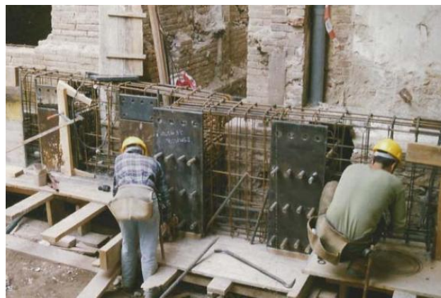
Fig.5.2.31 Armado de la viga por el exterior de los muros laterales (Fuente: David Lladó i Porta)
