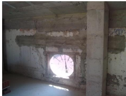
Fig.6.2.45 Refuerzo del dintel de los vanos con forma de ovalo. (Fuente: Lucas Blancas)
