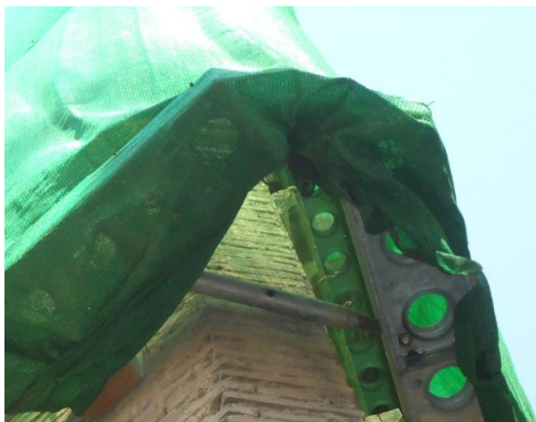
Fig.6.3.12 Tensor Super Slim nexo de unión entre las correas horizontales de ambas fachadas.
