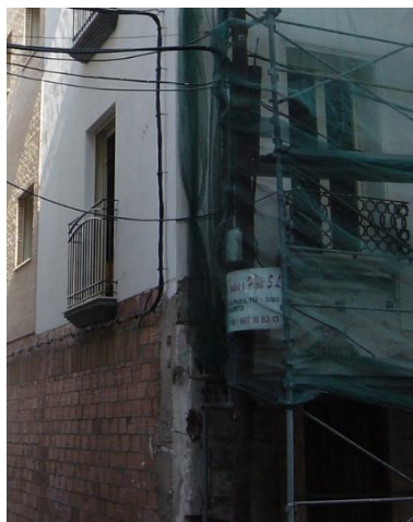
Fig.6.1.21 Fachada revocada a excepción de planta baja. (Fuente: Rosa Lapiedra Alcamí)
