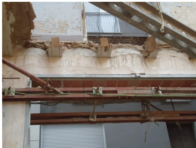
Fig.4.7 Viguetas de madera de escuadría rectangular, que configuraban la estructura existente de la edificación localizada en c/Torn de L'Hospital (Valencia), embebidas en el muro de fachada.
