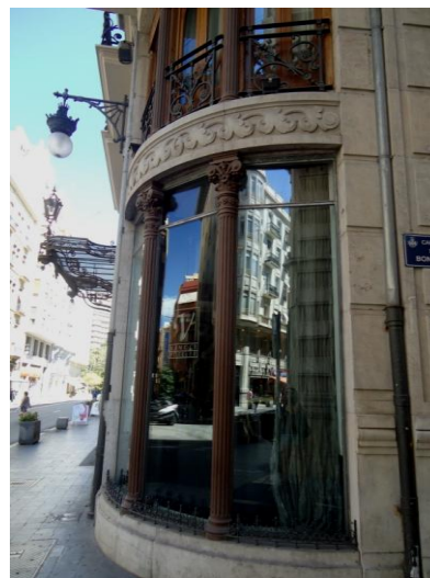
Fig.4.55 Pilares de fundición coronados con capitel con volutas en los ventanales de la esquina del Hotel Vincci (Valencia)
