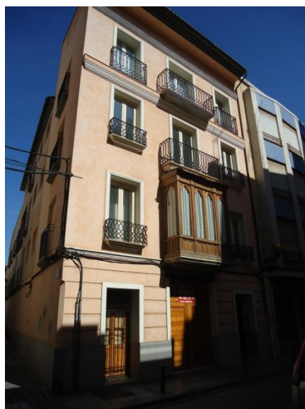
Fig. 4.20 Edificio en c/Cami Real (Sagunto) donde se aumenta el nivel de plantas existentes de la primera crujía en un nivel más recreándose por tanto la fachada protegida en un nivel.
