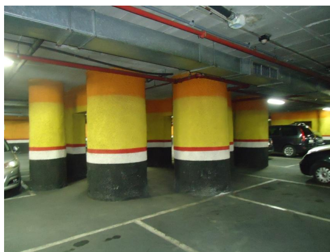
Fig.5.2.26 Estado actual de los pilotes ubicados en la planta del primer sótano.
