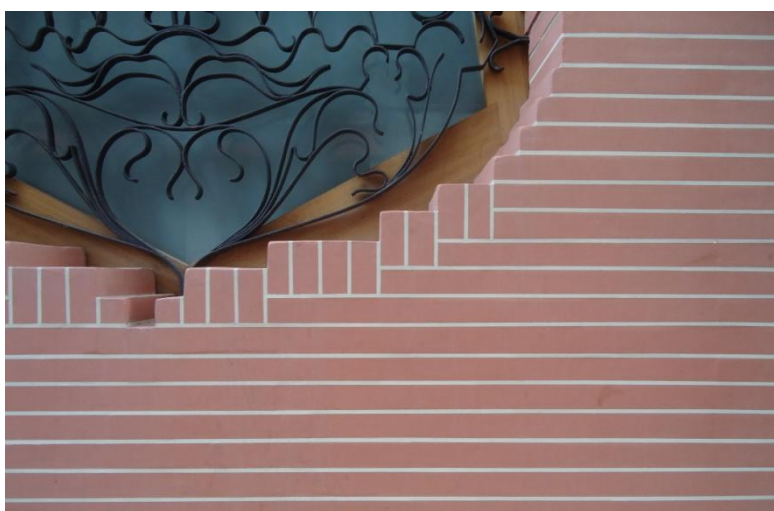
Fig. 4.29 Fingido actual en edificio Hidrola
