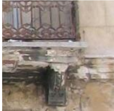
Fig. 4.42 Ménsula que se repite debajo de todos los balcones del edificio situado en plaza Árbol-Valencia (Fuente: Lucas Blancas)
