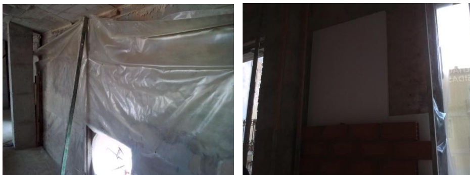
Fig.6.2.46 Ejecución del trasdosado (Fuente: Lucas Blancas)
