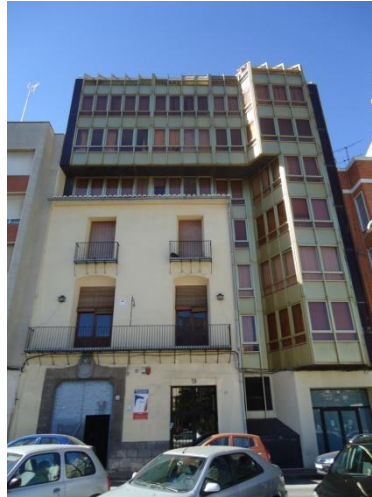
Fig.4.16 Edificio situado en plaza Cronista Chabret nº19 y nº20 donde la nueva aunque llamativa fachada de la edificación adosada se retrae de la fachada existente.
