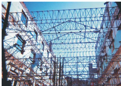
Fig.5.2.2 Arriostamiento interior de las fachadas mediante entramado de tubos de acero y bridas articuladas en Antiguo Hospital Militar- Valladolid (Fuente: Andamios IN S.A)
