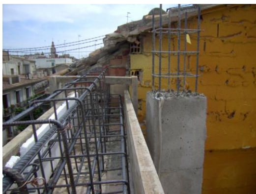
Fig.6.2.37 Encofrado de la viga que remata el muro de fachada conservado. Puede notarse en este punto el espacio dejado entre el muro de fachada y los pilares para colocar el aislamiento (Fuente: Lucas Blancas)
