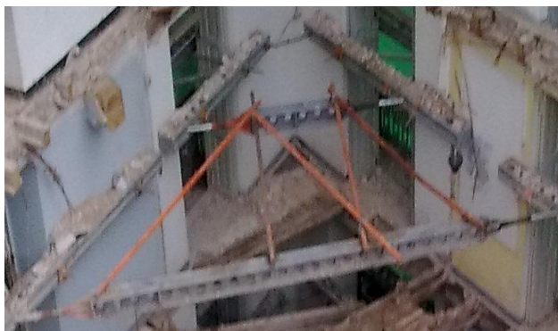
Fig.6.3.13 Arriostramiento interior
