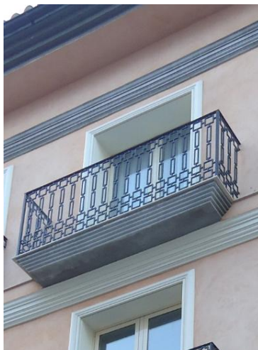
Fig.6.1.17 Voladizo balcón planta tercera.
