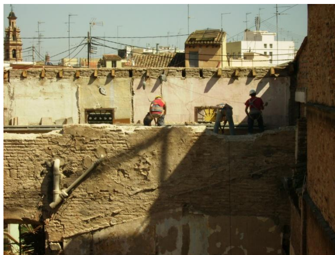
Fig.6.2.27 Derribo forjado planta segunda. (Fuente: Lucas Blancas)
