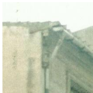
Fig.4.46 Cornisa sobre la que apoya el alero del edificio situado en c/Cami Real – Sagunto (Fuente: VNB Arquitectos)
