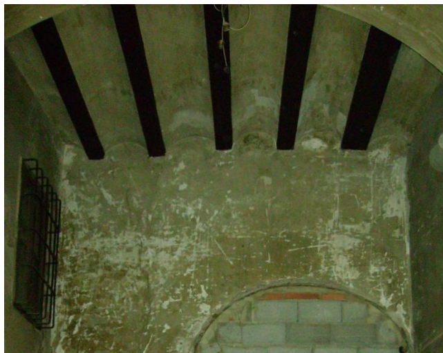
Fig.6.2.2 Forjado planta baja (Fuente: Lucas Blancas)
