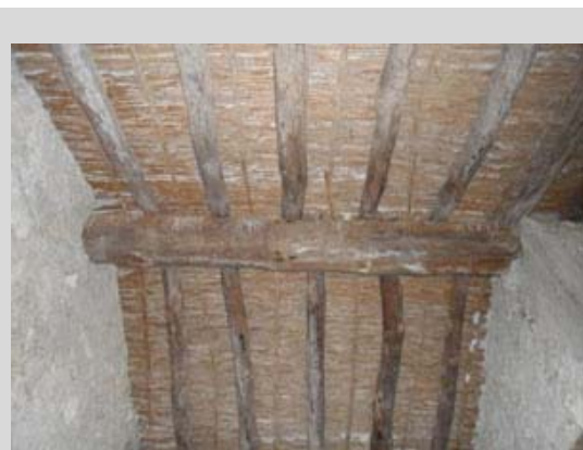
Figura 14: Vista de la cubierta del bloque central
