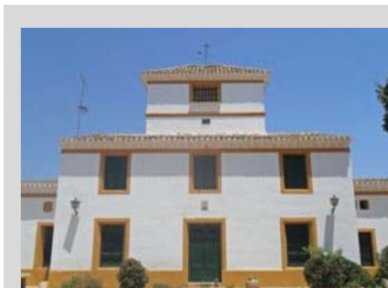
Figura 13: Vista exterior del bloque central
