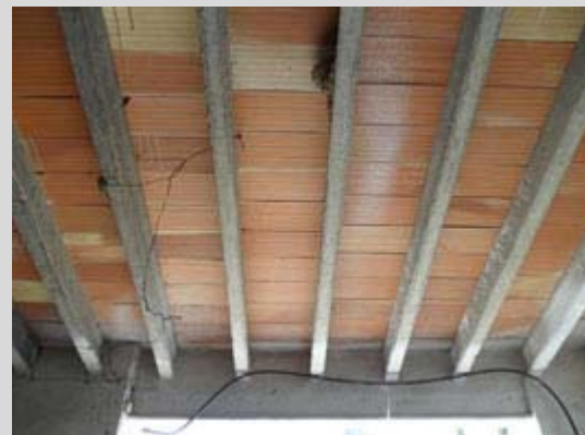
Figura 11: Vista de la cubierta del bloque lateral.
