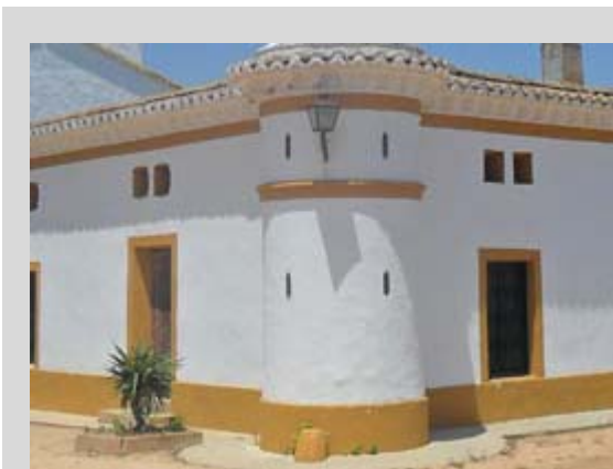
Figura 10: Vista externa del bloque lateral.
