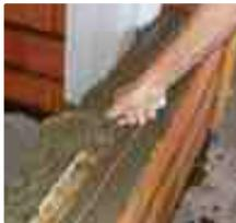
**DESCRIPCIÓN:** Los morteros incluyen el mortero húmedo y seco para servicios de temperatura de 1300°C, 1426°C, y 1540°C.
