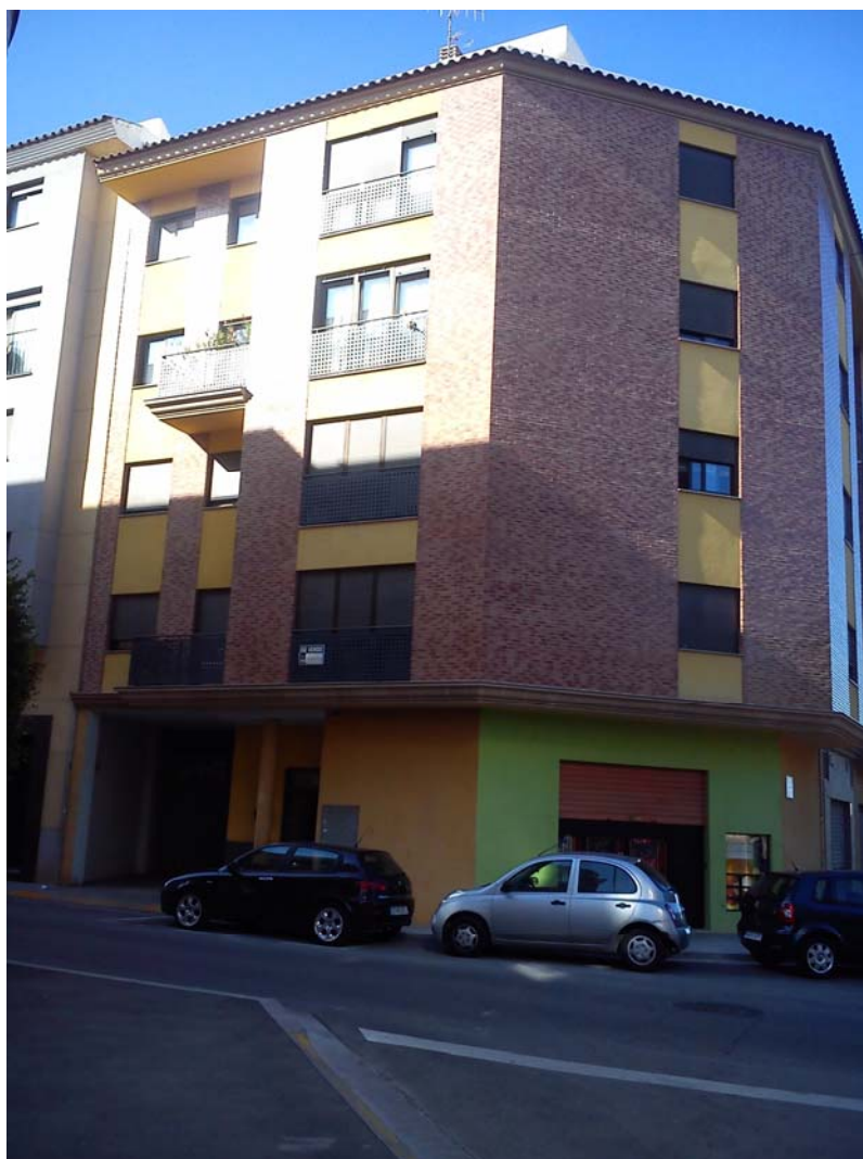
Imagen 4.1.- Imagen de la fachada del edificio
