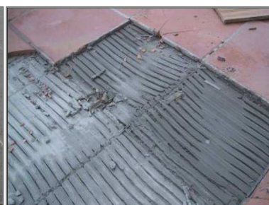
Despegue de pavimento
