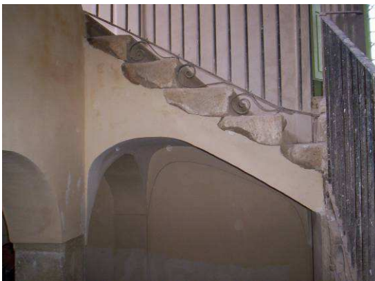
Las piezas que forman los peldaños han sido desmontadas y restauradas y puestas en obra de nuevo
