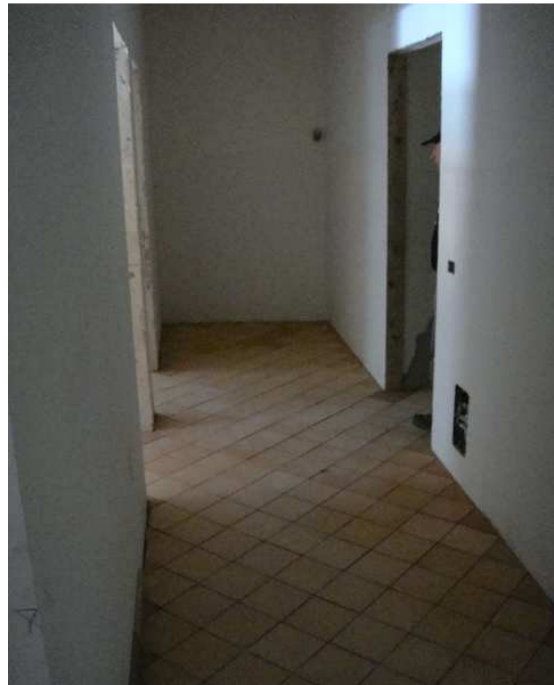
Imagen de enlucido en yeso, se trata del pasillo que comunica los despachos con el ascensor en la planta bajo cubierta
