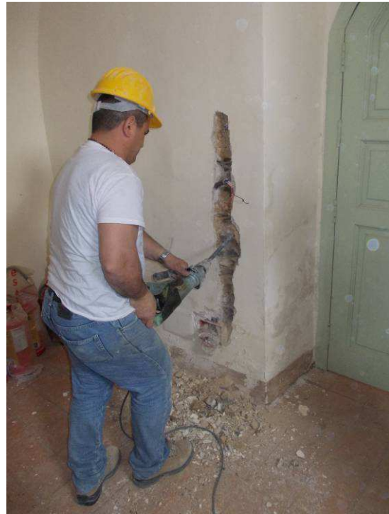
Realización de las regatas para el paso de instalaciones una vez enlucida y pintada la pared.
