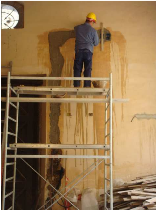
Realización de las regatas para el paso de instalaciones una vez enlucida y pintada la pared.
