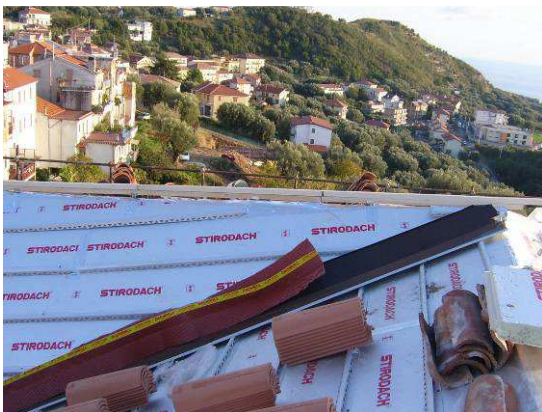
Limahoya sobre la que se coloca una capa de protección
