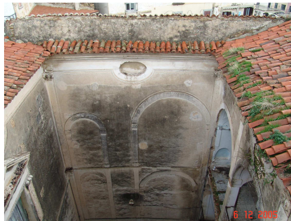
Vista cenital de la fachada ciega
