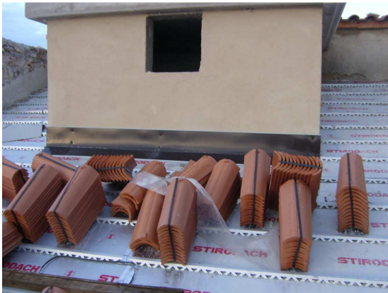
Protecciones en los encuentros con paramentos verticales
