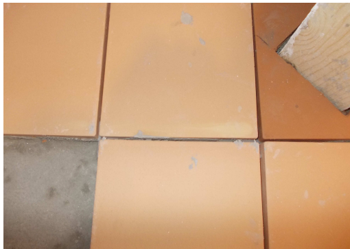
Detalle de las juntas entre las baldosas, realizadas con separadores
