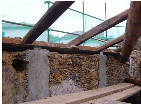
Vigas ya colocadas
