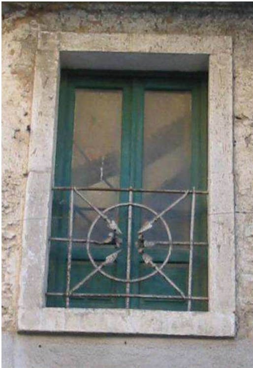
Ventana situada en la primera planta de la calle Roma, con un antepecho de reja
