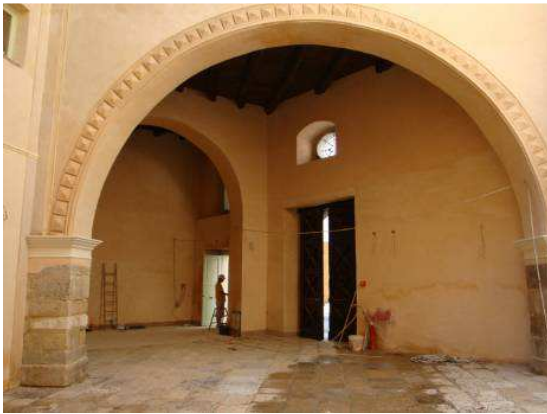
Arco exterior que da paso al patio y al fondo arco que antiguamente estaba tapiado
