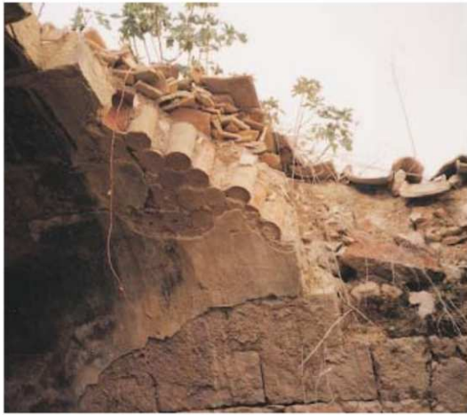
"Pignatelli" utilizados para la construcción de una bóveda en lo localidad de Grumo Appula (Bari)
