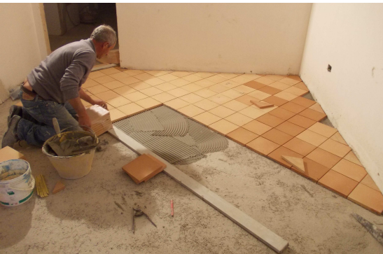
Colocación del pavimento
