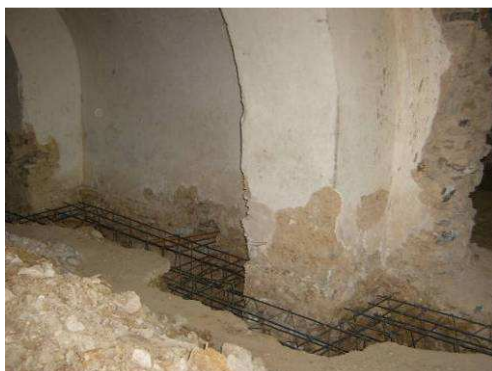
Zanja interior con las armaduras listas para su hormigonado
