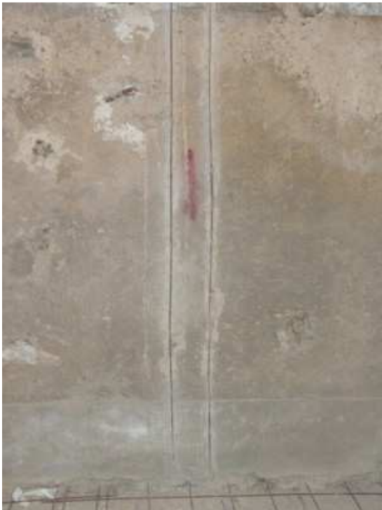
Marcar por donde se realizarán las regatas donde se situarán los perfiles
