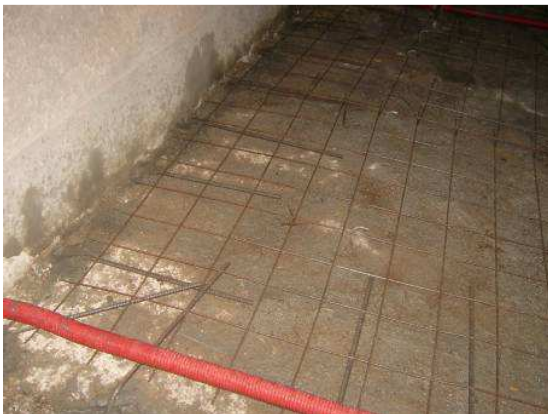
Colocación de la malla electrosoldada
