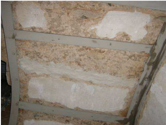
Imágenes de los perfiles insertados en los tramos de la escalera tabicada
