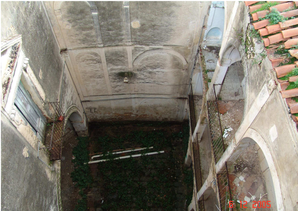
Vista cenital del patio
