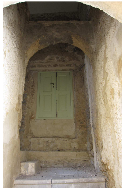
Escalera de acceso a la terraza por la puerta de en frente y de acceso a la planta bajo cubierta girando a la izquierda
