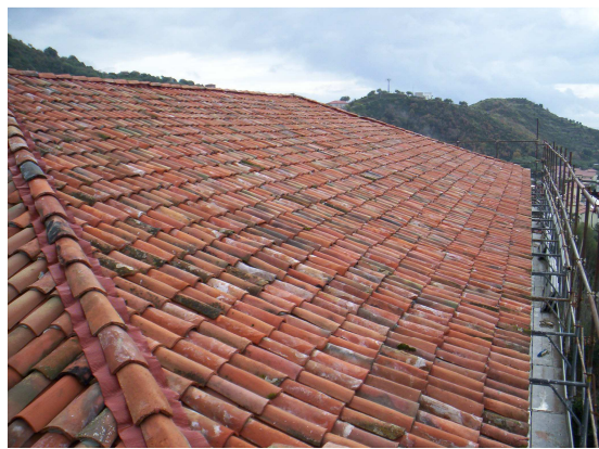
Imágenes de la cubierta terminada
