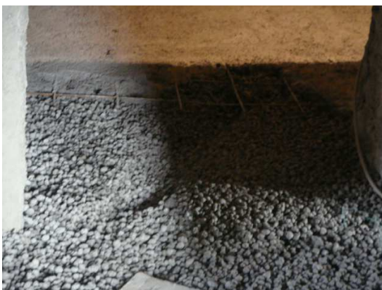
Sobre la mal se vierte el mortero tipo LECA
