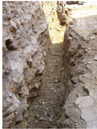
Zanja perimetral de la parte exterior
