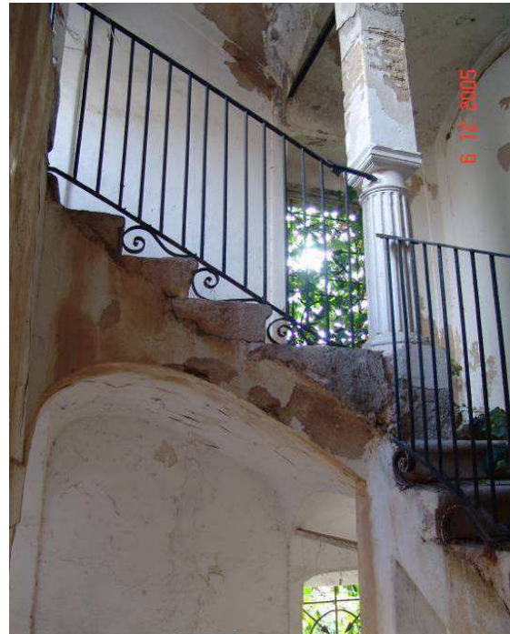
Tramos de la le escalera donde se ven las ventanas que dan al jardín de la calle Rizzi
