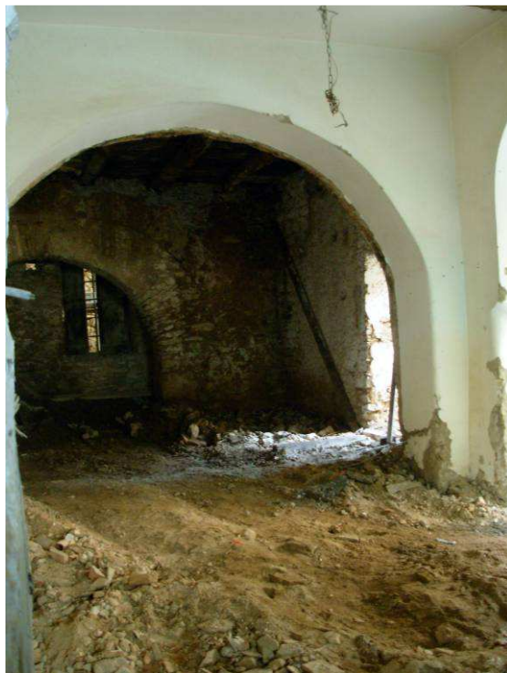
Arcos situados en planta baja del lado preexistente del edificio, y como el resto de los arcos del interior del edificio, realizado con piedra desde su base
