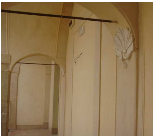
Imagen de uno de los elementos ornamentales ya restaurados
