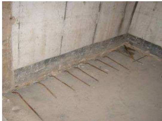
Conectores inseridos para mantener unido el muro con la bóveda
