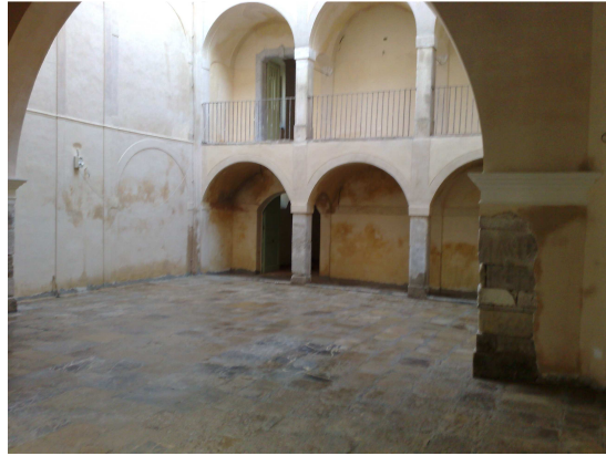
Y pavimentación del patio terminada
