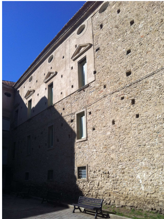
Vista de la fachada ya terminada
