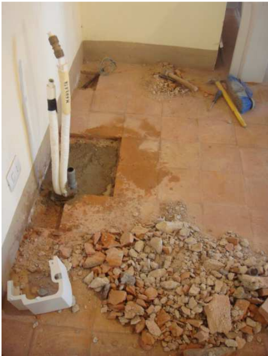
Realización del paso de los tubos para las instalaciones de climatización una vez pavimentado el suelo.
