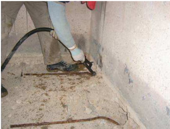
Relleno de los agujeros con resina expansiva para la fijación de los conectores
