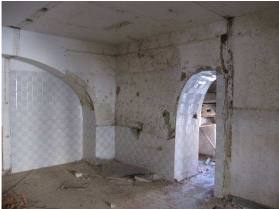
Imágenes de los pocos forjados de hormigón que nos encontramos en el edificio
