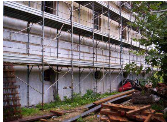
Imágenes del andamio montado para los trabajos de restauración de la fachada
