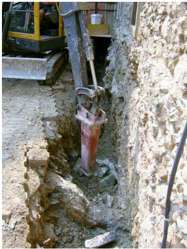
Excavación de las zanjas mediante retroexcavadora con martillo hidráulico
