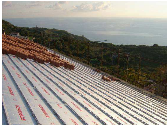
Imágenes de los paneles instalados y de los perfiles de fijación para las tejas
