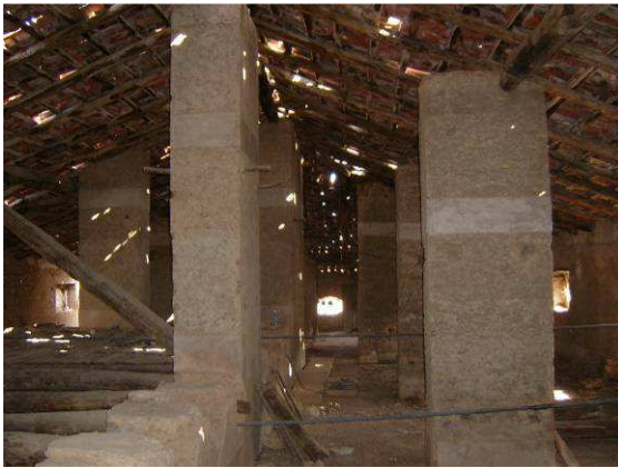
En esta vista general podemos ver los tirantes provisionales colocados para evitar el desplome de las fachadas durante la restauración del edificio
