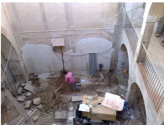
Trabajos de levantado del pavimento del patio
