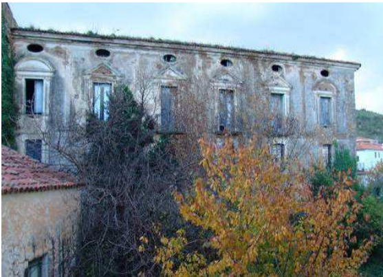
Fachada calle Rizzi
