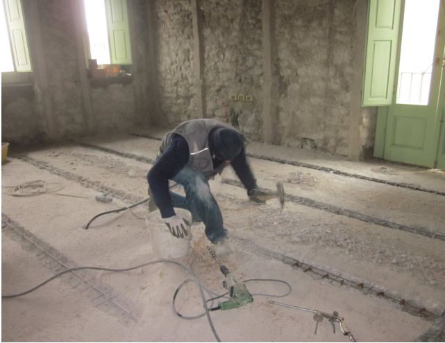
Operario picando el suelo
