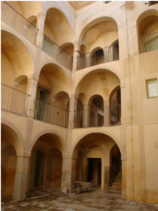
Fachada que alberga la escalera "settecentesca"
