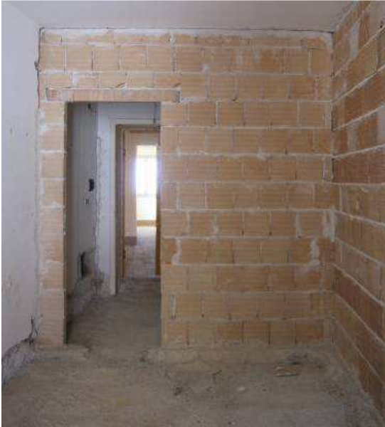
Realización de la nueva distribución con ladrillo hueco
