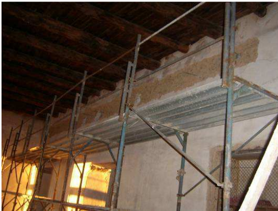
Imagen del forjado de la sala noble elevado a su altura original
