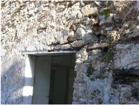
Ejemplos de los dinteles del edificio
