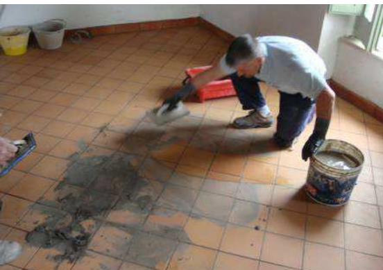
Rejuntado del pavimento de barro cocido
