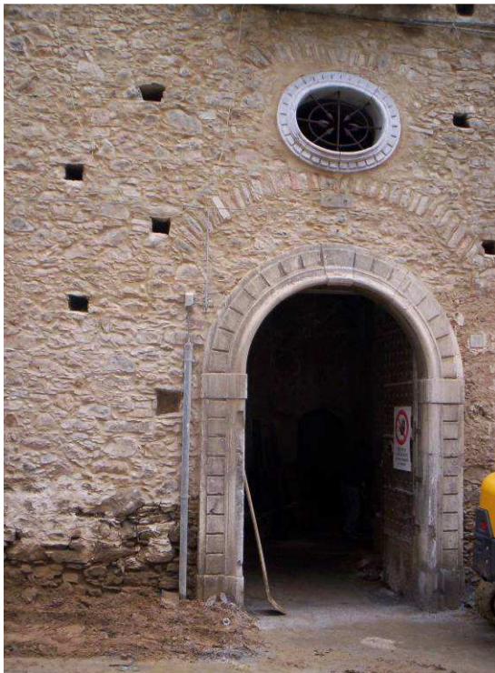
Detalle del portal de ingreso durante los trabajos de restauración
