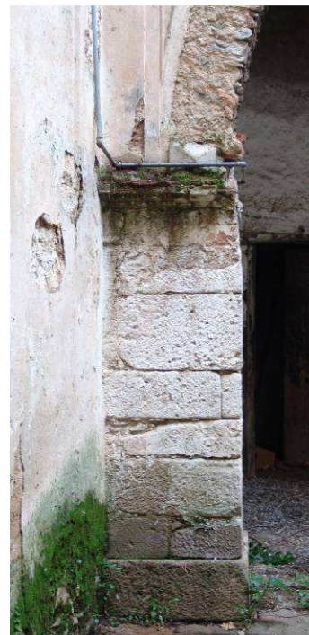
Detalle del arranque del arco que da paso al patio, realizado con sillares
