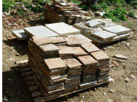
Pavimento existente almacenado para su posterior utilización
