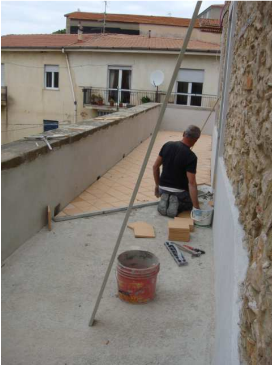
Trabajos de pavimentación
