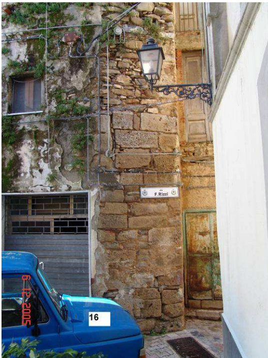
Detalle de un muro donde se aprecia la diversidad de los tamaños de las piedras, la homogeneidad en algunas partes y el desorden en otras y el uso de ripios
