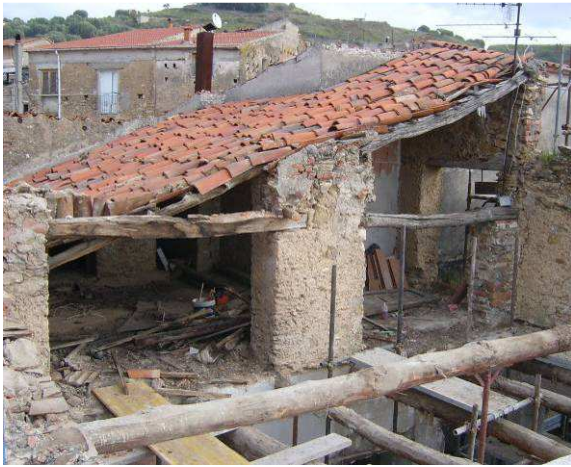
Vista del estado de las cubierta
