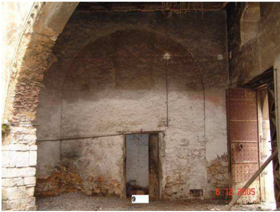
Arco tapiado situado a la derecha de la entrada al edificio, realizado con sucesión de piedras desde la base
