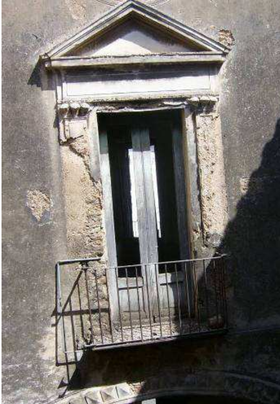
Balconera situada en el patio interior, en la fachada del arco de entrada
