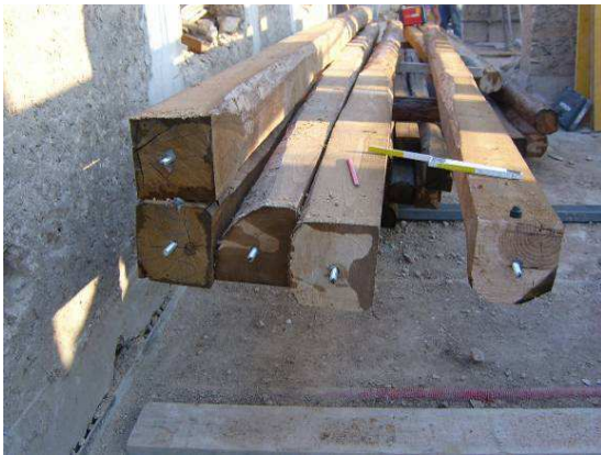
Vigas con los pernos que servirán para su fijación en el perfil
