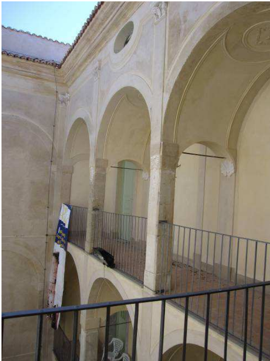
Imagen de detalle de la fachada
