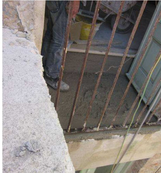
Ejemplo de una de las barandillas del edificio
