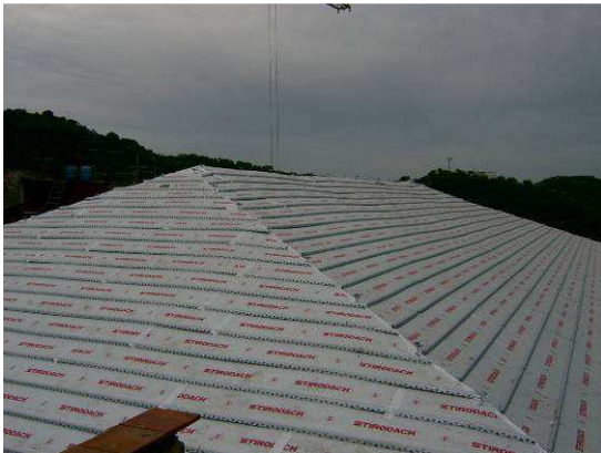
Imágenes de los paneles instalados y de los perfiles de fijación para las tejas
