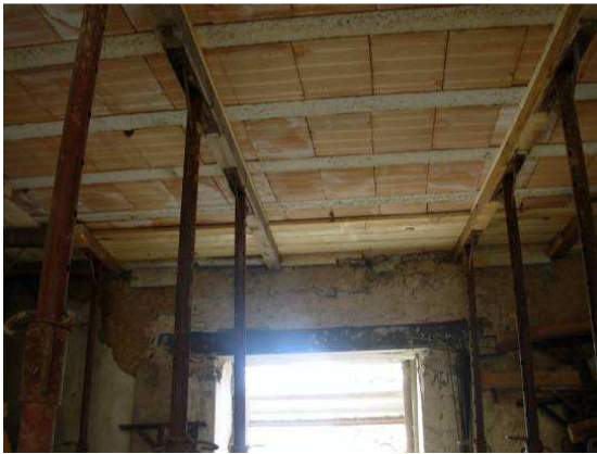
Intradós del forjado
