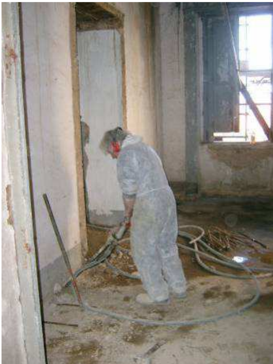
Operario realizando las perforaciones para la inserción de los conectores
