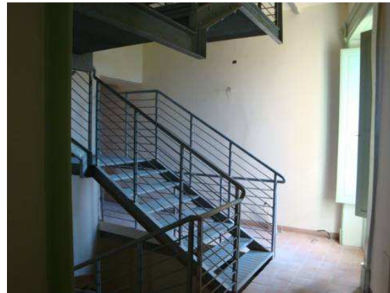
Tramo de la escalera de emergencia por la parte interior
