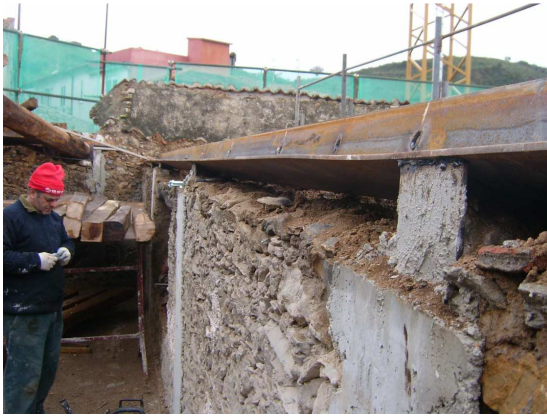
Detalle del perfil perimetral sobre el muro
