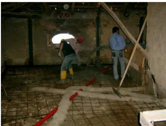
Vertido del hormigón
