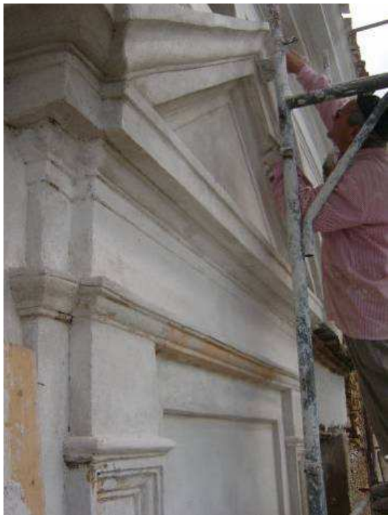
Imágenes al detalle de proceso de restauración de las pilastras y los frontones que rodean las ventanas de la segunda planta de estas dos fachadas
