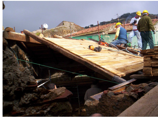
Colocación de las tablas
