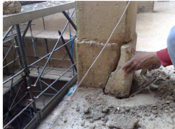
Inserción de elementos rotos para devolver la estética original
