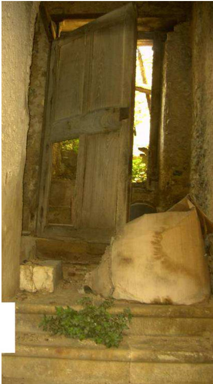
Tramo en la planta bajo cubierta que da a la terraza y por donde a mano izquierda se accede a la "Torre dell'Ischia"
