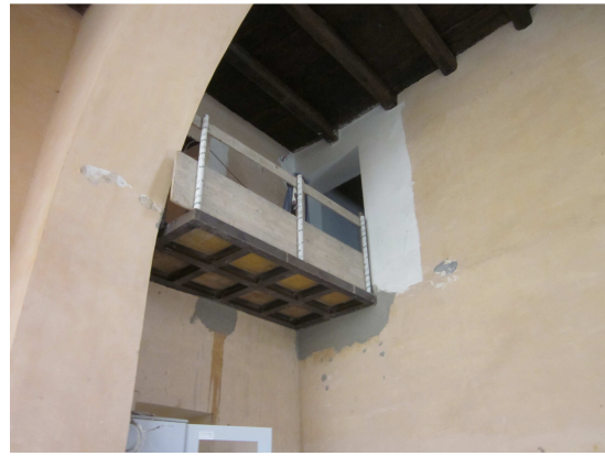
Pasarela realizada en hierro sobre la que irá una base de cristal y protegida por una barandilla también de cristal, intentando así que dé el mínimo impacto visual
