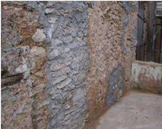
Imágenes del rejuntado de los muros
