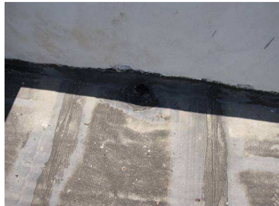
Detalle del sumidero
