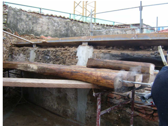
Realización de perforaciones en las vigas para insertar los pernos
