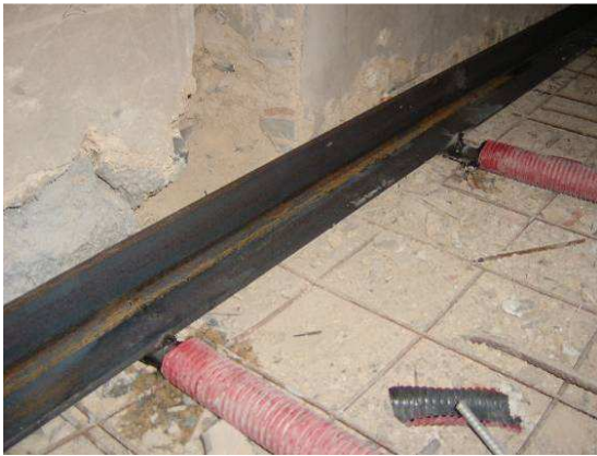
Vista de las soldaduras entre los perfiles y las barras
