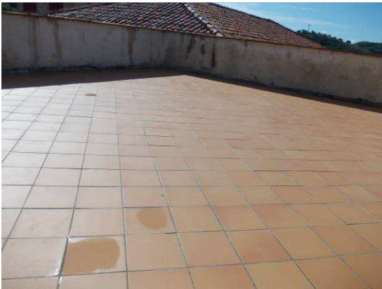
Pavimentación terminada a falta de los rodapiés
