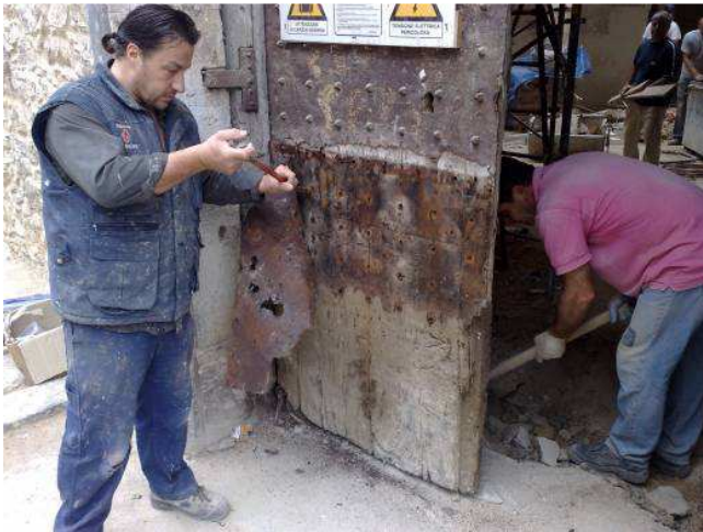
Labores de restauración de la puerta principal
