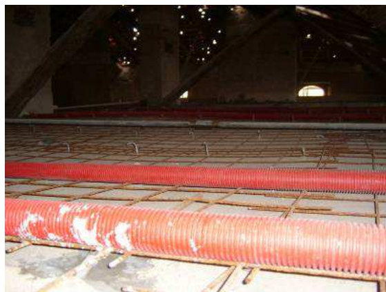
Colocación de los conectores para mantener la estructura el forjado unido una vez vertida la capa de compresión
