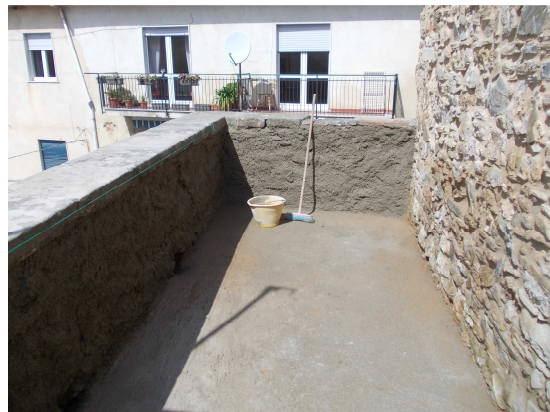
Vertido de mortero nivelante y enfoscado del antepecho
