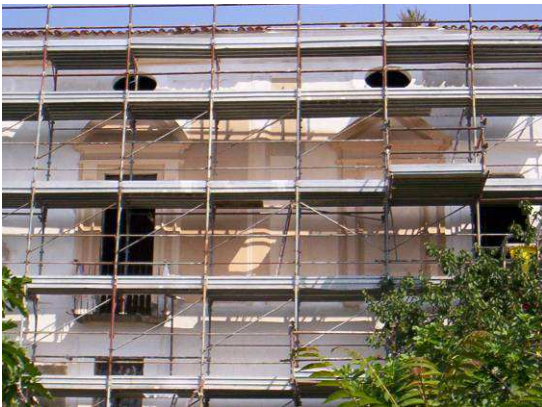
Imágenes del andamio montado para los trabajos de restauración de la fachada
