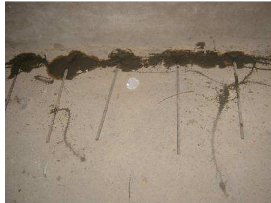
Relleno de los agujeros con resina expansiva para la fijación de los conectores
