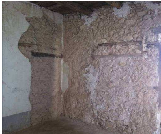
Aquí se aprecia el uso de tabloncillos de madera para mantener la nivelación del muro
