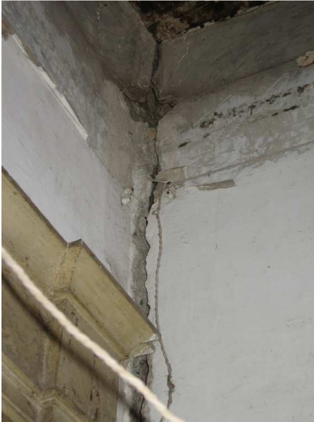
Imágenes de las grietas producidas por el terremoto
