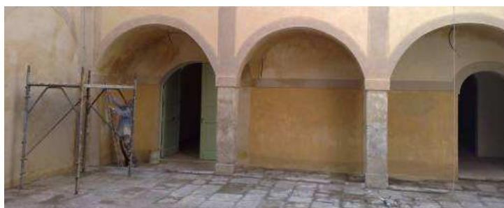
Imagen de la fachada de frente de la entrada recién terminada
