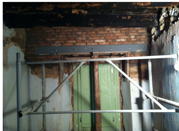
Sustitución de un dintel y refuerzo con ladrillo macizo
