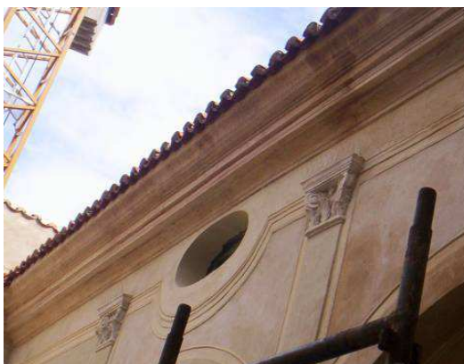
Detalle de las volutas que decoran los capiteles de las pilastras en las fachadas, tanto en las partes centrales como en las esquinas
