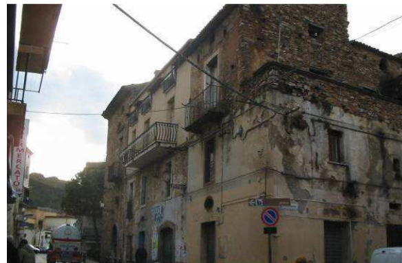
Esquina de fachadas calle Roma Y plaza Basili
