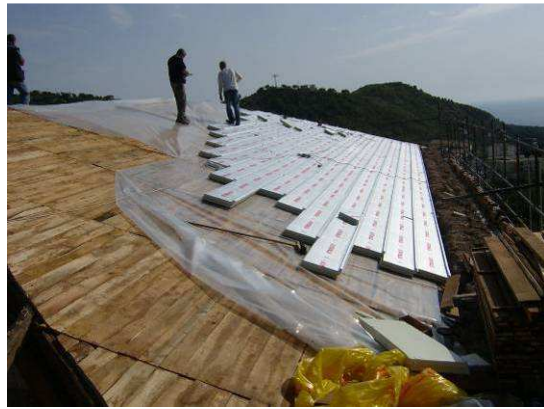
Inicio de la instalación de los paneles aislantes
