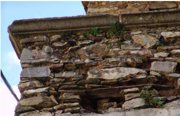
Imagen más detallada de la colocación de las piedras
