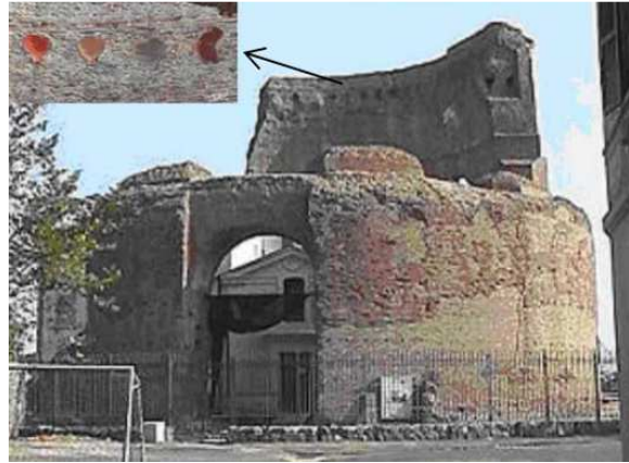
Mausoleo de Santa Elena (Roma, 326-330 d.C.), donde se aprecia en el detalle las ollas utilizadas para la construcción del muro
