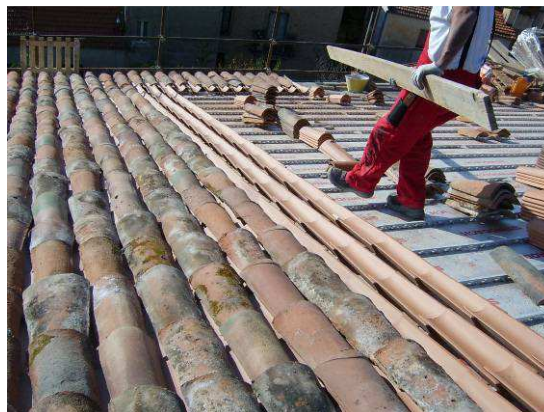
Colocación de las tejas en canal y cobija
