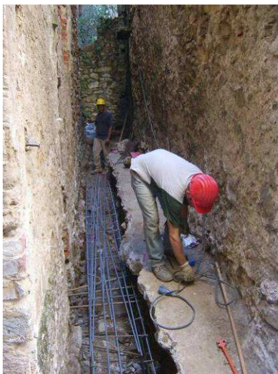
Colocación de las armaduras en el perímetro exterior
