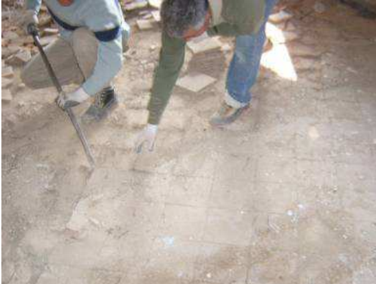
Trabajos de levantado del pavimento
