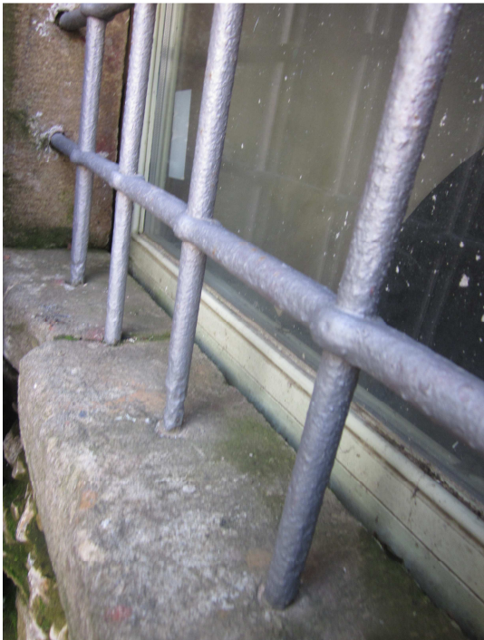
Detalle de una de las rejas de las ventanas de la primera planta del lado "settecentesco"
