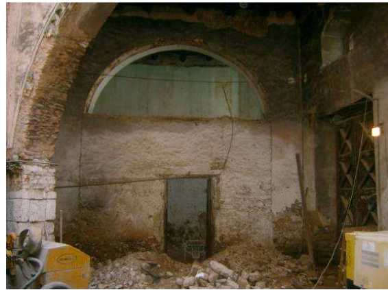
Labores de demolición para la apertura del arco
