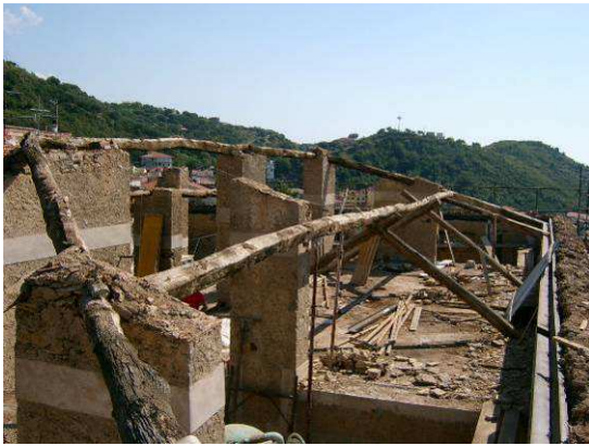
Imagen del perfil perimetral superior ya colocado
