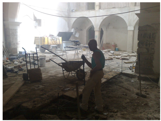
Pavimentación del patio
