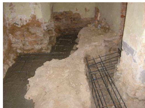
Hormigonado de las zanjas interiores
