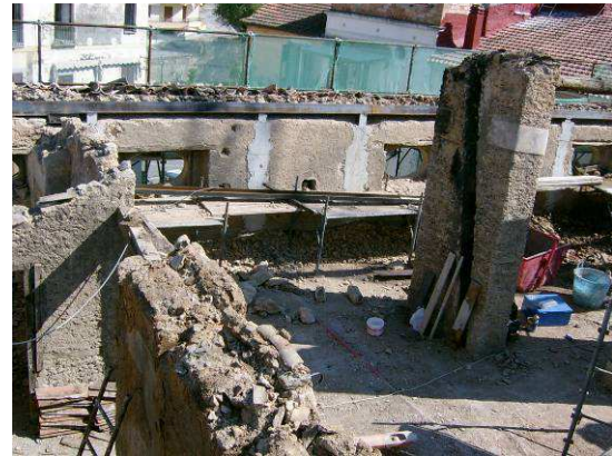
Cubierta totalmente desmontada
