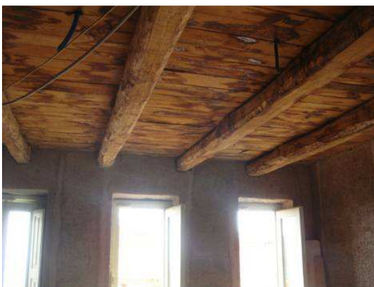
Imágenes de forjados terminados
