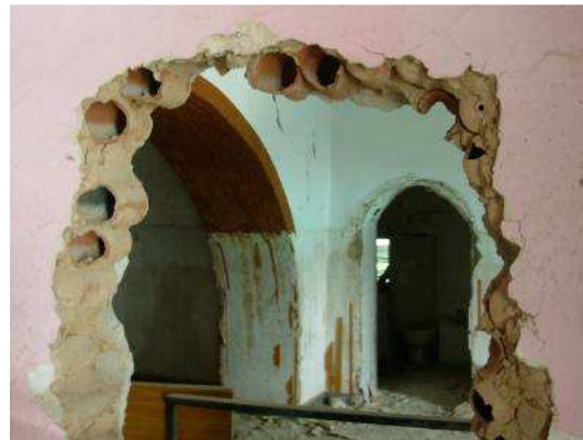
Detalle del tabique
