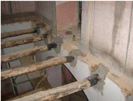
Tras el desmontado del forjado actual se coloca una protección en la parte de la viga que va insertada en el muro
