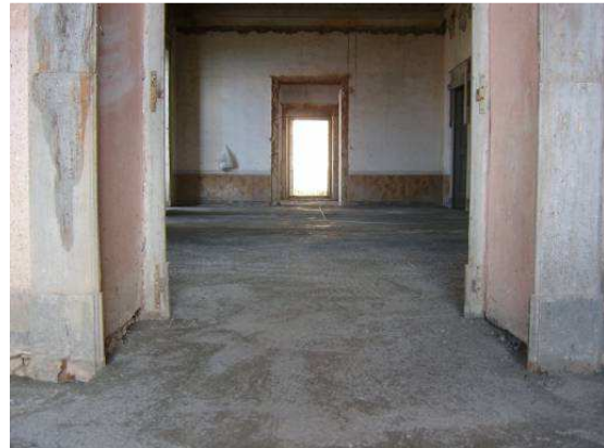
Parte superior del forjado
