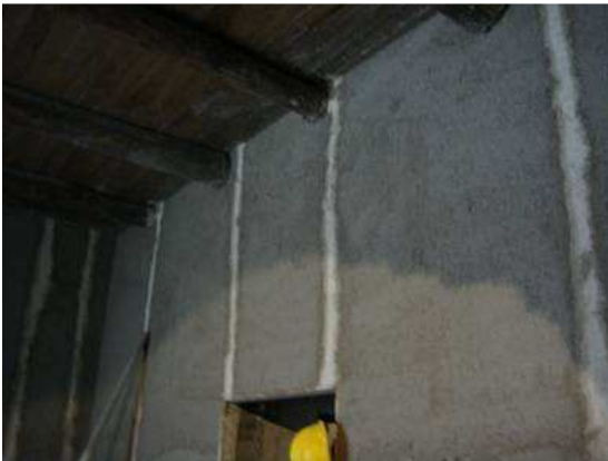
Imagen del enfoscado de una de las paredes internas
