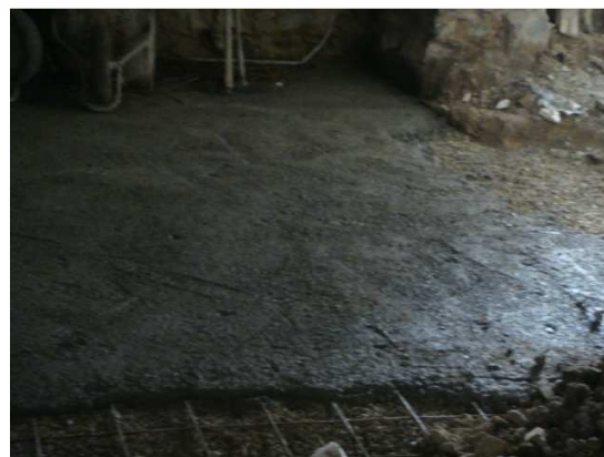
A continuación se pone la malla electrosoldada y se vierte la capa de compresión
