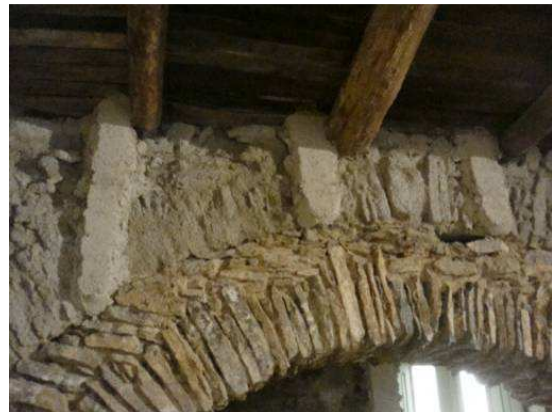
Detalle de un arco con la piedra vista
