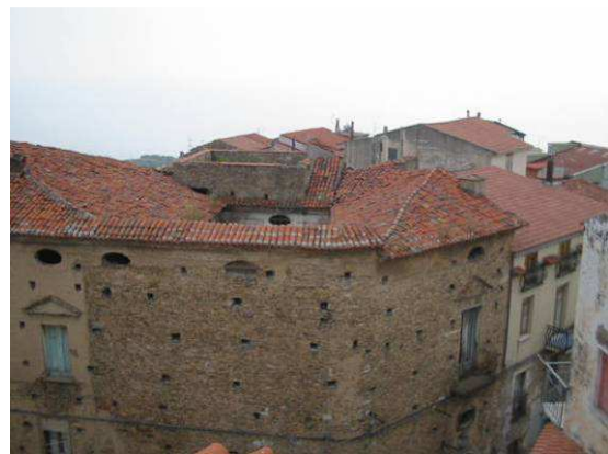
Imágenes aéreas de la cubierta, donde se aprecia el buen estado de la cubierta de la parte preexistente a causa de las reformas realizadas durante los años 50
