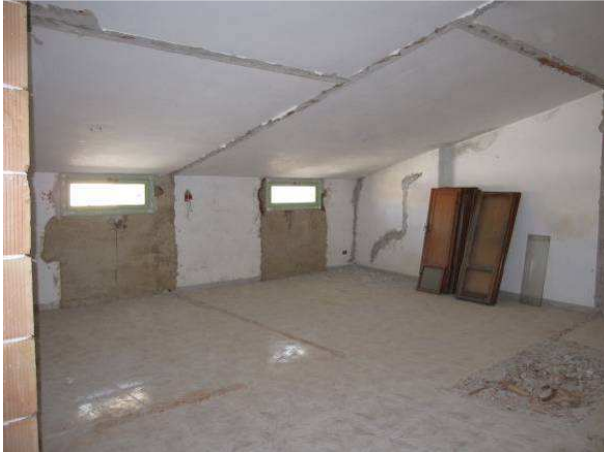
Imagen de la cubierta en el lado preexistente del edificio
