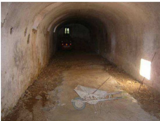
Bóveda de cañón de uno de los locales en planta baja de casi 25 metros de longitud
