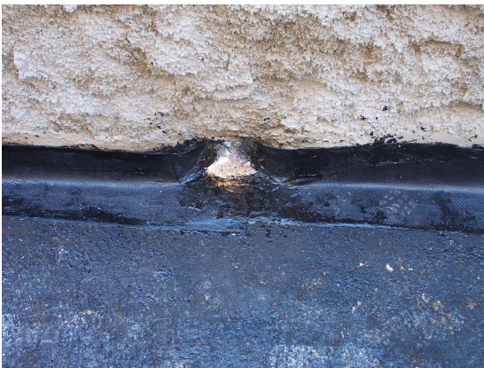
Detalle del hueco para el sumidero
