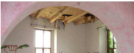
Forjado de madera en cual estaba recubierto por papel no tan deteriorado como el anterior
