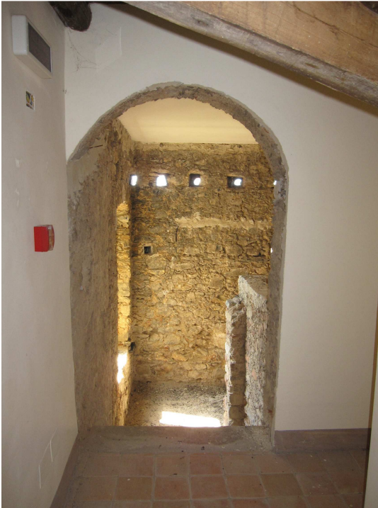
Fin de la escalera "settecentesca" en la planta bajo cubierta
