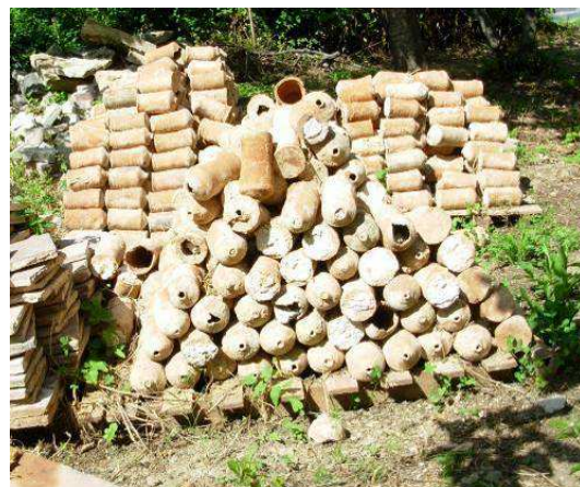
Almacenamiento de las "mummarelle" encontradas en los tabiques demolidos.
