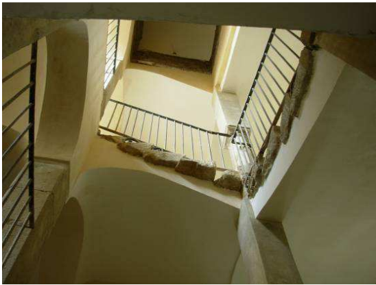
Imágenes de la escalera terminada
