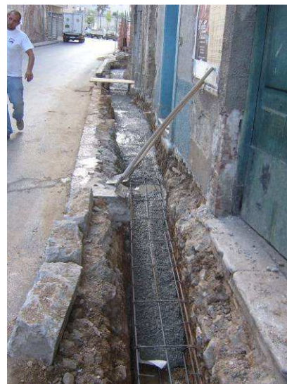
Hormigonado de las zanjas en el exterior
