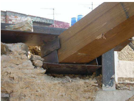
Imágenes de una de las vigas principales encajada
