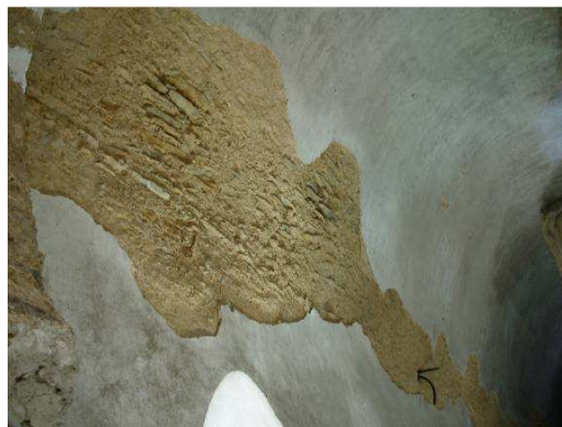
Imagen de cómo está construida la bóveda, a base de piedras planas colocadas simultáneamente formando el arco
