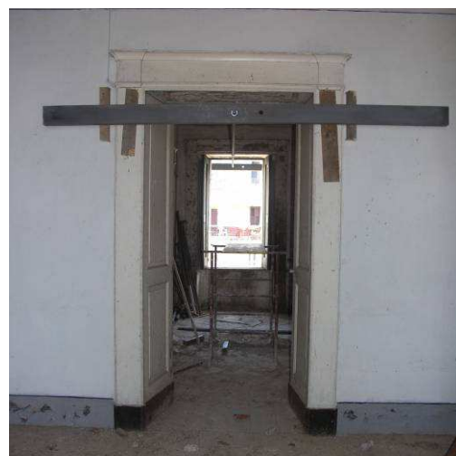
Tirantes provisionales para evitar el desplome de las fachadas hasta su estabilización
