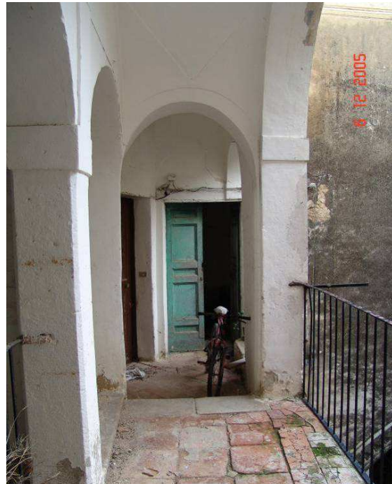
Pasillo de la segunda planta que da paso a la parte preexistente del edificio
