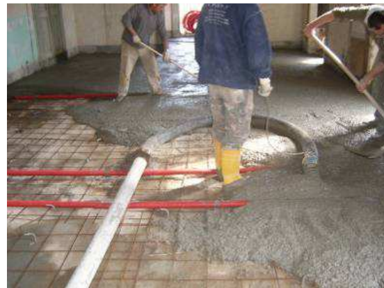
Vertido de la capa de compresión
