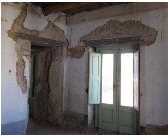
Sustitución de los dinteles de una balconera y de una puerta con refuerzos laterales con piedras de la misma tipología que las del muro
