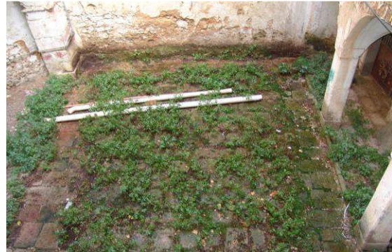
Pavimento del patio exterior con adoquines
