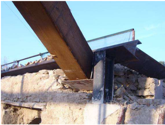
Imágenes de una de las vigas principales encajada
