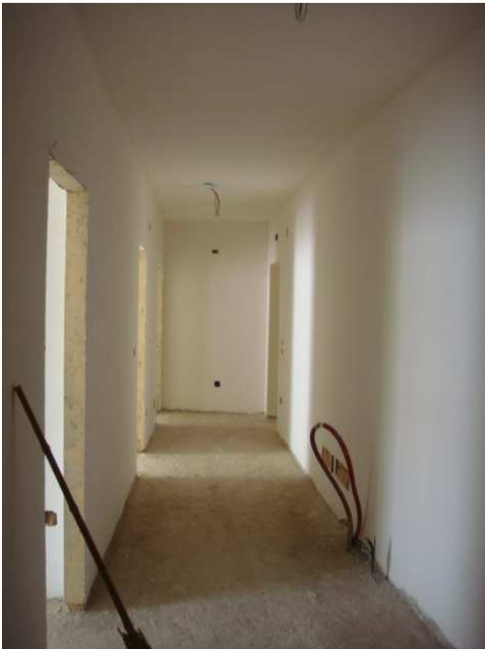
Imagen del pasillo que comunica los despachos de la planta bajo cubierta
