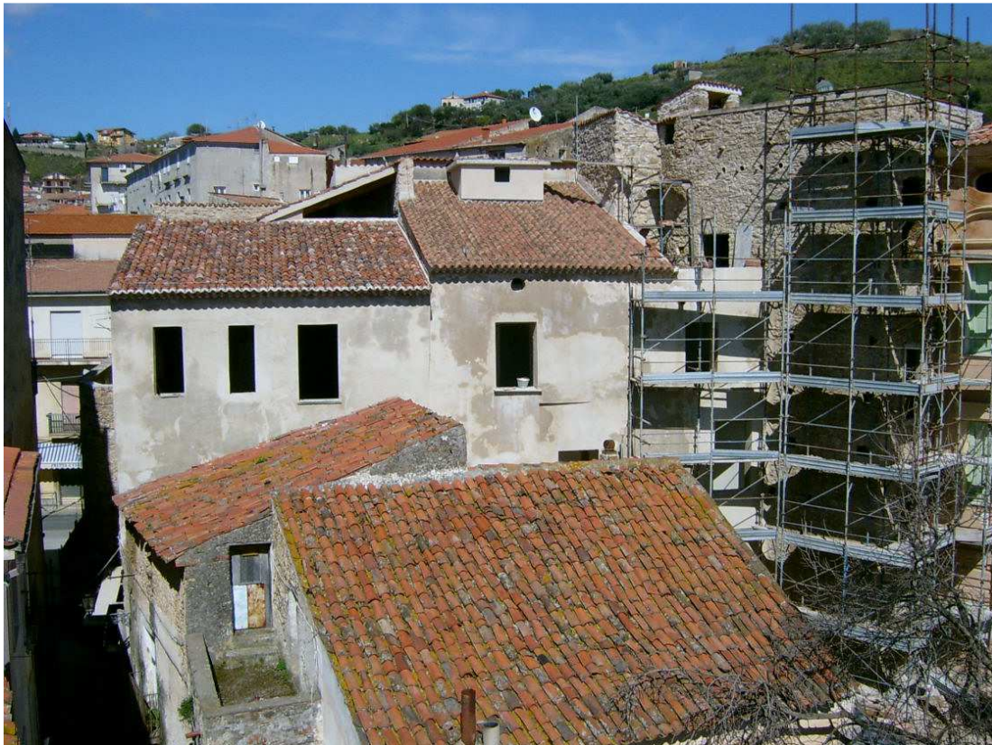
Imagen de la fachada perpendicular a la calle Rizzi recién enlucida, a falta de la colocación de las ventanas y de ser pintada con un ligero color crema
