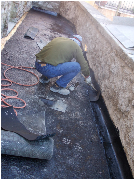
Instalación de la capa asfáltica aplicando calor con un soplete
