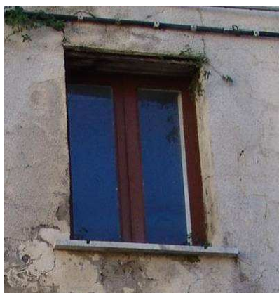
Ventana situada en la parte preexistente del edificio
