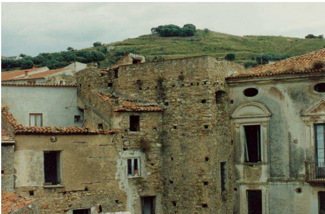
Imagen de la unión de las dos estructuras
