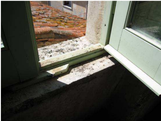
Detalle de la ventana
