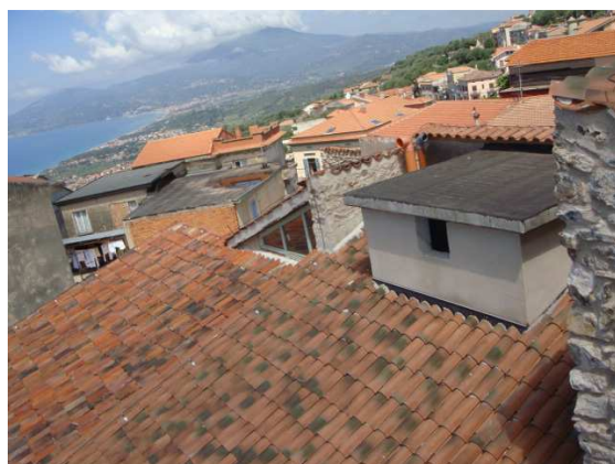
Imagen de la cubierta terminada en la parte preexistente
