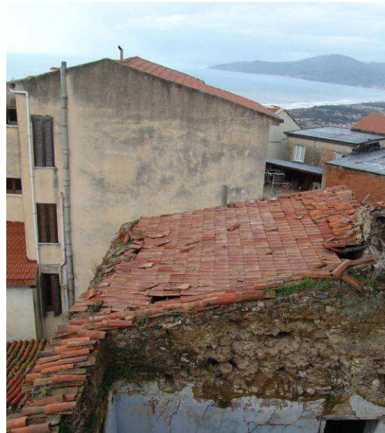
Vista del estado de las cubierta
