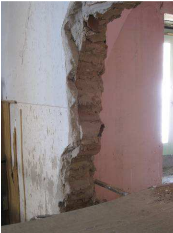
Tabique realizado con "mummarelle" para así aligerar la estructura
