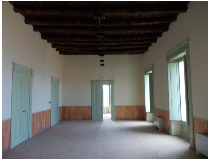
Imagen de la sala noble terminada
