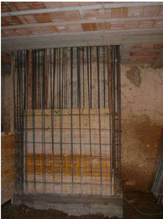
Imágenes de la realización del foso del ascensor
