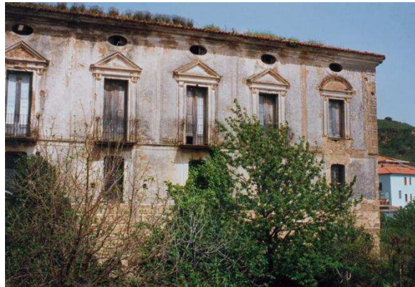
Fachada calle Rizzi
