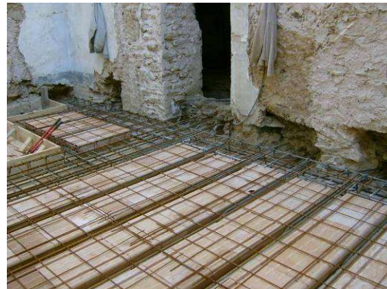
Imagen de las bovedillas y las armaduras listas para su hormigonado
