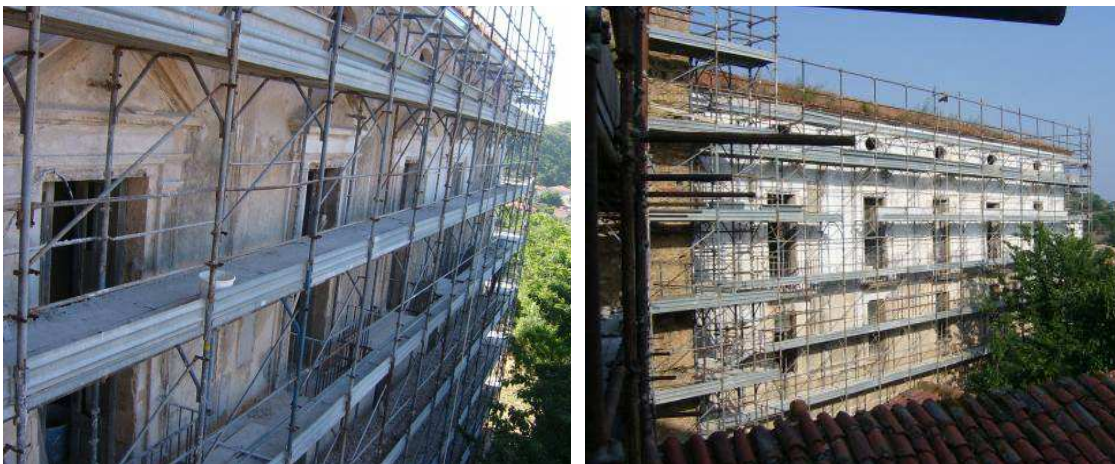
Imágenes durante la restauración de la fachada de la calle Rizzi
