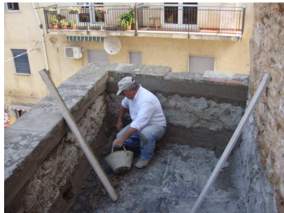
Realización de la capa de protección
