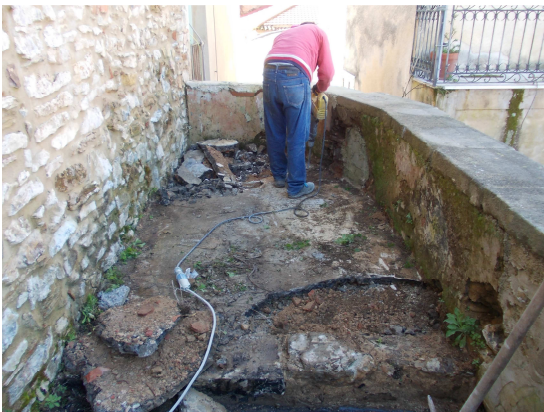
Eliminación del pavimento actual y de toda la capa vegetal que se había creado
