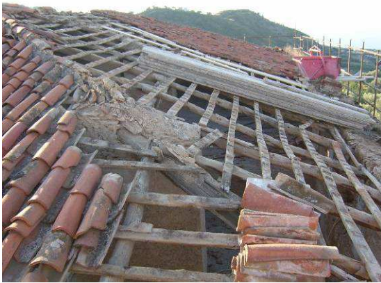
Desmontado de las tejas y almacenadas para su posterior uso
