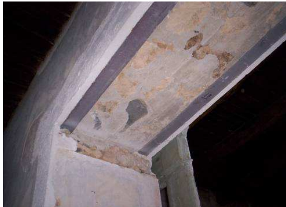
En esta imagen se ve como quedan ocultos los perfiles de frente, lo que aún se ve quedará tapado por el marco de la puerta
