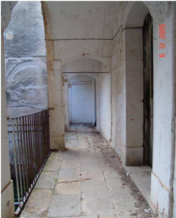
Pasillo al que se accede por la escalera y que da paso a las estancias de la primera planta
