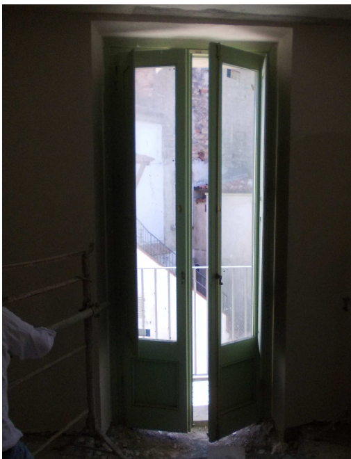
Balconera de dos hojas con cristal Climalit y contraventanas
