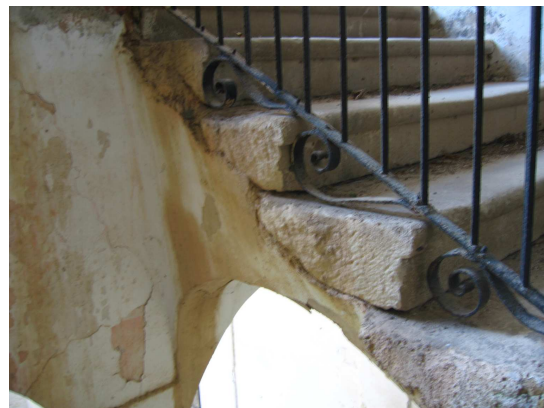
Detalle de los escalones y de la barandillas realizada con hierro forjado
