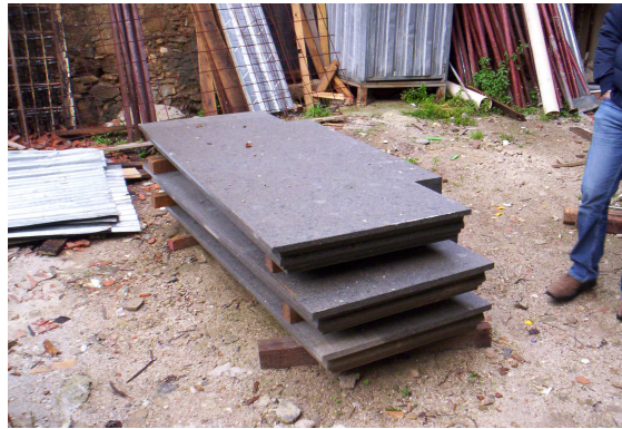
Piezas nuevas de los balcones, para sustituir aquellas que tengan las esquinas rotas
