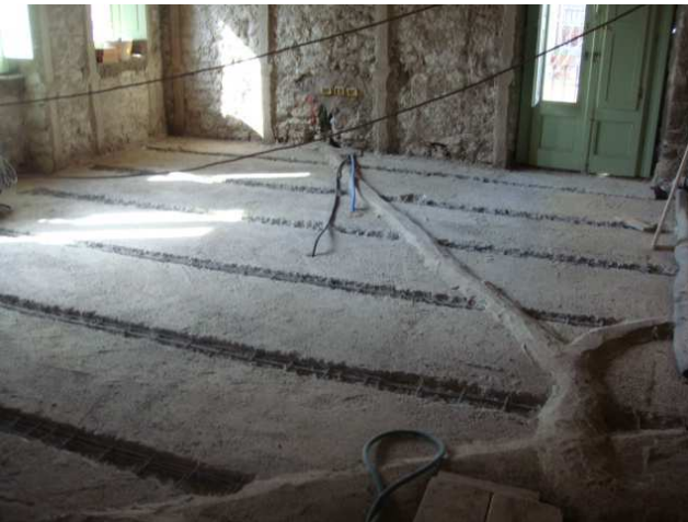
Regatas para la inserción de los conectores realizadas
