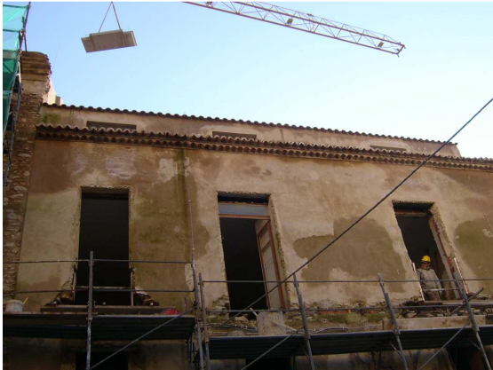
Imágenes de la instalación de las balconeras en la fachada de la calle Roma
