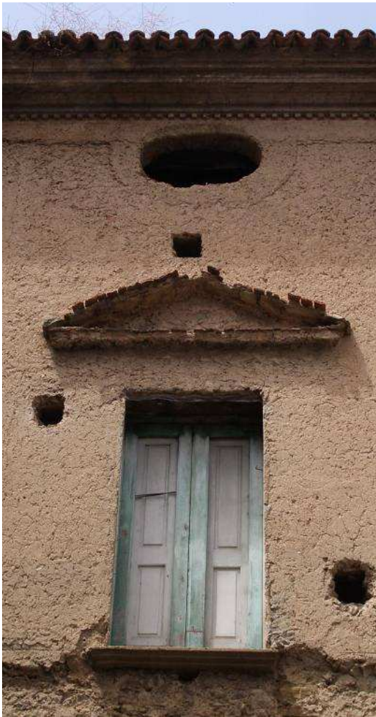
Ventana rectangular situada en la segunda planta de la fachada de plaza Bovio, realizada en madera y coronada por un frontón inacabado
