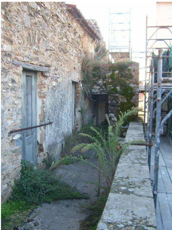
Puerta con dintel aliviado con un arco
