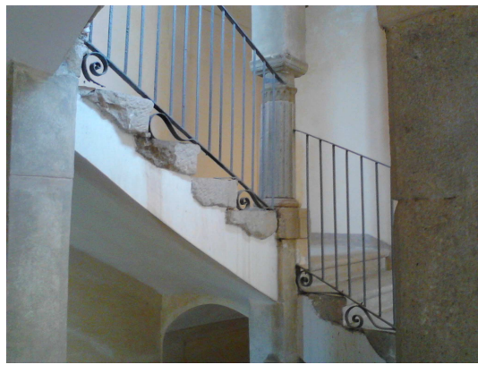
Las piezas que forman los peldaños han sido desmontadas y restauradas y puestas en obra de nuevo
