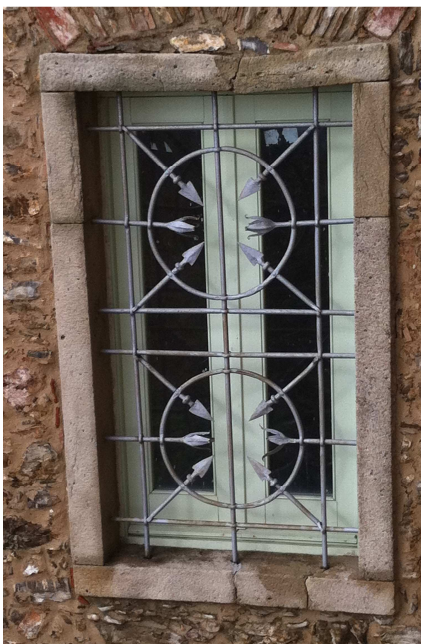
Imágenes de las rejas ya sin oxidaciones y pintadas
