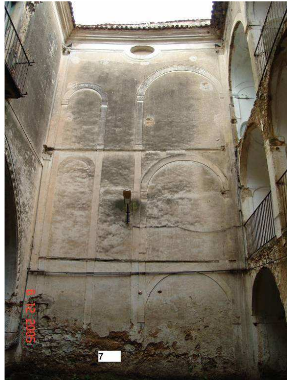
Fachada ciega del patio interior
