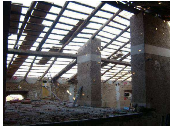
Desmontado de la cubierta
