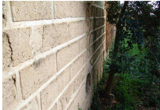
Detalle de la decoración de la fachada Rizzi imitando sillares
