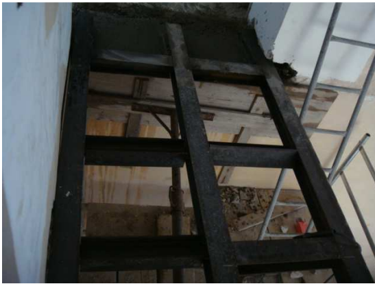
Pasarela realizada en hierro sobre la que irá una base de cristal y protegida por una barandilla también de cristal, intentando así que dé el mínimo impacto visual
