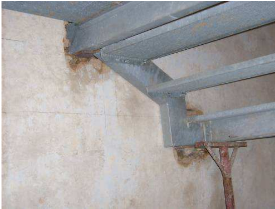
Anclado de la escalera a la pared en la parte interior
