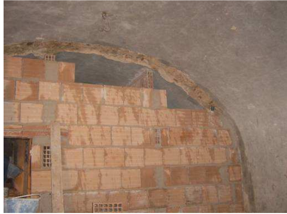
Cubrición de los huecos de tabiques existentes con ladrillo hueco
