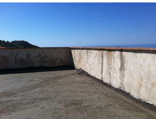
Vertido de la capa protectora
