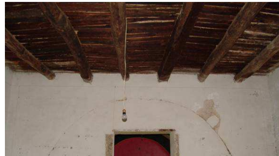
Forjado de madera sin recubrir y en buen estado
