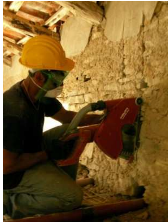
Realización de las regatas con una regateadora
