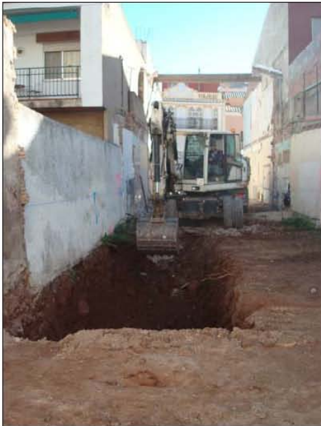
FASE | MOVIMIENTO DE TIERRAS
