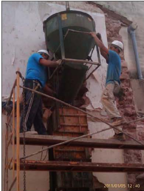
FASE | ESTRUCTURAS - Vertido de hormigón en pilares con cubilote.
