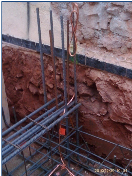
Fig. nº 50: Colocación de la puesta a tierra.
