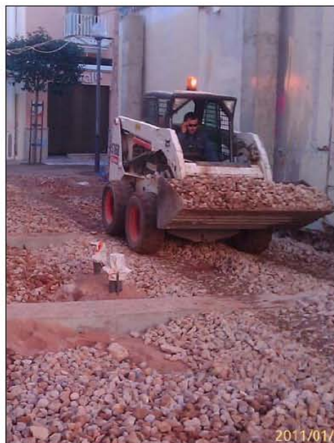
FASE ESTRUCTURAS - Colocación de la machaca, base de solera.
