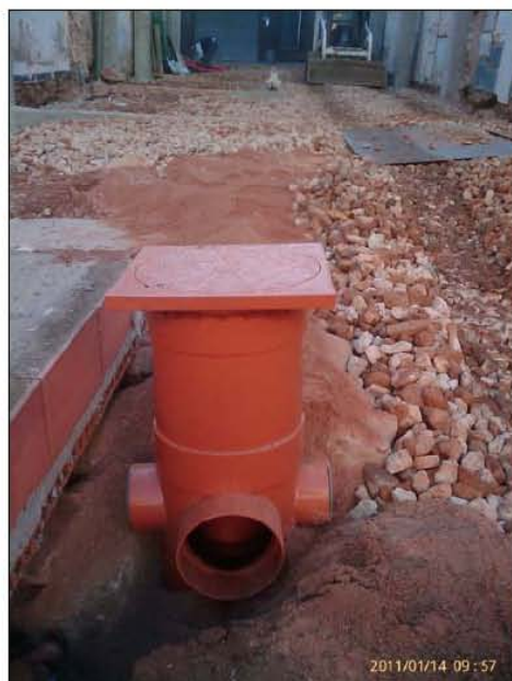
FASE INSTALACIONES - Instalación de arqueta de paso prefabricada.
