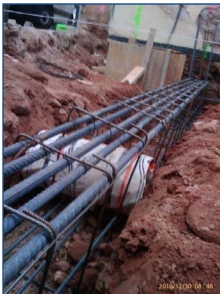
Fig. nº 54: Colocación de pasatubos.
