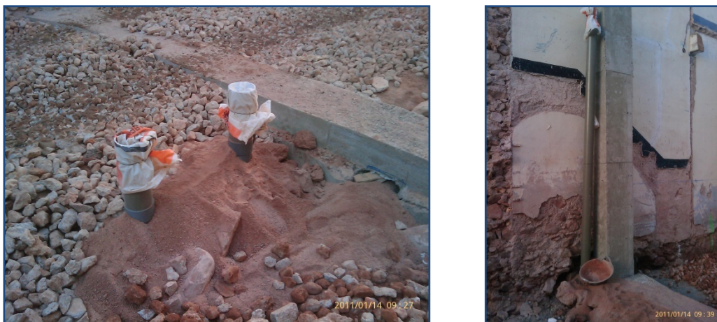
Fig. nº 56: Instalación de los ramales enterrados y las bajantes.
