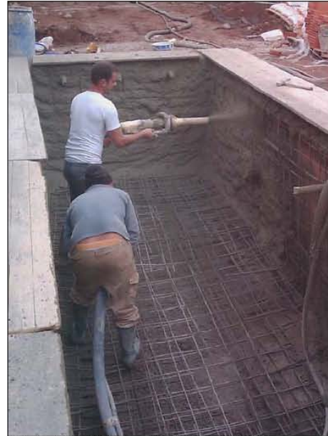
FASE | CONSTRUCCIÓN DE LA PISCINA
