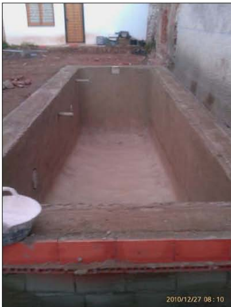
FASE | CONSTRUCCIÓN DE LA PISCINA
