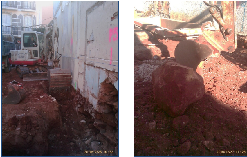
Fig. n° 39: Excavación de la cimentación.
