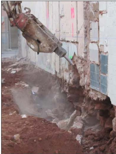
FASE | MOVIMIENTO DE TIERRAS - Desvaste del muro medianero por medio de un martillo percutor con el fin de alojar el pilar numero 5.
