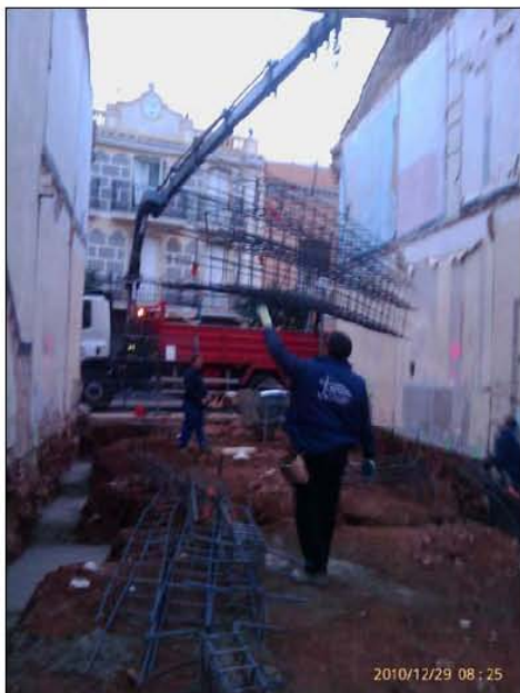
FASE | ESTRUCTURAS - Comienzo de la fase de estructura con la del hormigón de limpieza de la cimentación y la recepción de la ferralla armada de zapatas, riostras y arranques de pilares.
