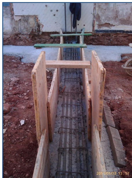
Fig. nº19: Hormigonado de cimentación Fig. nº20: Encofrado de riostras
