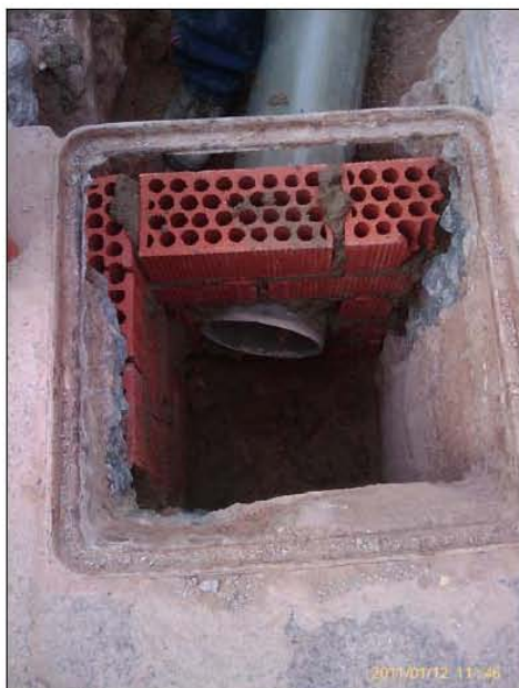
FASE INSTALACIONES - Acometida de la red de saneamiento a la red general de alcantarillado.
