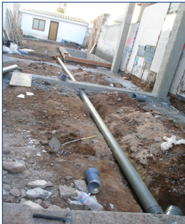
Fig. nº 55: Colocación de saneamiento enterrado.
