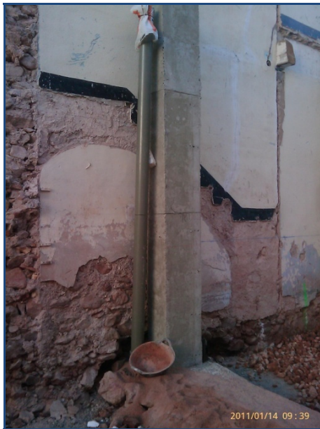
Fig. nº33: Unión de la bajante con la tubería enterrada y arqueta de paso prefabricada.
