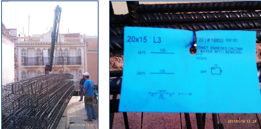
Fig. nº 46: control del acero en la recepción en obra.
