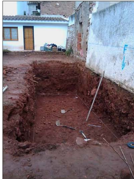
FASE | MOVIMIENTO DE TIERRAS
