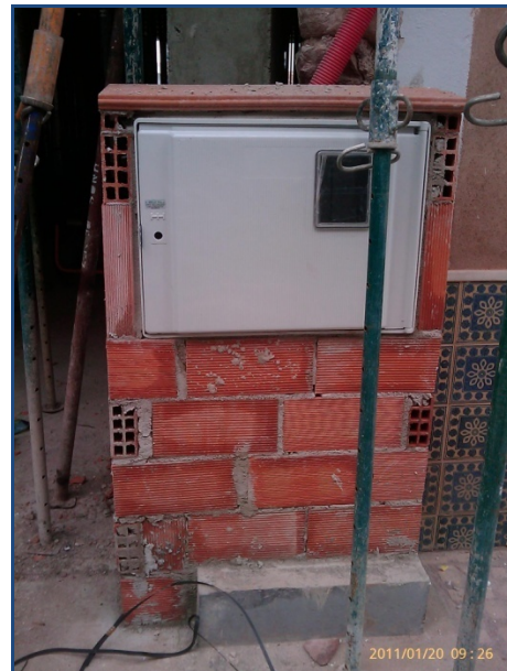
Fig. nº 49: Caja general de protección provisional.
