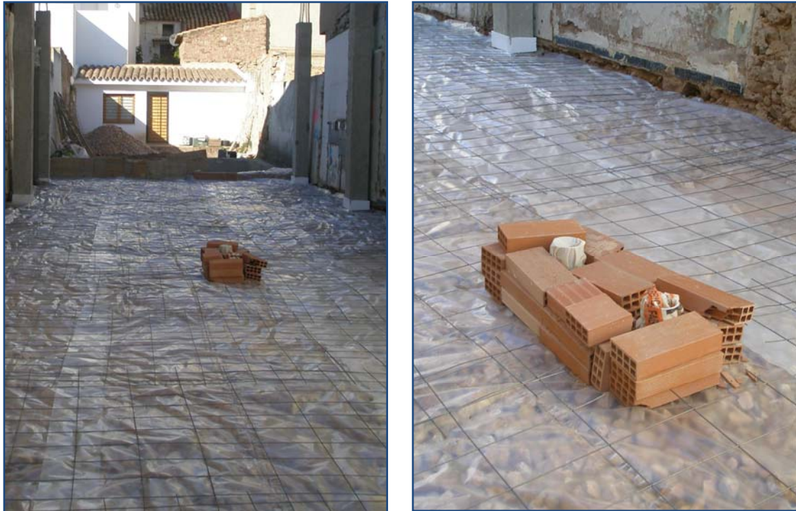
Fig. nº35: Colocación de la malla electrosoldada.
