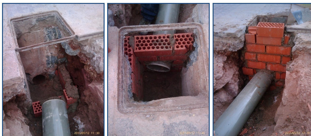
Fig. nº 57: Construcción arqueta y acometida de la red de saneamiento.
