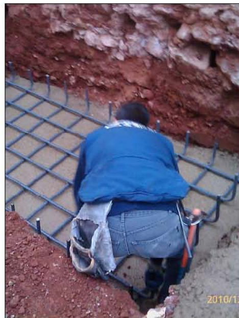
FASE | ESTRUCTURAS - Colocación de la armadura de cimentación.
