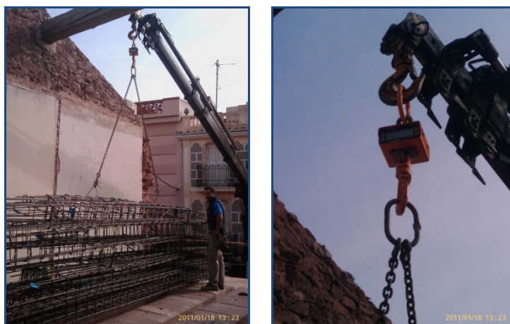
Fig. nº 38: Báscula para la recepción de materiales en obra.
