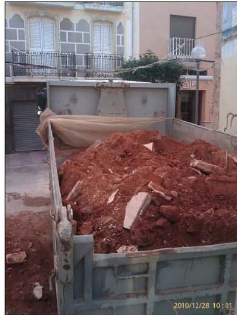
FASE | MOVIMIENTO DE TIERRAS - Transporte de material a vertedero.
