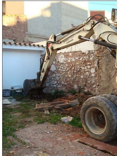
FASE | MOVIMIENTO DE TIERRAS
