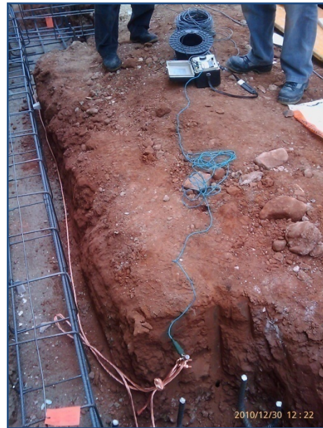
Fig. nº 50: Colocación de la puesta a tierra.
