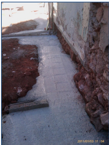
Fig. nº19: Hormigonado de cimentación Fig. nº20: Encofrado de riostras
