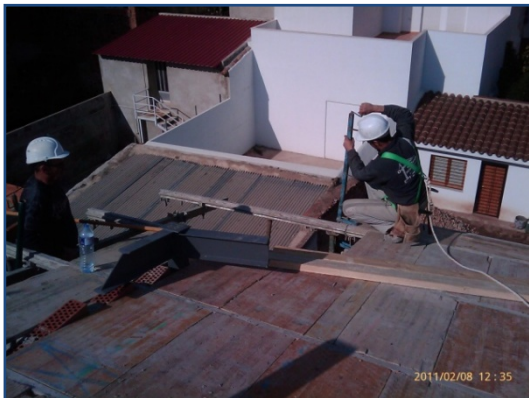
Fig. n°27: Ejecución de la cubierta inclinada.
