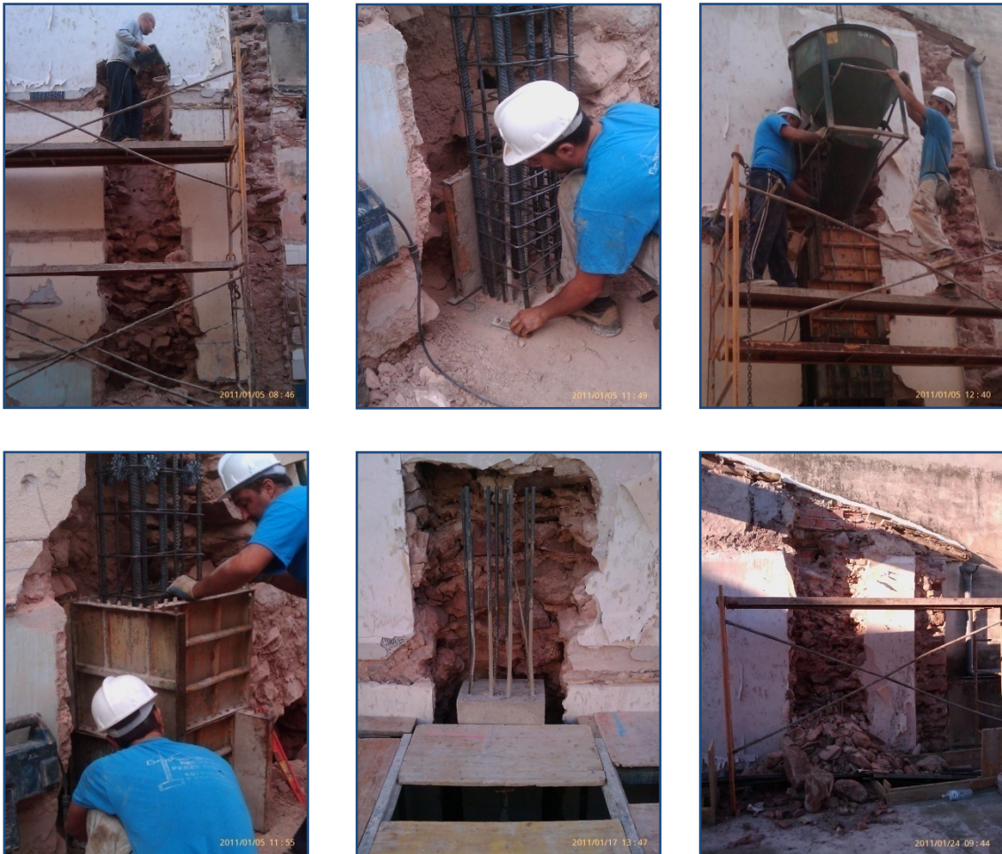
Fig. nº10: Ejecución del pilar nº 5.
