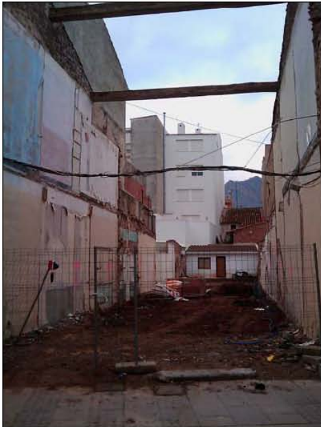
FASE | MOVIMIENTO DE TIERRAS
