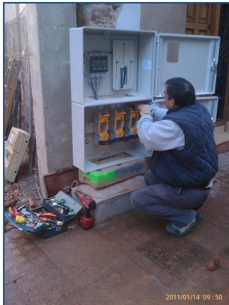
Fig. nº 49: Caja general de protección provisional.
