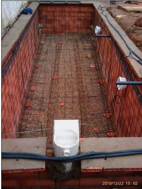
FASE | CONSTRUCCIÓN DE LA PISCINA
