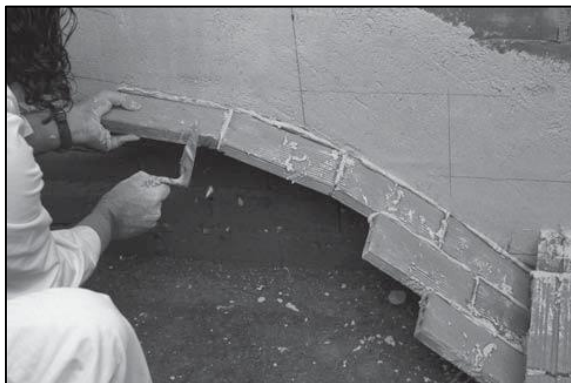
Imagen 128. Ejecución primera rosca
