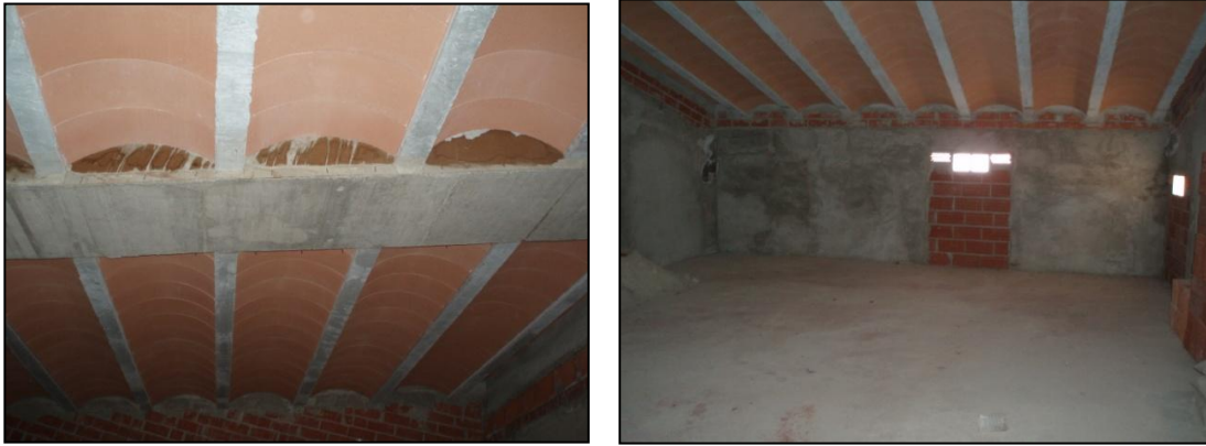
Imágenes 23 y 24. Forjado unidireccional.
