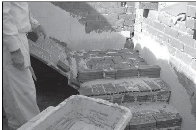
Imagen 137. Final de la segunda rosca en el primer tramo
