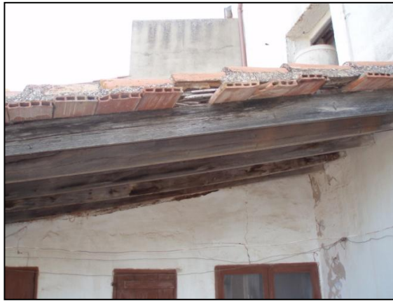
Imágenes 21. Cubierta de la terraza
