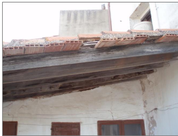
Imágenes 96. Cubierta a intervenir
