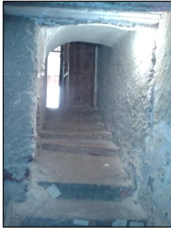
Imágenes 83. Escalera sótano
