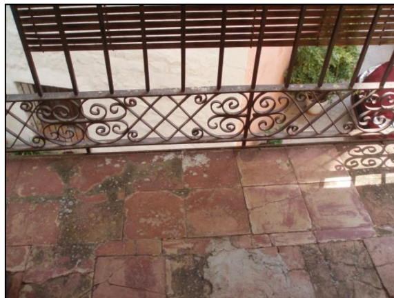
Imágenes 46. Pavimento balcones
