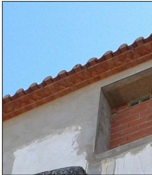
Imágenes 25. Alero cubierta.
