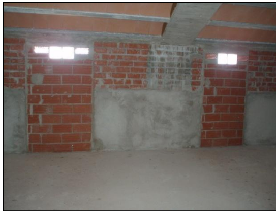
Imágenes 77. Ventanas tapiadas planta bajo cubierta
