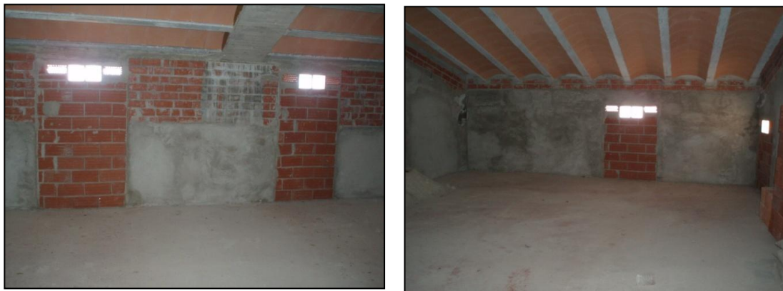
Imágenes 38 y 39. Pavimento planta bajo cubierta (sin pavimento)
