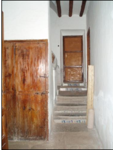
Imágenes 61. Puerta sótano y puerta salon
