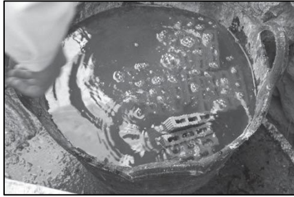
Imagen 136. Humedecido de las rasillas
