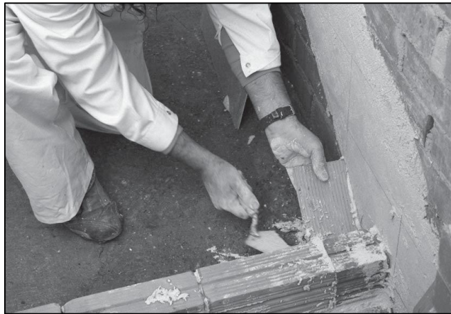
Imagen 127 . Colocación primera rasilla
