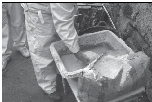
Imagen 125. Amasado tradicional del mortero
