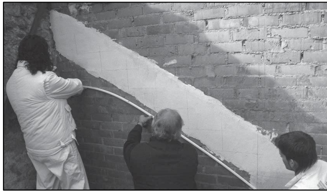
Imagen 122 Marcado de los peldaños
