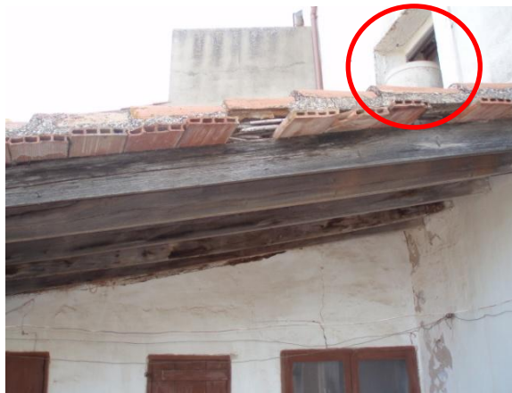
Imagen 144. Depósito de fibrocemento
