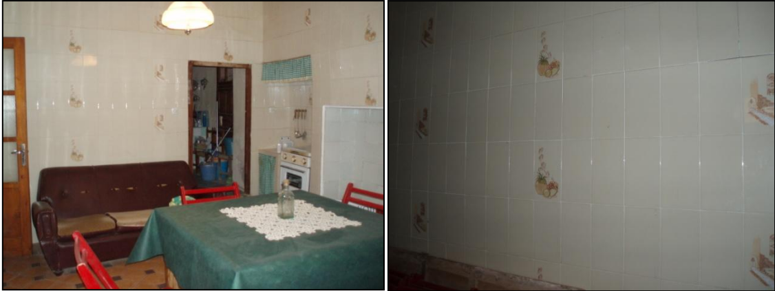
Imágenes 49 y 50. Revestimiento paredes comedor
