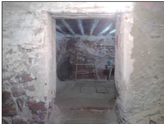
Imagen 13. Muro de carga, imagen del sótano.
