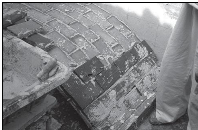
Imagen 135. Ejecución segunda rosca
