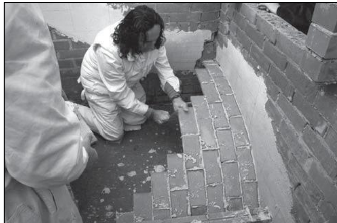
Imagen 129. Ejecución primera rosca
