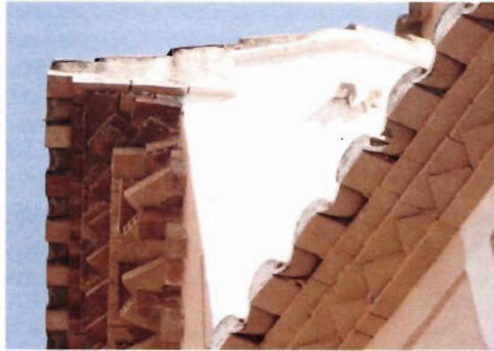
Foto 8: Ràfec de la façana principal de la construcció d'un habitatge al Pou Ample.
