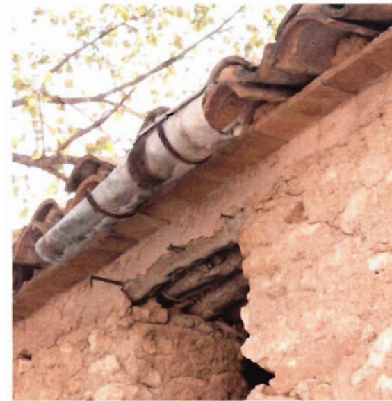
Foto 2: Ràfecs com a element sustentador per a l'ancoratge dels canalons.
