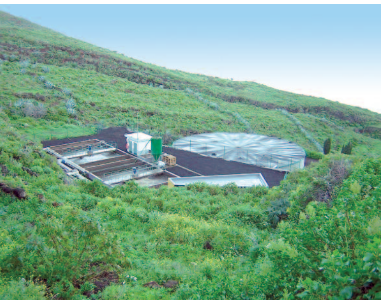
Ampliación del saneamiento y EDAR de Valverde.
