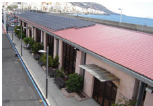
Instalación de energía fotovoltaica en el Puerto de S.C. de La Palma.
