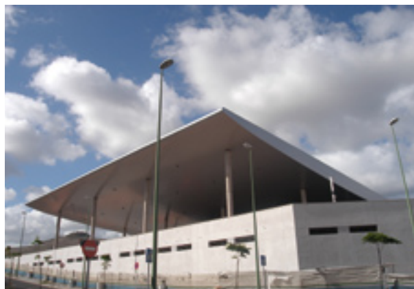
Ampliación de la Terminal en el Aeropuerto de Fuerteventura.
