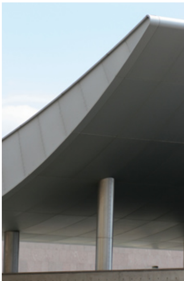
Detalle del Intercambiador de Santa Cruz de Tenerife.
