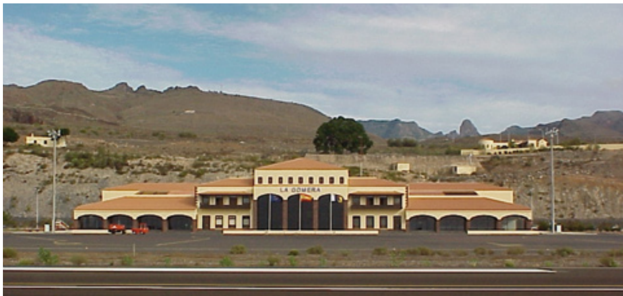
Vista de la Terminal del Aeropuerto de La Gomera, donde se realizan varias obras.
