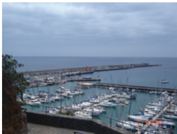
Prolongación del dique exterior del Puerto de S.S. de La Gomera.
