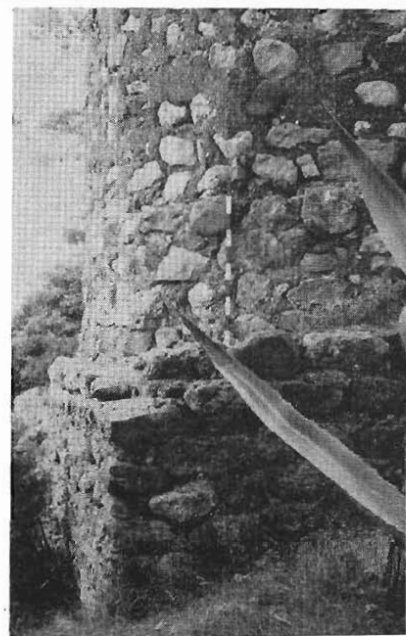
Aparejos de los lienzos amurallados y de las torres; detalle de los distintos morteros; 1. Torre NE.; 2. Muralla N.; 3. Torre N.
