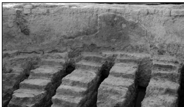
Foto 13. Vista del revoco del lado oeste.
