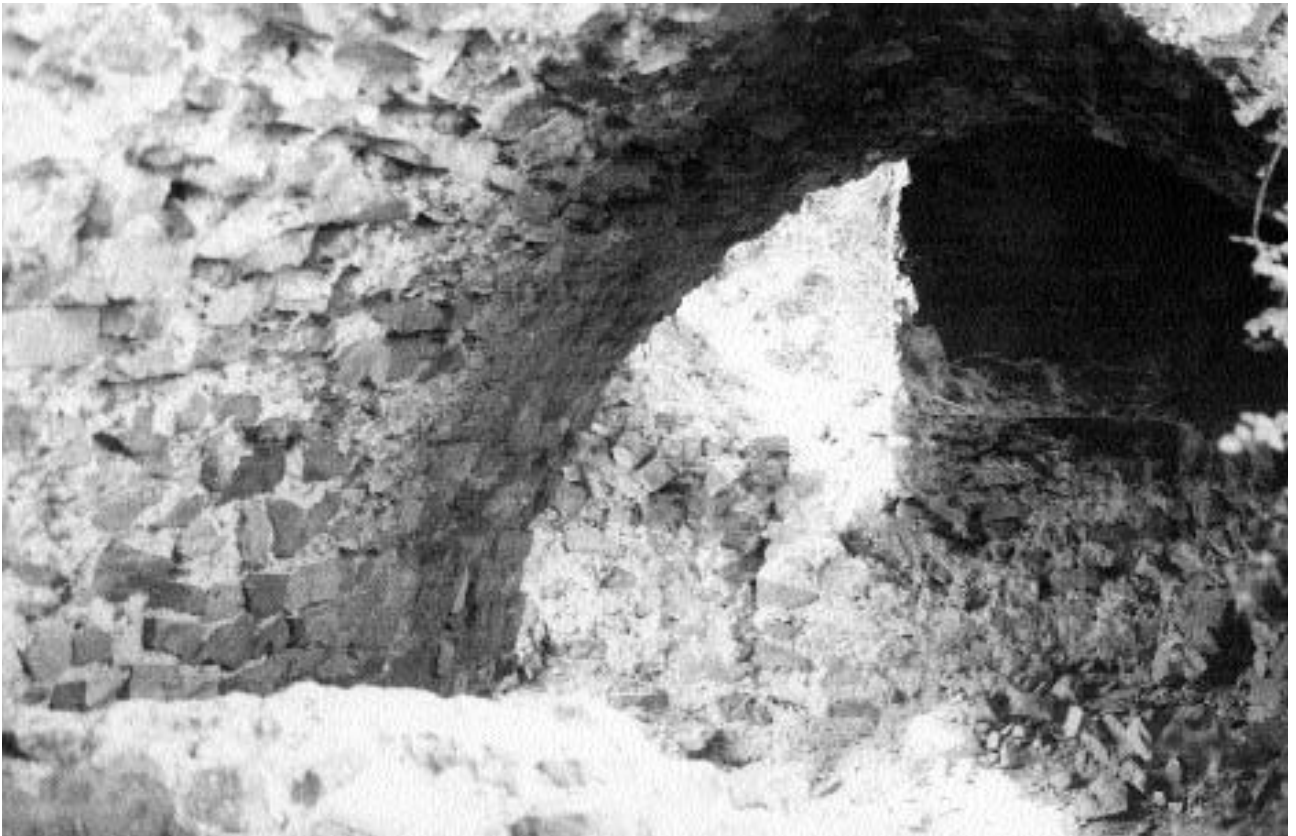
Figura 13. Shûn , sector VI/2000, vista interior del aljibe 2630.
