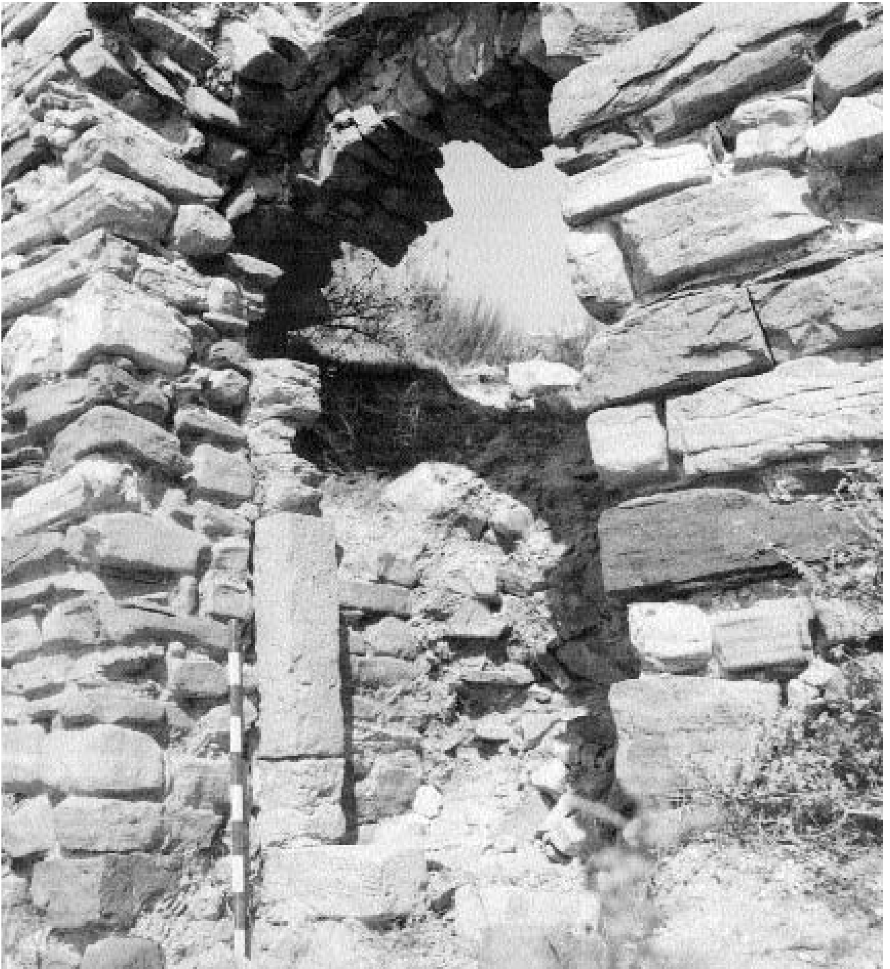
Figura 11. Shûn, sector X. Detalle de las mamposterías alrededor de la puerta número 2131 (cortina 2101); este acceso a la parte alta del asentamiento, llevaba un arco de herradura montado sobre jambas de sillares de aparejo medio regular.
