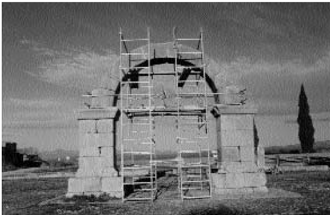
1.- Cara este del arco de Cabanes con el andamiaje de protección instalado durante los trabajos de limpieza, restauración y excavación de 1994-1995.
