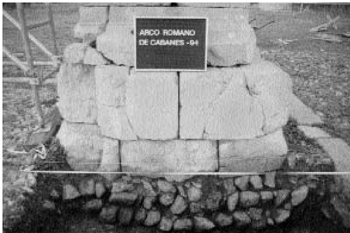
2.- Detalle de la cimentación de la pilastra norte, vista por su cara este.
