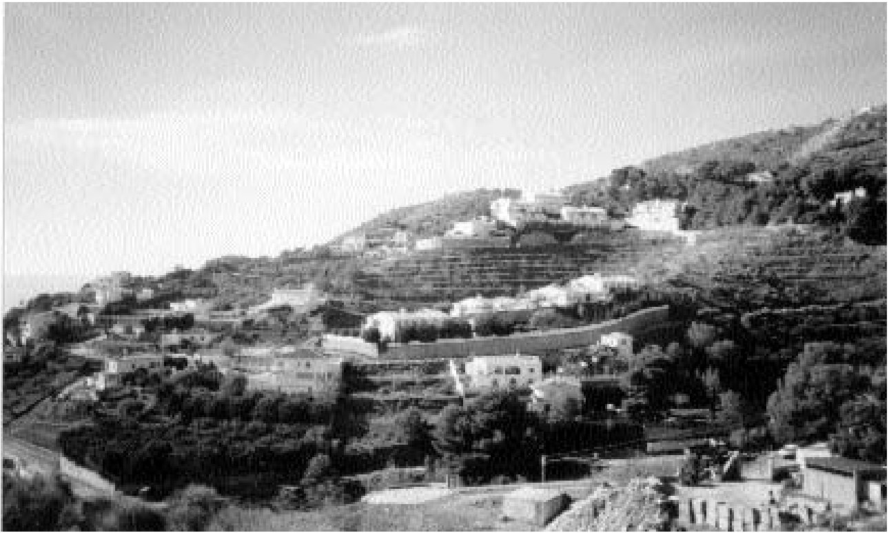
1.- Vista del yacimiento desde la carretera N-340.
