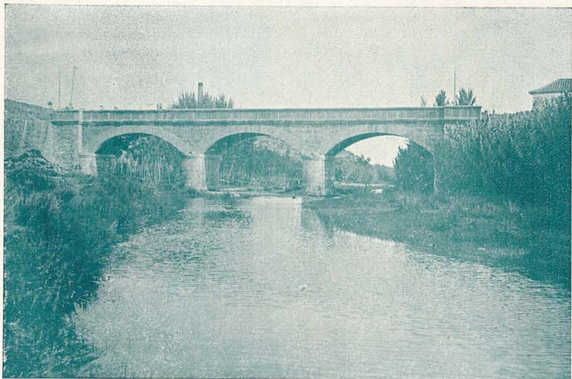
Puente sobre el río Palancia en el camino vecinal de Castelnovo a Segorbe
