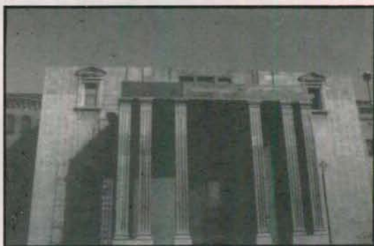
ENLUCIDO DEL TECHO SOSTENIDO POR LAS COLUMNAS DE LA FACHADA.
