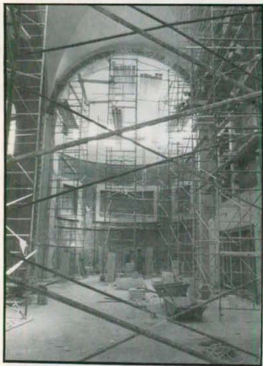
CAMARIN VISTO DESDE LA PUERTA DE ENTRADA - AGOSTO 1990
