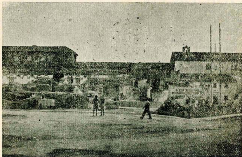
LO QUE QUEDA DEL ANTIGUO TEMPLO... UN MONTÓN DE RUÍNAS (Clisé cedido galantemente por el Sindicato Católico)
