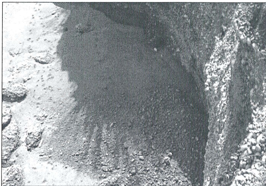
Conseqüències dels desprendiments
