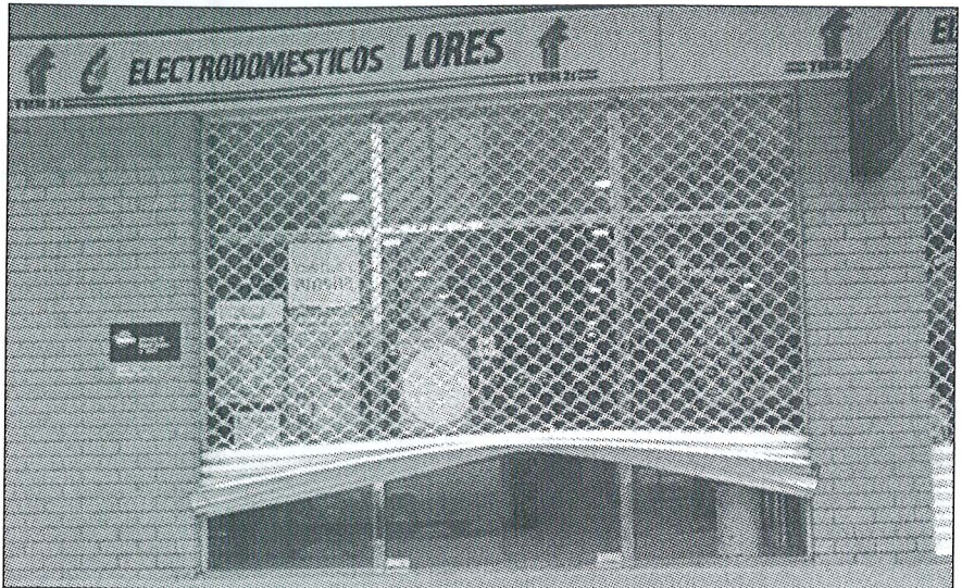
Així va quedar la tanca de protecció
