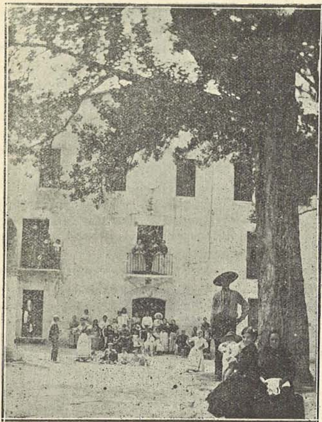
BALNEARIO DE LA AVELLÀ FACHADA DE LA FONDA Y VISTA DE LA PLAZOLETA
