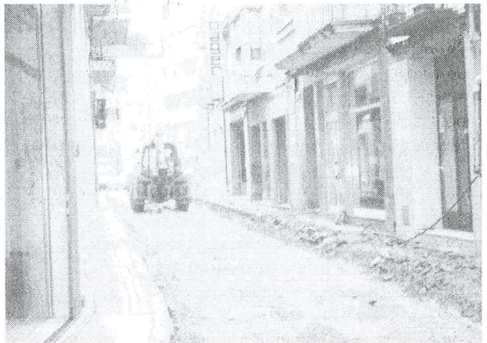
Imatge del carrer Pubill durant les obres
