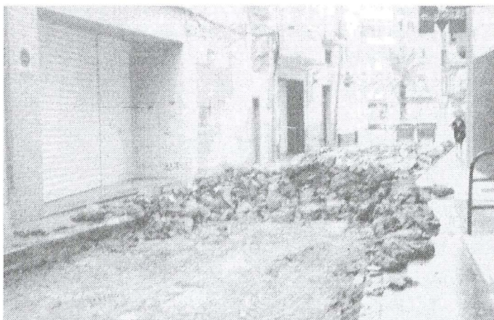
Els afectats no sabien l'inici de les obres al carrer Pubill
