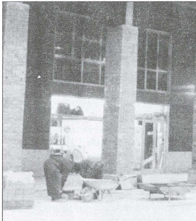
Obres al mercat
