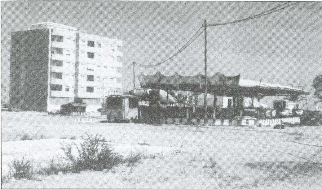
Construcció de la fira de Benicarló
