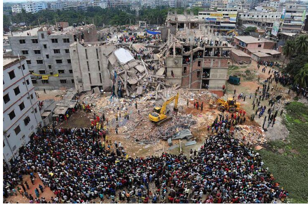
Ilustración 1. El derrumbe del Rana Plaza (El Mundo, 2018).
