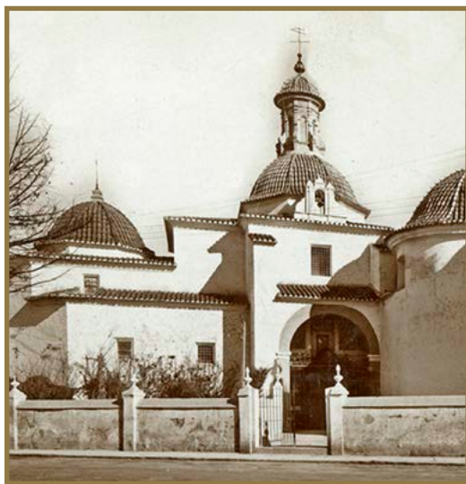
Convento del Rosario. Puerta de la Real Capilla
