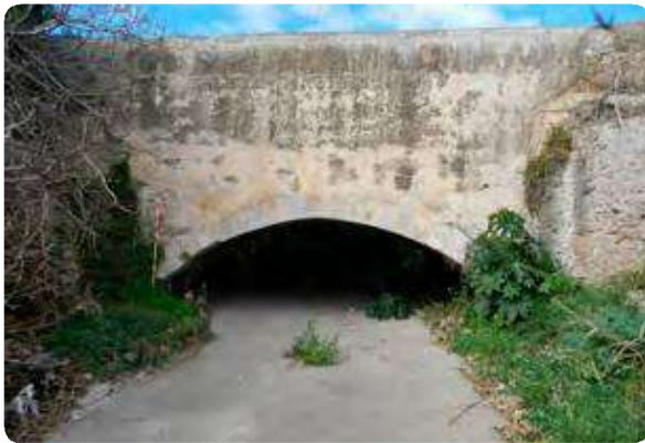
Aqüeducte sobre el barranquet d'Almassora
