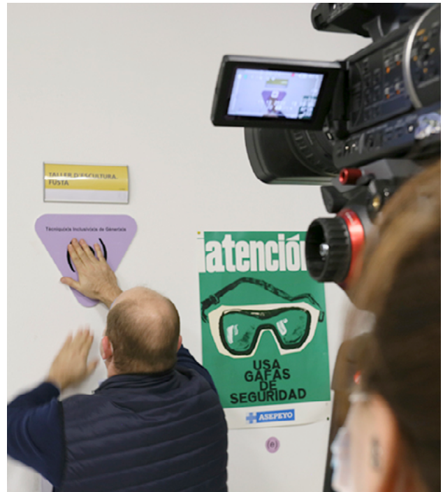
Figura 9. Colocación de señales (e) en talleres de la Facultad de Bellas Arte de Altea.
