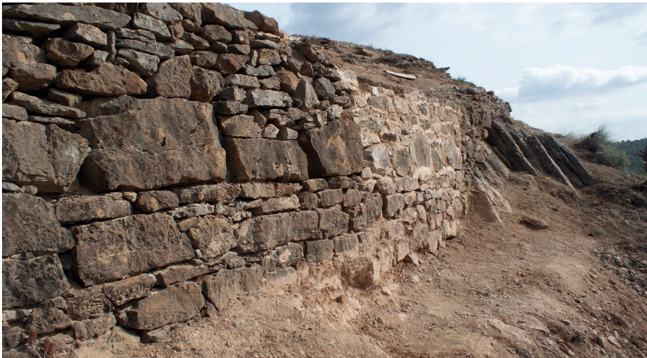
Figura 4. Vista del lienzo S de la muralla.
