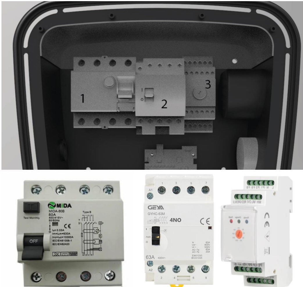
Figura 78: Explicación componentes eléctricos
