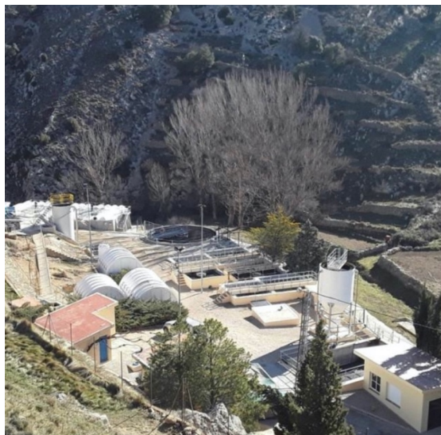
Figura M.2. Estación Depuradora de Aguas Residuales de Vilafranca del Cid. Fuente: elaboración propia
