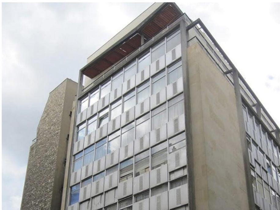
Imagen 101. Fachada multicapa con acabado exterior metálico. (Estudio UPM)
