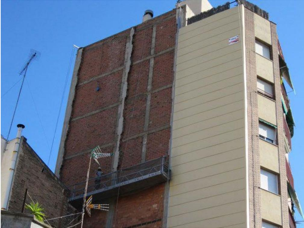
Imagen 99. Retirada de tabique pluvial de ladrillo en medianería. (Estudio UPM)
