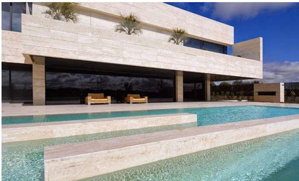
Imagen A29 - Revestimiento exterior
